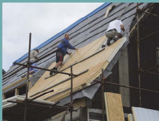
Tyto snímky dokumentují průběh pokládky střešní izolace v červenci 2011.
