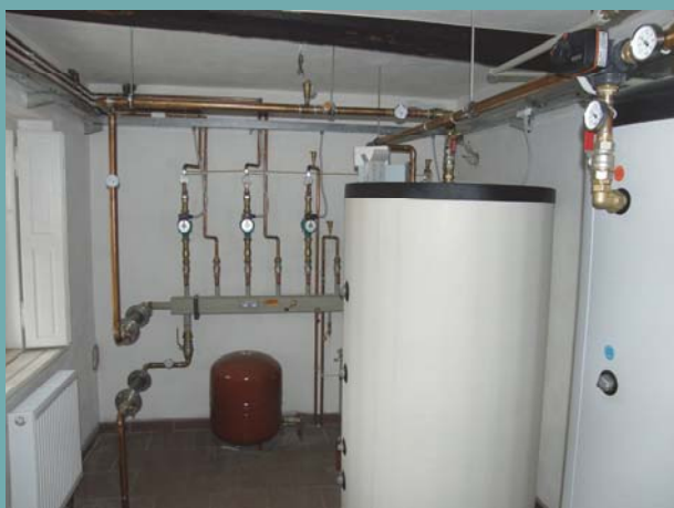
Pohled na druhou stranu technické místnosti s akumulční nádrží a boilerem po pravé straně a v pozadí s rozdělovačem a čerpadly topných okruhů včetně expanzní nádoby. Vpravo snímek z rohové místnosti v patře s instalovanými deskovými topnými radiátory.
