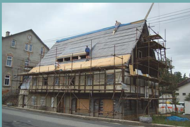
Tyto snímky dokumentují průběh pokládky střešní izolace v červenci 2011.
