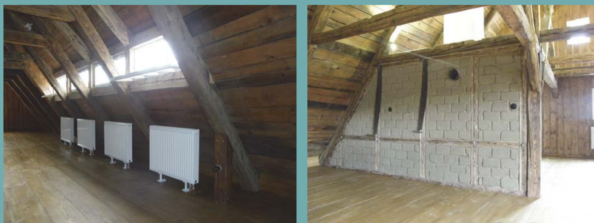
Podkrovní prostor je možné vytápět též teplovodními tělesy, umístěnými pod okny štítů a vikýře, nebo bude možné využít krbová kamna, pro které je připraveno zapojení do komína v nové hrázděné stěně, bude nutné ještě instalovat černý plech jako podklad pro kamna na dřevěné prkenné podlaze.
