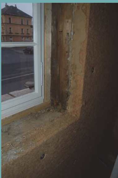
Na většinu vnějších hrázděných stěn byla obnovena nejprve vyrovnaná hliněná omítky, poté přikotvena difuzně otevřená tepelně-izolační vrstva z dřevovláknitých desek, která byla na závěr opět opatřena vnitřní hliněnou omítkou.
