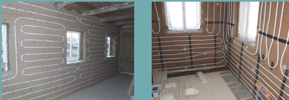
Vlevo stěnové vytápění instalované na hrázděné stěně izolované dřevovláknitými deskami domu v Lipové, vpravo obdobné řešení provedené při paralelně opravovaném domě v Cunewalde.
