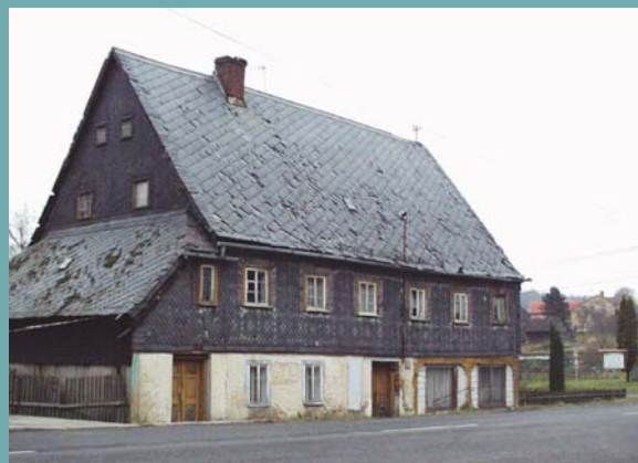
Fotografie původní břidlicové krytiny, vlevo stav k r. 1978 a vpravo před r. 2001.
