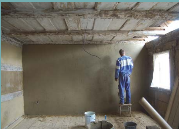
Vybrané hrázděné stěny byly ponechány v interiéru přiznané včetně dřevěné konstrukce, jinak byly většinou obnoveny souvislé hliněné omítky.
