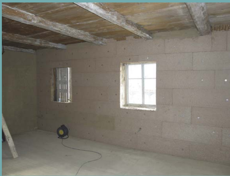
Na většinu vnějších hrázděných stěn byla obnovena nejprve vyrovnaná hliněná omítky, poté přikotvena difuzně otevřená tepelně-izolační vrstva z dřevovláknitých desek, která byla na závěr opět opatřena vnitřní hliněnou omítkou.
