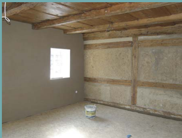
V expoziční místnosti 1.08+1.09 bylo na vnitřní dřevovláknitou izolaci vnější hrázděné stěny také přikotveno potrubí stěnového teplovodního vytápění, a to bylo poté přes výztužnou síťku opět nahozeno již finální dvouvrstvou hliněnou omítkou
