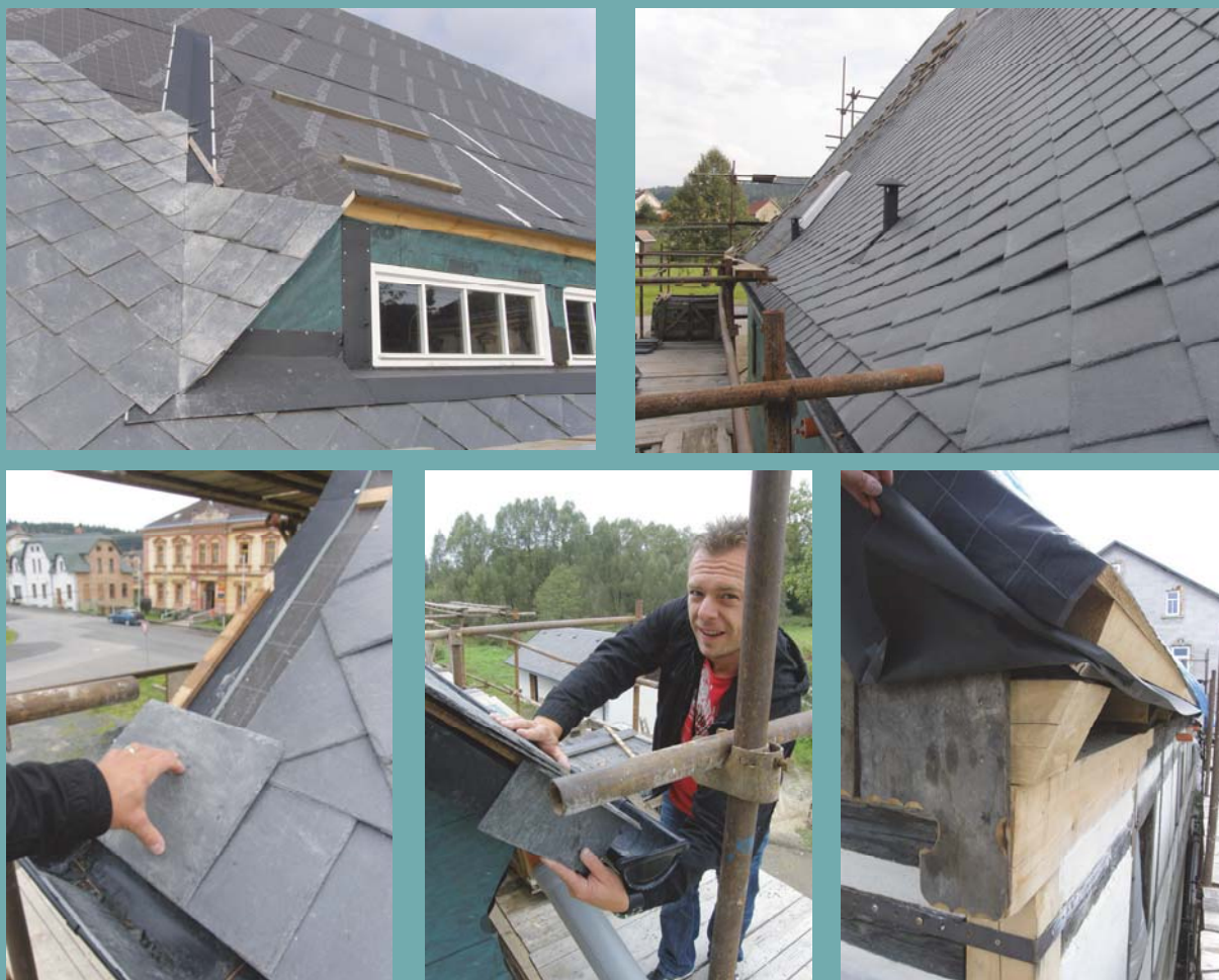
Pokládání břidlicové krytiny v srpnu a září 2011, včetně záběrů na jednotlivé řešené detaily skladby krytiny a zejména vykrytí okrajů u štítů.
