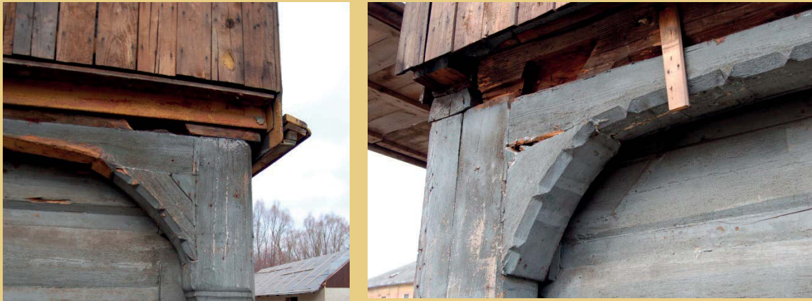
Nach dem Freilegen der Ständer wurden die Zapflöcher früherer Kopfbänder sichtbar, die später durch von den erhaltenen verzierten Knaggen und Spannriegeln abgelöst wurden.
