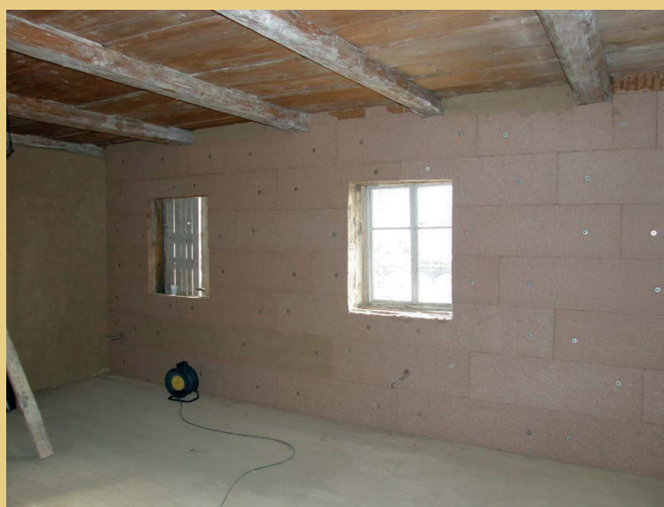
Bei den meisten Fachwerk-Außenwänden wurde zuerst ein ebener Lehmputz hergestellt und auf diesen eine Wärmedämmung aus Holzfaserplatten montiert, die abschließend mit Lehm verputzt wurde.
