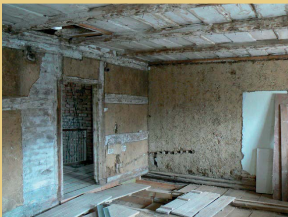
Foto links: Fachwerkwand nach der Entfernung des Wandputzes. Foto rechts: Freigelegte Ausflechtung mit Strohzöpfen an einer später ausgefachten Türöffnung. Außerdem zu sehen ist die ursprüngliche Ausfachung mit Lehmewurf auf Staken und Lehmputz.
