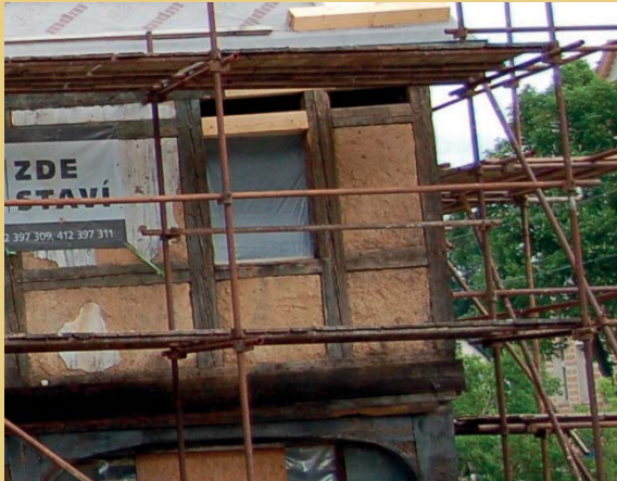
Nach dem Abschluss der Zimmermannsarbeiten wurden die beschädigten Ausfachungen und der Kalkputz instand gesetzt.
