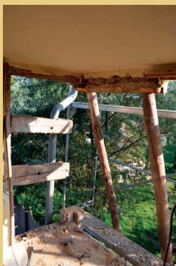
Beispiel für aufwändige Zimmermannsarbeiten bei der Instandsetzung des stark beschädigten Fachwerk-Obergeschosses eines Hauses in Jindřichovice pod Smrkem im Friedländer Zipfel mit traditionellen Techniken und Ausfachung mit Staken und Lehmewurf (Foto Zbyněk Vlk, 2012).
