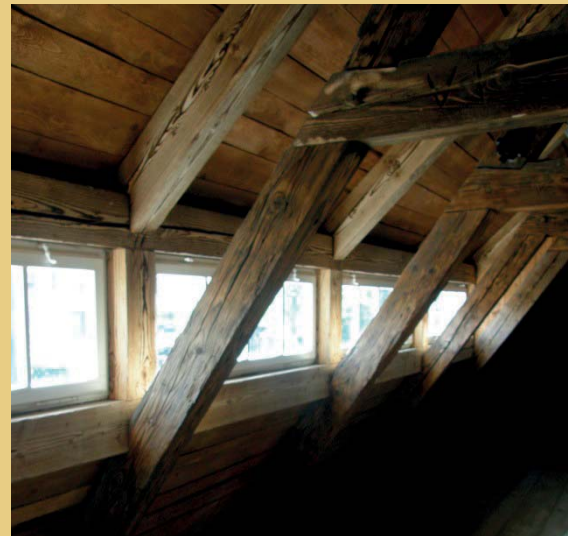
Foto links: Neuzeitliche Konstruktion der Hechtgaube aus der Zeit der letzten Dachinstandsetzung im Jahr 2002. Foto rechts: Neu erstellte Hechtgaubenkonstruktion mit auf der Gaubenpfette innen aufliegenden Gaubensparren und angeschuhtem Kehlbalken.
