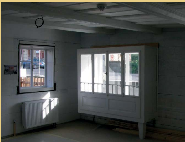
Etappen der Aufarbeitung der Auslagen für die Stube im EG. Foto links: Vorgefundener Zustand im Jahr 2005, Innenansicht. Foto rechts und Mitte: Fehlende oder beschädigte Teile der Auslagen wurden ergänzt (März 2012). Fotos unten: Innen- und Außenansicht nach dem Wiedereinbau (März 2012).
