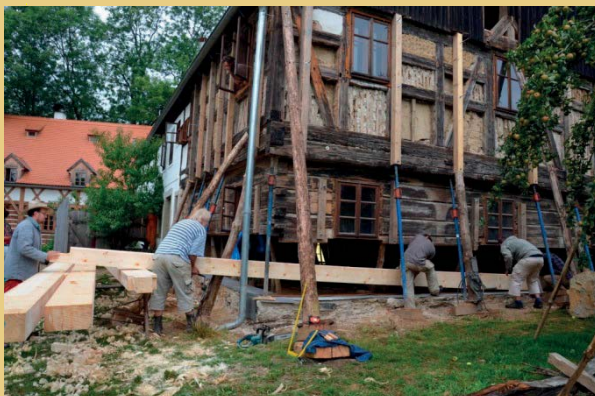
Abstützen des Fachwerkobergeschosses, Austausch der unteren Balkenlagen und Anschauen und Ergänzen der Umgebindekonstruktion mit Zapfverbindungen und Holznägeln an einem Umgebindehaus in Jindřichovice pod Smrkem bei Frýdlant. Bauausführung: Zimmermann Matouš Kirschner (Foto Zbyněk Vlk, 2012).
