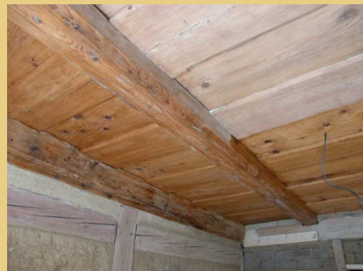
Die freigelegte Holzbalkendecke mit Einschubbrettern wurde von einem älteren Kalkanstrich befreit.
