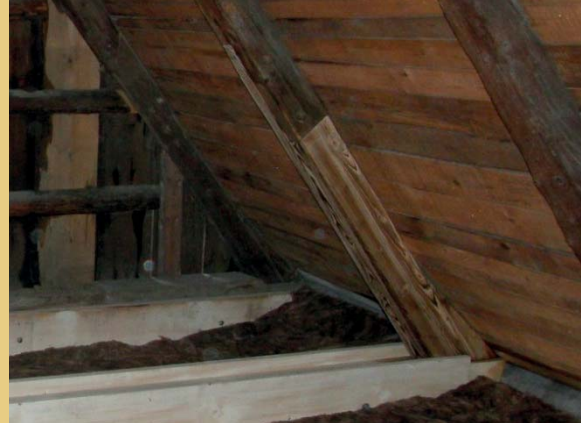
Foto links: Erneuerter Hahnenbalken und oben angeschuhte Firstpfette am Westgiebel. Foto rechts: Angeschuhter Sparren an der südlichen Traufseite. Ebenfalls zu sehen ist die Verstärkung der Deckenbalken durch beigelegte Bohlen, die gleichzeitig die Auflage des neuen Dielenfußbodens bilden.
