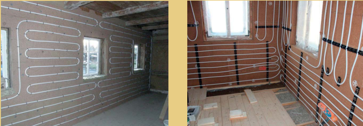
Foto links: Wandheizung auf der Fachwerkwand des Hauses Nr. 424 in Lipová. Foto rechts: Wandheizung bei einem zeitgleich sanierten Umgebindehaus in Cunewalde.
