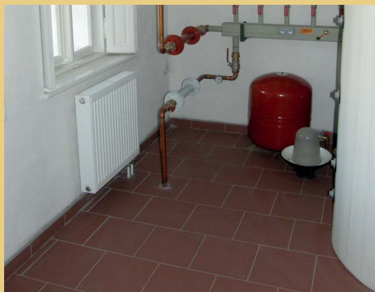
Foto links: Der neue terrakottafarbene Fliesenboden im Technikraum wurde mit halbem Versatz verlegt. Foto rechts: Neuer Dielenboden im künftigen Museum vor dem Streichen.
