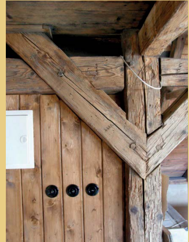
Die neue Giebelverkleidung mit Deckleisten wird von einem Gerüst aus Kanthölzern getragen. Die Verbretterung wurde ebenso wie die Wandverkleidung des WC-Einbaus aus schmalen Brettern mit einem abgetönten Holzöl behandelt.
