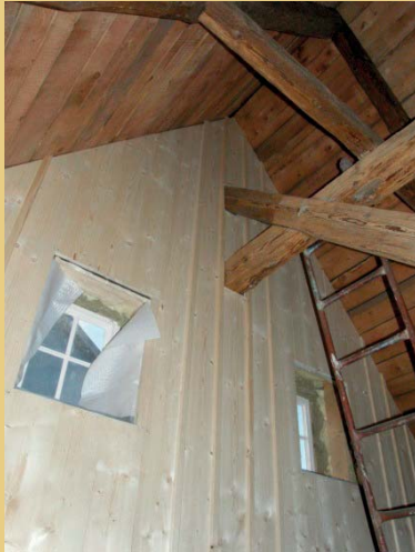
Die neue Giebelverkleidung mit Deckleisten wird von einem Gerüst aus Kanthölzern getragen. Die Verbretterung wurde ebenso wie die Wandverkleidung des WC-Einbaus aus schmalen Brettern mit einem abgetönten Holzöl behandelt.
