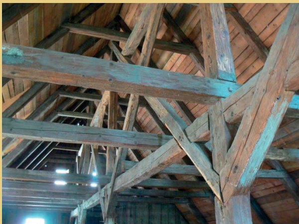
Nach der Demontage des auf den Kehlbalken aufliegenden Dielenbodens wurde der gesamte Dachraum bis hinauf zum First und die Dachstuhlkonstruktion als solche mit ihren hohen Firstsäulen und Reiterverbänden sichtbar.
