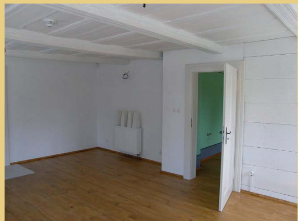
Die neu verlegten Dielenböden in der Stube und angrenzenden Nebenraum (Infozentrum) wurden eingefärbt und mit Hartwachsöl behandelt. An den Wänden wurden profilierte Fußbodenleisten verlegt (2012).
