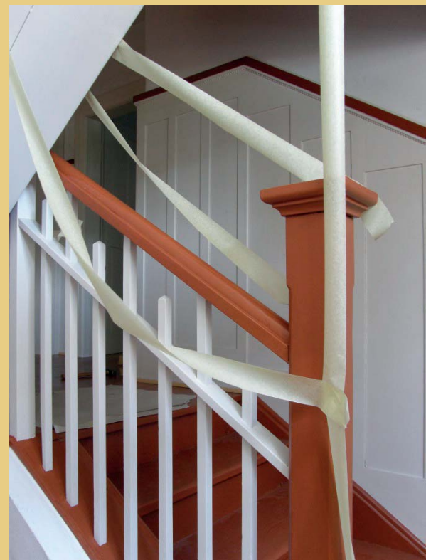
Die Fotos zeigen den Fortgang der Arbeiten an der Treppe. Foto oben: Aufarbeitung der Treppe - Entfernen der Altanstriche und Ausbesserung. Oberes Treppenende im OG. Fotos unten: Ansicht der gleichen Bereiche nach dem abschließenden Anstrich (Januar - Juli 2012).
