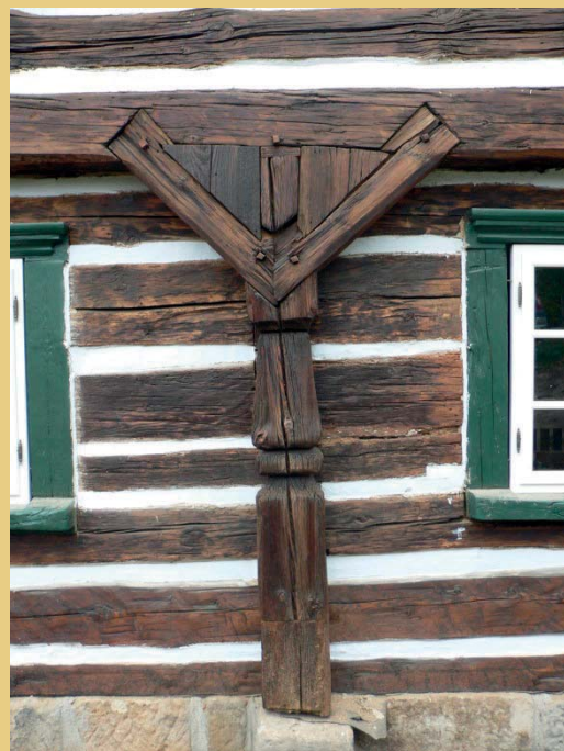
Žďár Nr. 10 (Kreis Česká Lípa, Bezirk Liberec): Beispiel für die gelungene Instandsetzung der beschädigten Blockstube und Umgebindekonstruktion durch die Firma Roman Střihavka aus Nosálov im Jahr 2010. Das linke Foto zeigt den ursprünglichen Zustand. Das Foto rechts zeigt den Zustand nach Instandsetzung des Sockels, Austausch der unteren Balkenlagen und Anschauen des verfaulten Ständerfußes. Die Balken wurden durch einen Anstrich auf Wachs-Öl-Basis optisch angeglichen.
