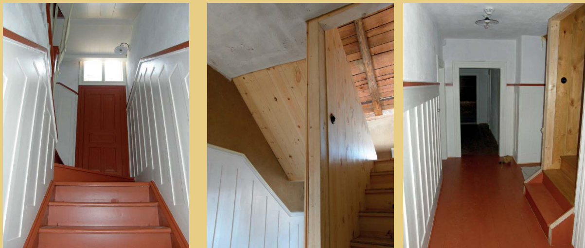
Die Bilder zeigen die aufgearbeitete und ergänzte Wandverkleidung der Treppe ins Oberschoss sowie die verwendeten Anstriche. Die neue Verkleidung der Treppe ins Dachgeschoss erhielt einen getönten Lasuranstrich.
