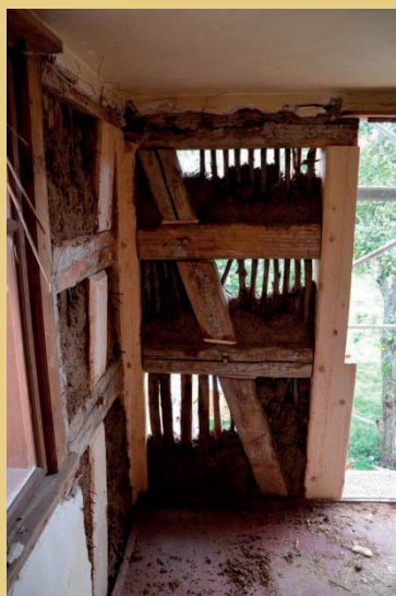
Beispiel für aufwändige Zimmermannsarbeiten bei der Instandsetzung des stark beschädigten Fachwerk-Obergeschosses eines Hauses in Jindřichovice pod Smrkem im Friedländer Zipfel mit traditionellen Techniken und Ausfachung mit Staken und Lehmewurf (Foto Zbyněk Vlk, 2012).
