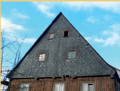
Zustand der ursprünglichen Schieferverkleidung des Giebels im Jahr 2010.
