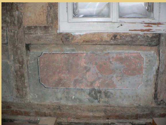
Die Fotos zeigen die freigelegte Wandmalerei an der Nordostecke des Obergeschosses und die Sanierungs- und Restaurierungsarbeiten (die Bretter stützen die wieder angebrachte Hohlkehle ab).
