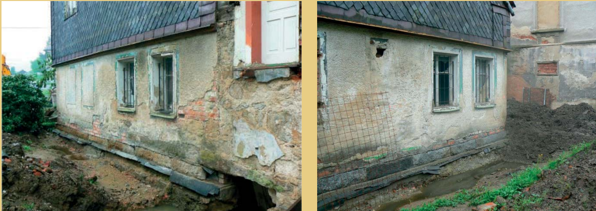
Durchgehende Feuchtigkeitssperre unter den gemauerten Wänden an der Nordseite des Hauses wegen hohem Grundwasserspiegel.
