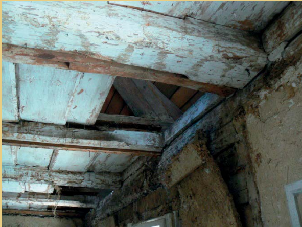
Die Fotos zeigen die durch Regenwassereintrag beschädigten Decken und Einschubbretter an der Südseite (Foto links) und an der Nordostecke des Hauses (Foto rechts).
