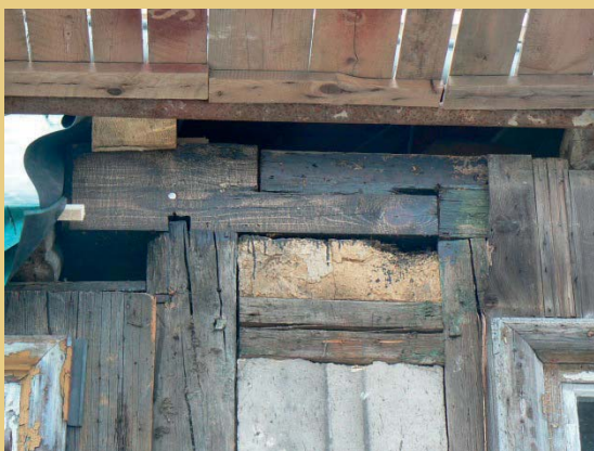
Beispiele für die Anschuhung des Fachwerkrahms. Im rechten Bild ist die stark beschädigte Ecke der Stube im Obergeschoss mit Wandbemalung zu sehen. Die Balkenoberflächen wurden nicht nachbearbeitet, da diese später von der Verbretterung und Schieferbekleidung verdeckt wurden.
