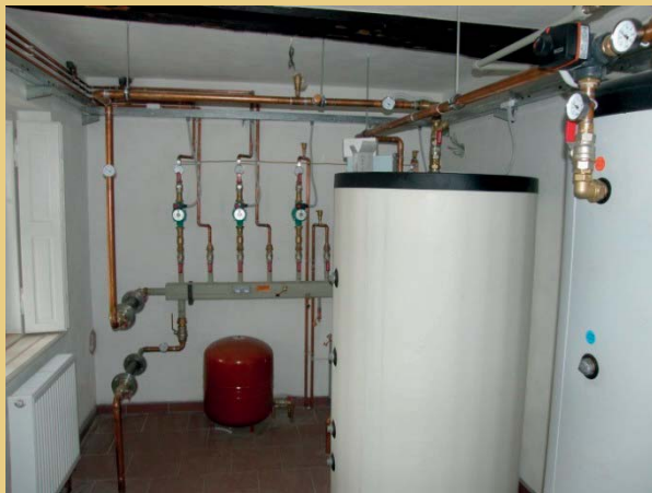
Foto links: Blick auf die andere Seite des Technikraums mit Pufferspeicher rechts. An der Stirnwand der Verteiler mit Umwälzpumpen und Ausgleichsbehälter. Foto rechts: Blick in das mit Plattenheizkörpern bestückte Eckzimmer im Obergeschoss.
