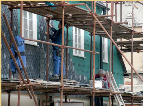
Arbeiten bei der Rekonstruktion der Schieferverkleidung, Zurichten und Verlegen der Schablonen (April bis Mai 2012)
