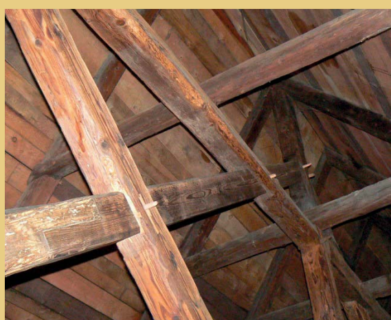
Fotos links: Zustand vor der Reparatur. Fotos rechts: Zustand nach der Reparatur. Zu sehen sind die angeschuhten Balkenteile bzw. Prothesen des Reiterverbands. Die Verbindungen wurden mit Holznägeln gesichert.
