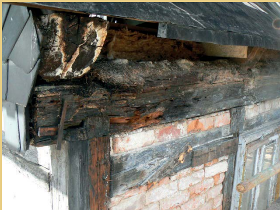
Beschädigte Balkenteile: Pilzschäden an der Nordostecke und an einem der Stiele der Südwand.
