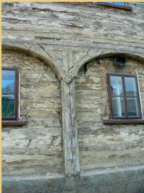
Historische Anstriche der Blockstube von Haus Nr. 95 in Sloup v Čechách (Kreis Česká Lípa, Bezirk Liberec). Foto links: Zustand im Jahr 2009. Nach dem Entfernen der Eternit-Verkleidung der Fassade wurde ein ockerfarbener Anstrich sichtbar, der Balken und Fugenverstrich im Erd- und Obergeschoss einschließlich Umgebände, Dachverkleidung und anderer Details optisch vereinheitlichte. Das Foto rechts von 2012 dokumentiert die überflüssige Entfernung des ursprünglichen Anstrichs und den Neuanstrich in einem klischeehaften Farbton. Glücklicherweise wurde ein hellbrauner Farbton und nicht die „klassische“ Schwarz-Weiß-Variante von Balken und Fugenverstrich gewählt.
