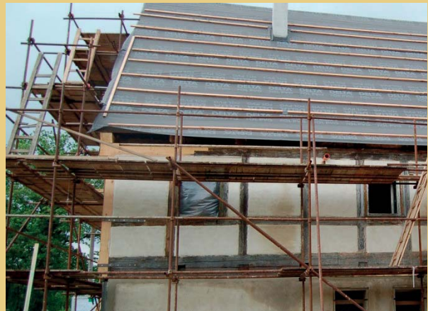
Nach dem Abschluss der Zimmermannsarbeiten wurden die beschädigten Ausfachungen und der Kalkputz instand gesetzt.
