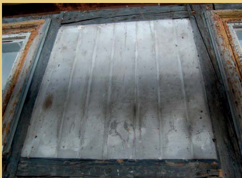
Freigelegte Fachwerkwand mit Kalkputz verputztem Gefach.
