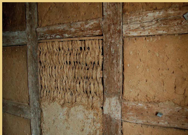
Foto links: Fachwerkwand nach der Entfernung des Wandputzes. Foto rechts: Freigelegte Ausflechtung mit Strohzöpfen an einer später ausgefachten Türöffnung. Außerdem zu sehen ist die ursprüngliche Ausfachung mit Lehmewurf auf Staken und Lehmputz.
