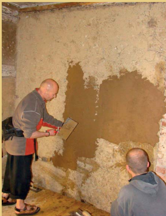
Bilder vom Lehmputz-Workshop, bei dem der zertifizierte Handwerker Thomas Kurze das Vorbereiten des Lehmputzes und das Auftragen auf die Wand vermittelte. Die Teilnehmer hatten dabei auch Gelegenheit, selbst Hand anzulegen und die Arbeit mit dem Lehmputz auszuprobieren.
