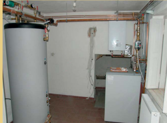
Foto links: Installationsort der Außeneinheit der Wärmepumpe neben dem Lagergebäude am Rand des Grundstücks. Foto rechts: Auf dem Fußboden des Technikraums stehend die Inneneinheit mit angeschlossenem Pufferspeicher mit Warmwasseraufbereitung und zusätzlichem Elektrokessel.
