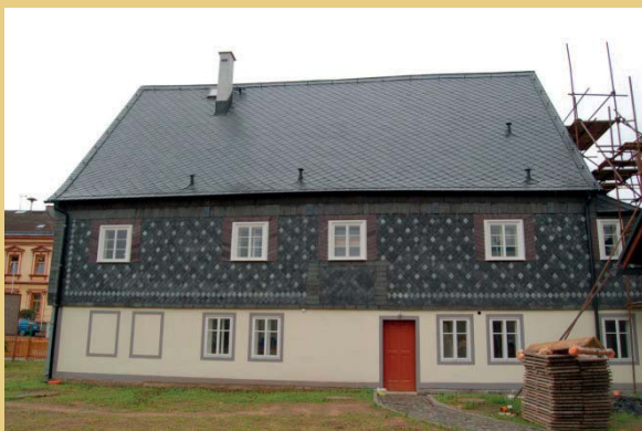
Rückseite und Straßengiebel nach der Rekonstruktion der Verschieferung (Mai bis Juli 2012)
