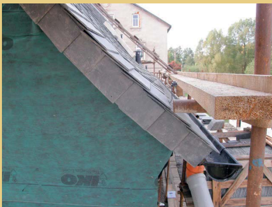
Die Eindeckung des Dachs erfolgte im August und September 2011. Die Fotos zeigen die Ausführung von einzelner Details insbesondere die Einfassung der Dachfläche und Ausführung des Ortgangs.
