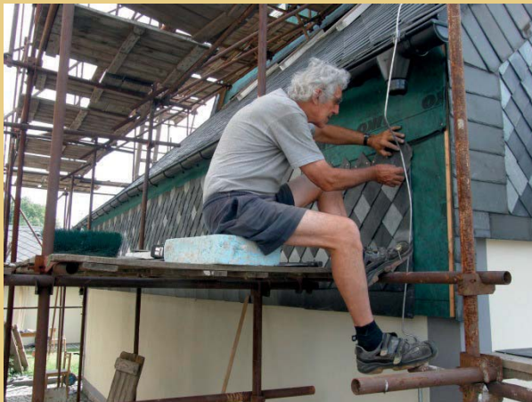
Arbeiten bei der Rekonstruktion der Schieferverkleidung, Zurichten und Verlegen der Schablonen (April bis Mai 2012)
