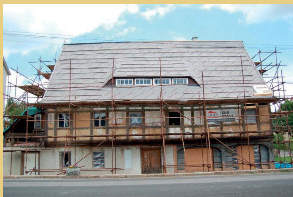
Ansicht der straßenseitigen Längsseite nach dem Freilegen des Fachwerks (April bis Mai 2012). Wie das Fotos rechts belegt, besitzt das Fachwerk hier einen älteren grünen Anstrich und weiße Putzflächen in den Gefachen.
