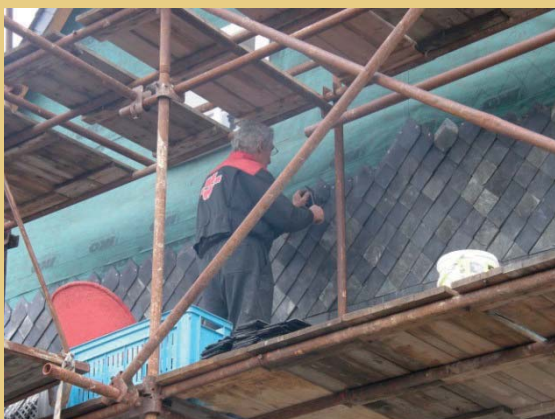
Verlauf der Rekonstruktion der Giebelverschieferung im April und Mai 2012. Das Foto unten zeigt die Arbeiten am hinteren Giebel.
