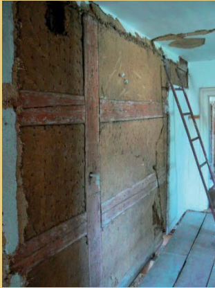
Foto links: Fachwerkwand unter Innenputz. Foto Mitte: Freigelegtes Strohgeflecht einer während einer späteren Bauphase ausgefachten Türöffnung. Foto rechts: Instant gesetzter Lehmputz an den Ausfachungen der Westwand.
