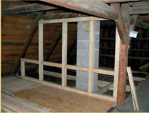
Im Ostteil des Dachgeschosses wurde eine Trennwand als Fachwerkwand mit Lehmziegelausfacht neu erstellt.
