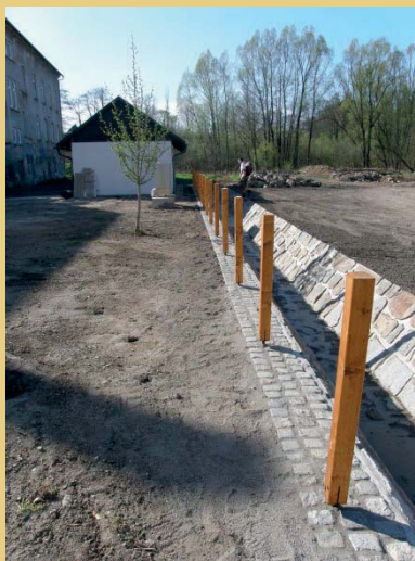
Foto links: Schotterunterbau an der Hausvorderseite. Foto Mitte: Neu gesetzte Zaunpfosten an der Nordseite des Gartens nach der Fertigstellung des neuen Entwässerungsgrabens. Foto rechts: Detail des fertigen Granitpflasters an der Südostecke des Hauses einschließlich neuem Holztor, Zaun und Granitbordstein.
