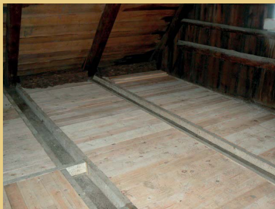
Im Dachgeschoss wurden die Dämmmatten zwischen den Kanthölzern des Ausgleichsrostes für den neu zu herzustellenden Dielenfußboden verlegt.
