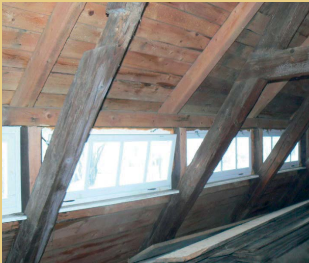
Foto links: Neuzeitliche Konstruktion der Hechtgaube aus der Zeit der letzten Dachinstandsetzung im Jahr 2002. Foto rechts: Neu erstellte Hechtgaubenkonstruktion mit auf der Gaubenpfette innen aufliegenden Gaubensparren und angeschuhtem Kehlbalken.
