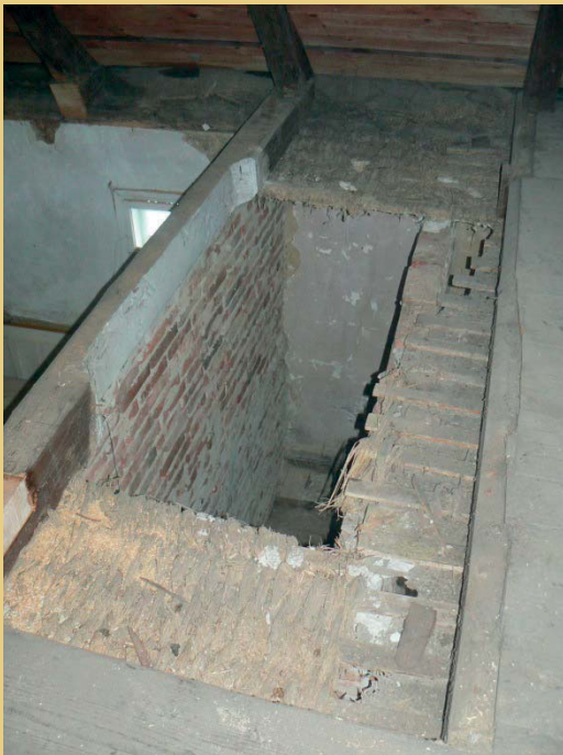
Im Bereich der ursprünglichen sehr steilen Dachbodentreppe war die aus Lehmwellern bestehende Deckenkonstruktion erhalten. Fotos rechts: Instandsetzung der Decken mit Schilfrohrmatten als Träger für die neu zu erstellenden Kalk- und Lehmputze.
