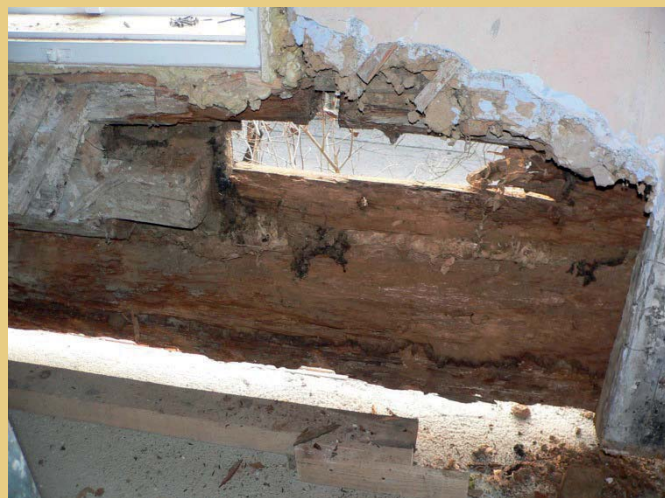
Das traurige Ende der Blockstube des Hauses Nr. 220 in Železný Brod (Kreis Jablonec nad Nisou, Bezirk Liberec). Die nur geringfügig beschädigten Blockwände wurden mit Hilfe von Gipskarton und Schwarten (Foto links) in „altertümlicher“ Manier durch äußerst schlecht gelungene Blockwandimitation verschönert. Einen weiteren Fehler stellt der unmittelbare Kontakt von Betonfußboden und Blockwand und der Ersatz fehlender Balkenteile durch Gasbetonsteine dar. Diese vollkommen ungeeigneten Maßnahmen führten bereits nach zwei Jahren zu einem massiven Hausschwammbefall in dessen Folge die Blockstube bis unter die Deckenbalken erneuert werden musste. Die Beschädigung der Balken wird auf dem rechten Foto deutlich.
