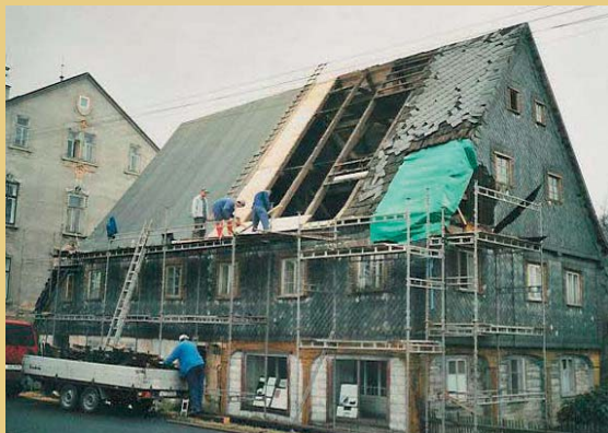
Die Fotos dokumentieren die Entfernung der ursprünglichen Schiefereindeckung im Jahr 2004 und den Zustand nach deren Wiederherstellung im Zuge der Sanierung.
