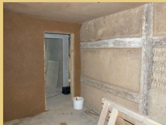
Bei ausgewählten Wänden wurde das Fachwerk als Sichtfachwerk belassen. Die übrigen Wände flächig mit Lehmputz überputzt.
