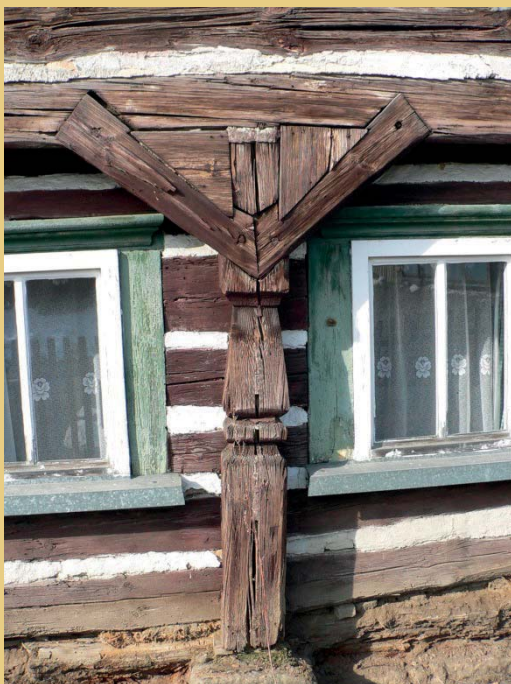
Žďár Nr. 10 (Kreis Česká Lípa, Bezirk Liberec): Beispiel für die gelungene Instandsetzung der beschädigten Blockstube und Umgebindekonstruktion durch die Firma Roman Střihavka aus Nosálov im Jahr 2010. Das linke Foto zeigt den ursprünglichen Zustand. Das Foto rechts zeigt den Zustand nach Instandsetzung des Sockels, Austausch der unteren Balkenlagen und Anschauen des verfaulten Ständerfußes. Die Balken wurden durch einen Anstrich auf Wachs-Öl-Basis optisch angeglichen.
