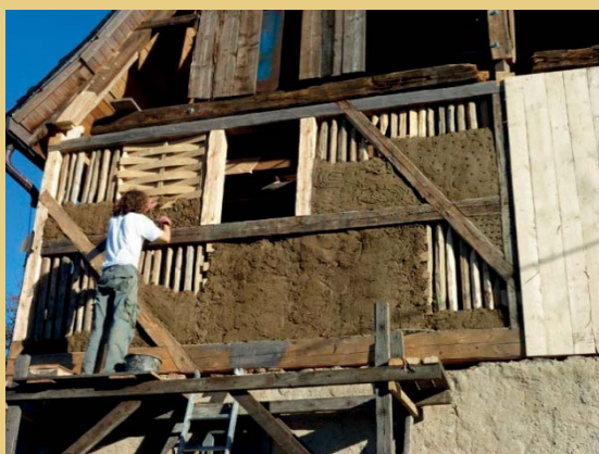
Beispielhafte Sanierung des Fachwerk-Obergeschosses des Pfarrhauses von Český Jiřetín im Erzgebirgsvorland mit angeschuhten und aufgedoppelten Balken, Ausstakung und Flechtwerk, anschließend Lehmewurf und Verputzen mit Lehmputz. Referenzfotos der zertifizierten Zimmermannshütte Tesářská hut' aus Karlovy Vary (Foto Zimmermann Roman Klouček).
