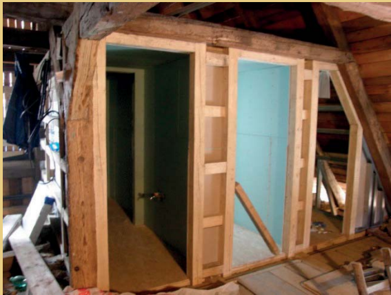
Das Holzgerüst der neuen Trennwände des WC-Einbaus wurde auf der Innenseite mit Gipskartonplatten belegt und gefliest und von außen mit einer Verbretterung verkleidet.
