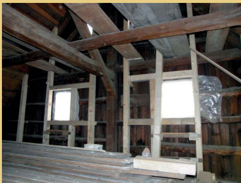
An den Giebelinnenseiten wurde ein Gerüst aus Kanthölzern als Tragkonstruktion für die neue Innenverbretterung aufgestellt. Zwischen Außen- und Innenverbretterung wurde eine Wärmedämmschicht eingebracht.
