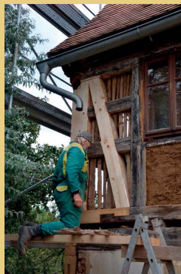
Beispiel für aufwändige Zimmermannsarbeiten bei der Instandsetzung des stark beschädigten Fachwerk-Obergeschosses eines Hauses in Jindřichovice pod Smrkem im Friedländer Zipfel mit traditionellen Techniken und Ausfachung mit Staken und Lehmewurf (Foto Zbyněk Vlk, 2012).
