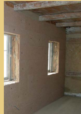
Die meisten Fachwerk-Außenwände wurden zuerst mit einem Lehmputz ausgeglichen. Danach erfolgte die Anbringung der diffusionsoffenen Holzfaser-Dämmplatten, die abschließend mit einem Lehmfeinputz versehen wurden.
