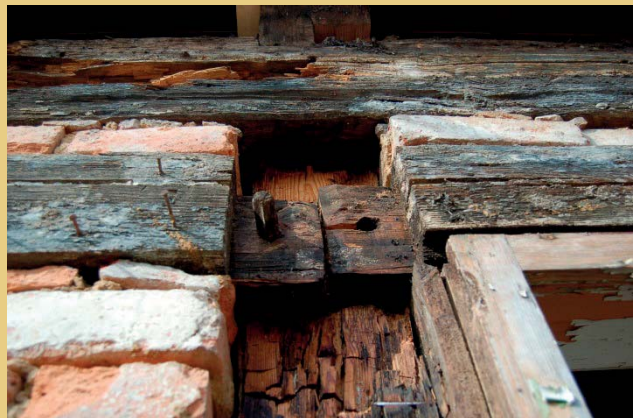
Beschädigte Balkenteile: Pilzschäden an der Nordostecke und an einem der Stiele der Südwand.
