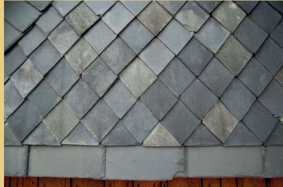
Zustand der ursprünglichen Schieferverkleidung des Giebels im Jahr 2010.
