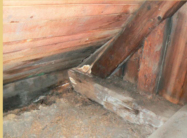
Die Fotos zeigen die durch Regenwassereintrag beschädigten Decken und Einschubbretter an der Südseite (Foto links) und an der Nordostecke des Hauses (Foto rechts).
