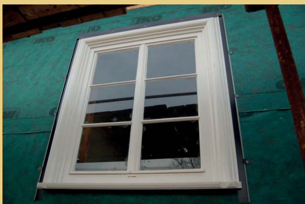
Foto links: Zustand der Fenster im OG im Jahre 2005. Foto rechts: Einbau der Fenster vor der Verschieferung der Fassade (Dezember 2011).
