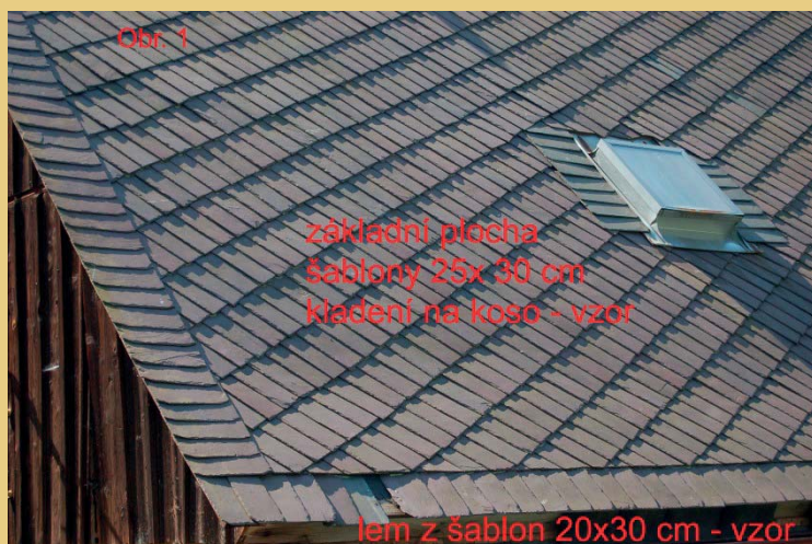
Foto links: Verlegevorlage für die Neueindeckung. (Bildbeschriftung: Plattenformat 25 x 30 cm, Rechteckdeckung, Einfassung an Traufe und Ortgang mit Platten 20 x 30 cm - Vorlage). Foto rechts: Beginn der Dachdeckerarbeiten.
