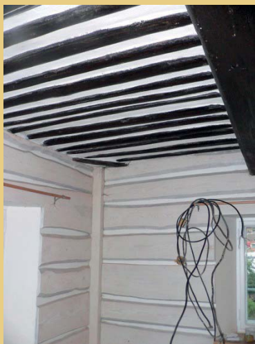
Das traurige Ende der Blockstube des Hauses Nr. 220 in Železný Brod (Kreis Jablonec nad Nisou, Bezirk Liberec). Die nur geringfügig beschädigten Blockwände wurden mit Hilfe von Gipskarton und Schwarten (Foto links) in „altertümlicher“ Manier durch äußerst schlecht gelungene Blockwandimitation verschönert. Einen weiteren Fehler stellt der unmittelbare Kontakt von Betonfußboden und Blockwand und der Ersatz fehlender Balkenteile durch Gasbetonsteine dar. Diese vollkommen ungeeigneten Maßnahmen führten bereits nach zwei Jahren zu einem massiven Hausschwammbefall in dessen Folge die Blockstube bis unter die Deckenbalken erneuert werden musste. Die Beschädigung der Balken wird auf dem rechten Foto deutlich.
