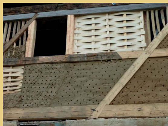
Beispielhafte Sanierung des Fachwerk-Obergeschosses des Pfarrhauses von Český Jiřetín im Erzgebirgsvorland mit angeschuhten und aufgedoppelten Balken, Ausstakung und Flechtwerk, anschließend Lehmewurf und Verputzen mit Lehmputz. Referenzfotos der zertifizierten Zimmermannshütte Tesářská hut' aus Karlovy Vary (Foto Zimmermann Roman Klouček).
