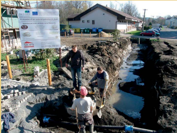
Foto links: Aufwändige Aushubarbeiten im Zuge der Herstellung von Drainage und Entwässerung im Umfeld des Hauses. Foto rechts: Blick auf den gleichen Teil der Hausumgebung nach der Herrichtung des Geländes und der Rasenaussaat.
