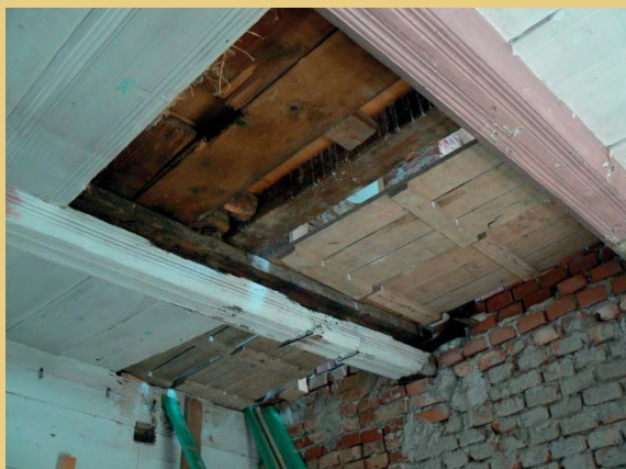
Foto links: Beschädigter Bereich der sichtbaren Einschubdecke der Stube im Erdgeschoss. Foto rechts: nach dem Entfernen der oberen losen Farbschichten erhielt die gesamte Decke flächig einem weißen Deckanstrich.
