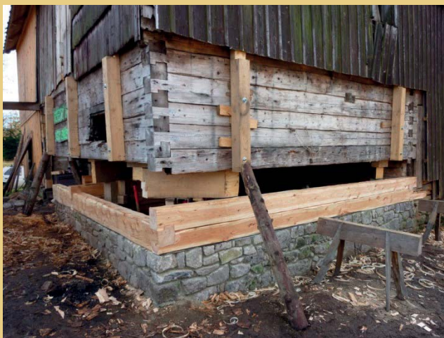
Instandsetzung einer Blockstube im Ort Přebuz im Erzgebirge mit handbehauenen Balken. Detail der Eckverbindung (Hakenblatt). Bauausführung: Zimmerei hütte Roman Klouček (Foto Roman Klouček).
