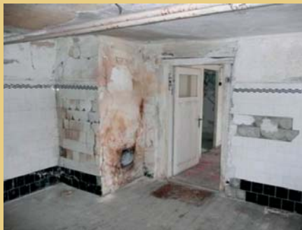
Foto links: Abgetragener Schornstein im EG, westlicher Hausteil. Foto rechts: Bau des neuen Schornsteins aus Systemsteinen im OG und Dachgeschoss, östlicher Hausteil.
