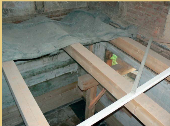
An der Südostecke des Hauses wurden die stark beschädigten Deckenbalken durch Aufdoppelungen verstärkt. Im nordöstlichen Bereich wurden alle Deckenbalken des Erdgeschosses angeschuht.
