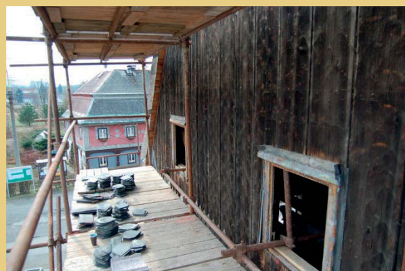
Foto links: Brettersonne nach der Demontage der Verschieferung im April 2011. Foto rechts: Demontage, Sortierung und Zwischenlagerung der Schieferplatten auf den Gerüstböden
