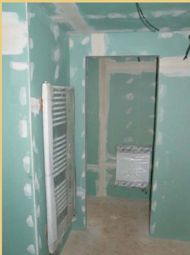
Das Holzgerüst der neuen Trennwände des WC-Einbaus wurde auf der Innenseite mit Gipskartonplatten belegt und gefliest und von außen mit einer Verbretterung verkleidet.
