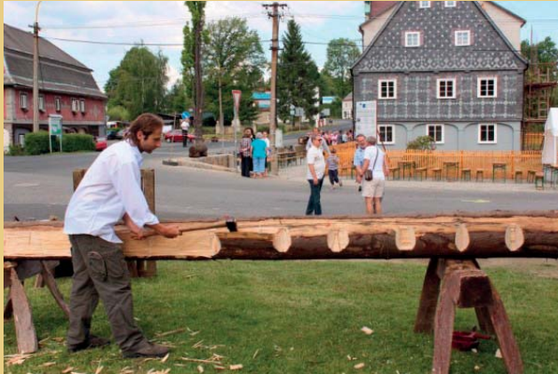
Foto links: Ein Handwerker der zertifizierten Zimmerei hütte Roman Klouček führt beim Tag der offenen Tür 2012 in Lipová vor, wie Balken von Hand behauen werden. Foto rechts: Beispiel für die Verwendung handbehauener Balken beim Wiederaufbau des abgebrannten Glockenturms der Kirche St. Jacobus der Große in Železný Brod (Kreis Jablonec nad Nisou, Bezirk Liberec). Bei dem zweiten Balken von rechts, der zur ursprünglichen Konstruktion des Glockenturms gehörte und beim Wiederaufbau wiederverwendet wurde, sind die verkohlten Schichten abgebeilt und an beschädigten Stellen neue Stücke eingesetzt und mit Holznägeln fixiert worden.
