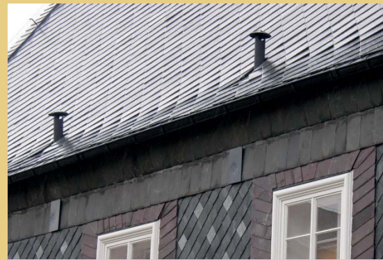
Foto links: Die Entlüftungsrohre wurden im Dachraum verkleidet. Foto rechts: Entlüftungshauben auf dem Dach. Unter dem Gesims sind die Luftaustritte der Entlüftungen der WCs im Obergeschoss erkennbar.
