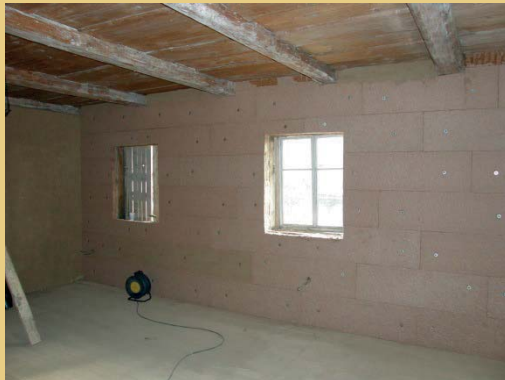
Die meisten Fachwerk-Außenwände wurden zuerst mit einem Lehmputz ausgeglichen. Danach erfolgte die Anbringung der diffusionsoffenen Holzfaser-Dämmplatten, die abschließend mit einem Lehmfeinputz versehen wurden.
