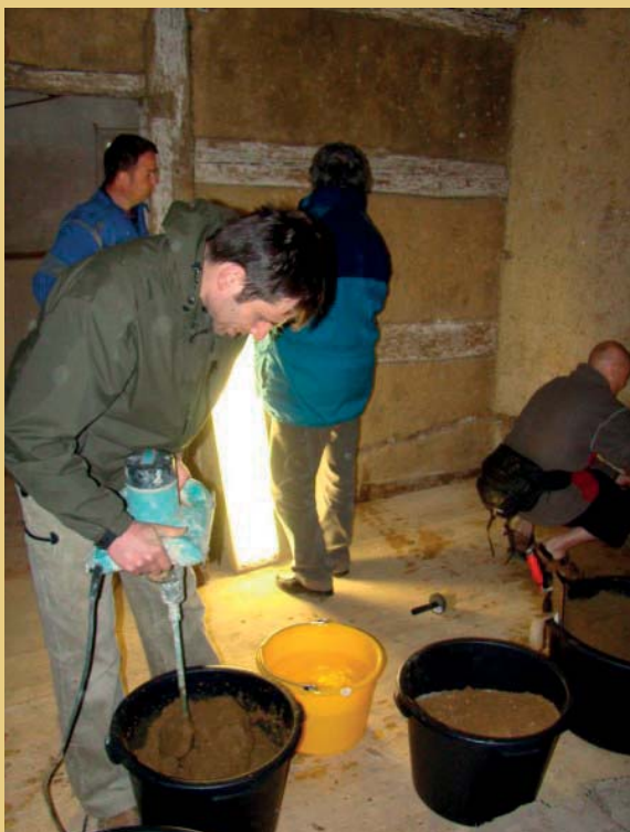
Bilder vom Lehmputz-Workshop, bei dem der zertifizierte Handwerker Thomas Kurze das Vorbereiten des Lehmputzes und das Auftragen auf die Wand vermittelte. Die Teilnehmer hatten dabei auch Gelegenheit, selbst Hand anzulegen und die Arbeit mit dem Lehmputz auszuprobieren.
