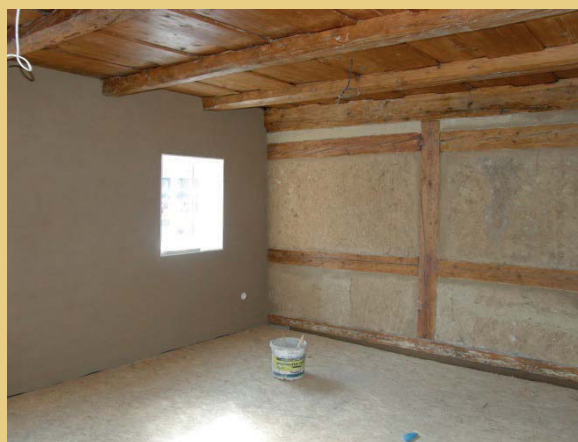
In den Museumsräumen 1.08 und 1.09 wurde eine Wandheizung auf den Dämmplatten installiert. Die Wände wurden anschließend mit einem zweischichtigen Lehmputz mit Gewebeträger verputzt.
