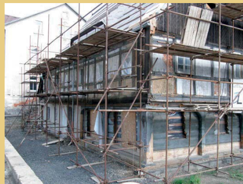
Freigelegte Fachwerkwand mit Kalkputz verputztem Gefach.
