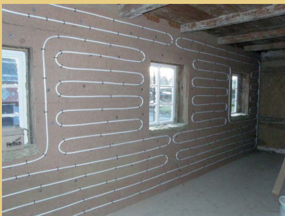
In den Museumsräumen 1.08 und 1.09 wurde eine Wandheizung auf den Dämmplatten installiert. Die Wände wurden anschließend mit einem zweischichtigen Lehmputz mit Gewebeträger verputzt.
