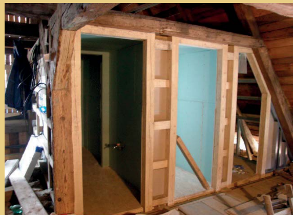
Im Westteil des Dachgeschosses wurde aus Kanthölzern das Skelett für einen neuen WC-Einbau geschaffen, der innen mit Gipskartonplatten und außen mit Brettern verkleidet wurde.
