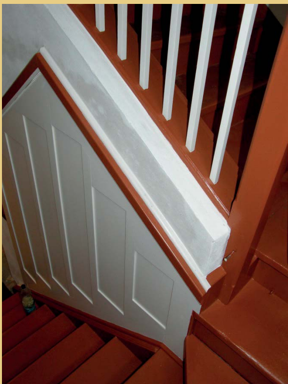
Die Fotos zeigen den Fortgang der Arbeiten an der Treppe. Foto oben: Aufarbeitung der Treppe - Entfernen der Altanstriche und Ausbesserung. Oberes Treppenende im OG. Fotos unten: Ansicht der gleichen Bereiche nach dem abschließenden Anstrich (Januar - Juli 2012).
