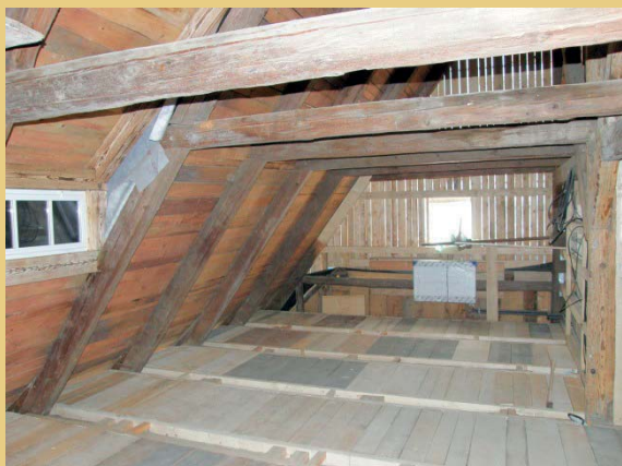
Im Dachgeschoss wurden die Dämmmatten zwischen den Kanthölzern des Ausgleichsrostes für den neu zu herzustellenden Dielenfußboden verlegt.
