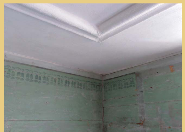
Auf den glatten Blockwänden im Erdgeschoss wurde im künftigen Büro neben dem Infozentrum eine ursprüngliche grüne Schablonenmalerei entdeckt und gesäubert. Diese wurde andeutungsweise auch an den ausgewechselten Balkenlagen und der benachbarten Ziegelwand mit Kalkputz ergänzt. Die Stuckdecke wurde mit Kalkputz verputzt und entsprechend erhaltener Stuckfragmente rekonstruiert.
