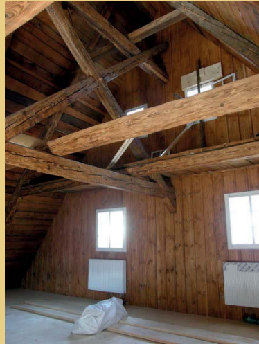
Die neue Giebelverkleidung mit Deckleisten wird von einem Gerüst aus Kanthölzern getragen. Die Verbretterung wurde ebenso wie die Wandverkleidung des WC-Einbaus aus schmalen Brettern mit einem abgetönten Holzöl behandelt.
