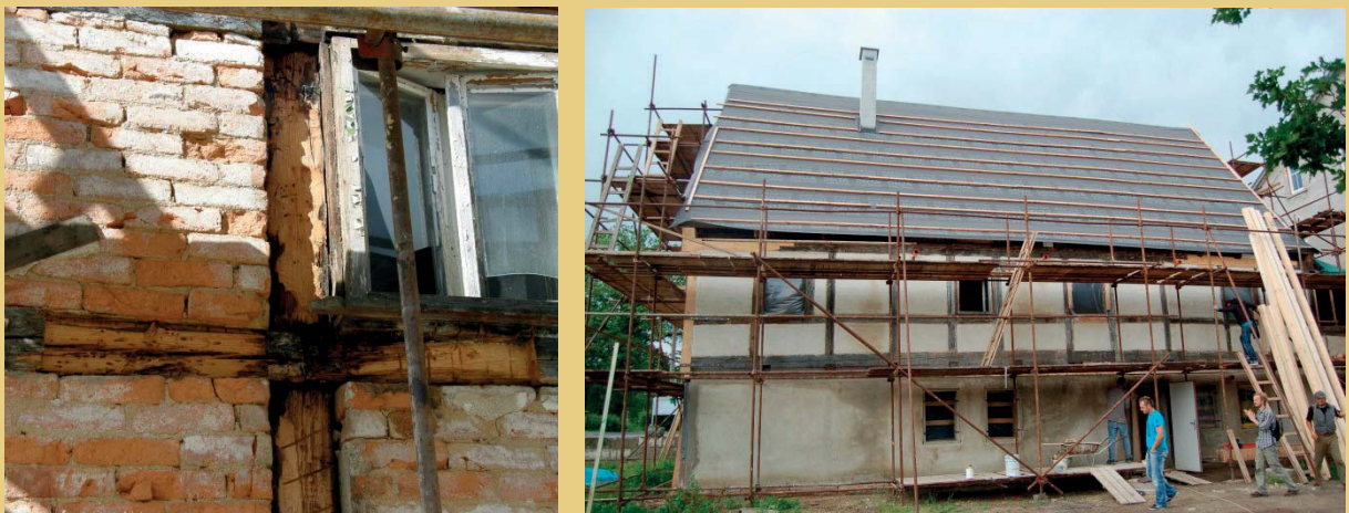
Die Balken an der NO-Ecke des Hauses wurden auf Grund der wertvollen Wandbemalung im Obergeschoss nur auf der Fassadenseite ausgebessert. Das Foto rechts zeigt den Zustand nach der Instandsetzung der Tragkonstruktion und des Kalkputzes der Gefache.
