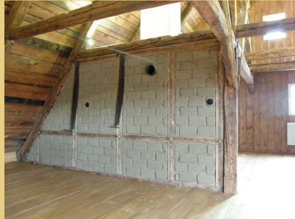
Im Ostteil des Dachgeschosses wurde eine Trennwand als Fachwerkwand mit Lehmziegelausfacht neu erstellt.
