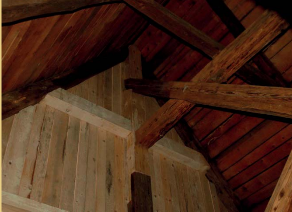
Foto links: Erneuerter Hahnenbalken und oben angeschuhte Firstpfette am Westgiebel. Foto rechts: Angeschuhter Sparren an der südlichen Traufseite. Ebenfalls zu sehen ist die Verstärkung der Deckenbalken durch beigelegte Bohlen, die gleichzeitig die Auflage des neuen Dielenfußbodens bilden.
