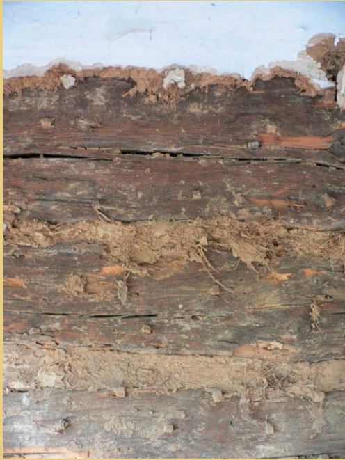
Diese zwei Beispiele belegen, dass zumindest in der letzten Bauphase der Häuser bereits beim Fugenverstrich mit Lehm-Strohhäcksel-Gemisch ein Verputzen der Wände mit Lehmputz in Erwägung gezogen wurde. Die Füllung wurde nicht einmal geglättet, damit diese eine homogene Einheit mit der aufzutragenden Putzschicht eingehen kann, die wie auch an den Fugen von Holznägeln getragen wurde. Foto links: Žďár v Podbezdězí Nr. 7 (Kreis Česká Lípa, Bezirk Liberec). Foto rechts: Flur eines Altenteils/ Speichers des Hofes Nr. 3 in Ždírecký Důl (Kreis Česká Lípa, Bezirk Liberec).
