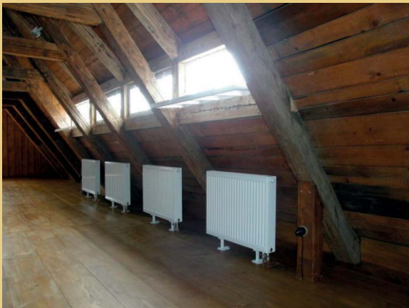
Der Dachboden kann entweder mit den unter dem Giebel bzw. der Gaube befindlichen Plattenheizkörpern oder einem Kaminofen beheizt werden, für den in der neuen Fachwerkwand ein Schornsteinanschluss vorgesehen wurde. Zuvor muss jedoch noch ein Ofenblech installiert werden.
