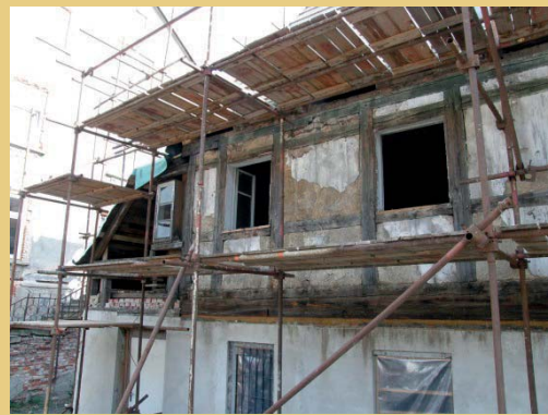
Nach dem Abnehmen und Einlagern der Schieferverkleidung und Entfernen der Verbretterung lagen die Fachwerkwände frei.
