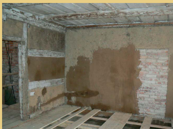
Foto links: Fachwerkwand nach der Entfernung des Wandputzes. Foto rechts: Freigelegte Ausflechtung mit Strohzöpfen an einer später ausgefachten Türöffnung. Außerdem zu sehen ist die ursprüngliche Ausfachung mit Lehmewurf auf Staken und Lehmputz.
