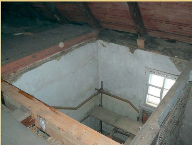
Foto links: Deckendurchbruch für die neue Treppe (2011). Foto rechts: Ursprüngliches Aussehen der Dachbodentreppe (2010).
