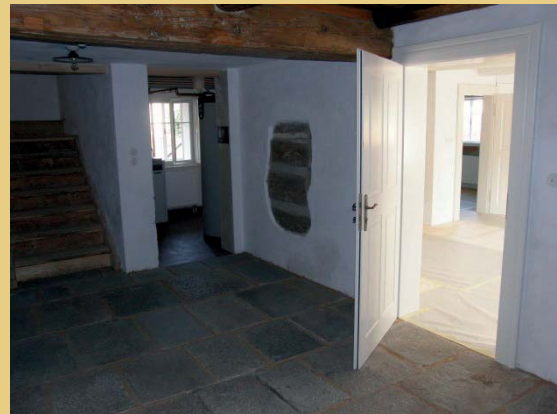
Foto links: Bei den Ziegelwänden im Erdgeschoss wurde der Kalkputz erneuert und mit Kalkanstrich versehen, hier einer der künftigen Museumsräume. Foto rechts: Hausflur mit Blockwand zum Infozentrum. Die Blockwand wurde auf Grund der Vorgabe zwei Brandabschnitte voneinander zu trennen beidseitig mit einem Lehmputz versehen und einem Kalkanstrich gestrichen.
