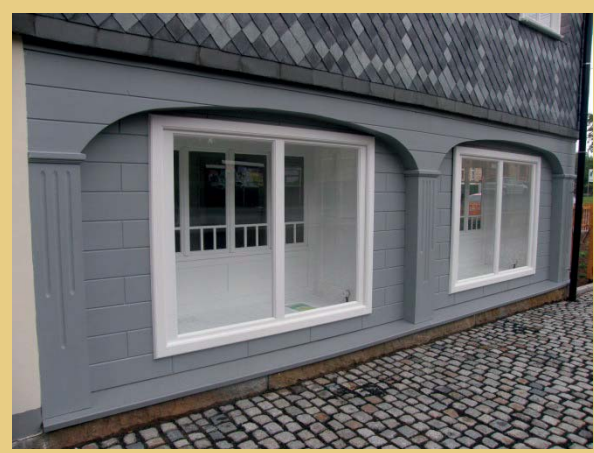
Etappen der Aufarbeitung der Auslagen für die Stube im EG. Foto links: Vorgefundener Zustand im Jahr 2005, Innenansicht. Foto rechts und Mitte: Fehlende oder beschädigte Teile der Auslagen wurden ergänzt (März 2012). Fotos unten: Innen- und Außenansicht nach dem Wiedereinbau (März 2012).
