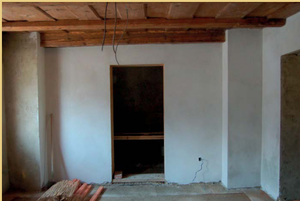
Foto links: Bei den Ziegelwänden im Erdgeschoss wurde der Kalkputz erneuert und mit Kalkanstrich versehen, hier einer der künftigen Museumsräume. Foto rechts: Hausflur mit Blockwand zum Infozentrum. Die Blockwand wurde auf Grund der Vorgabe zwei Brandabschnitte voneinander zu trennen beidseitig mit einem Lehmputz versehen und einem Kalkanstrich gestrichen.
