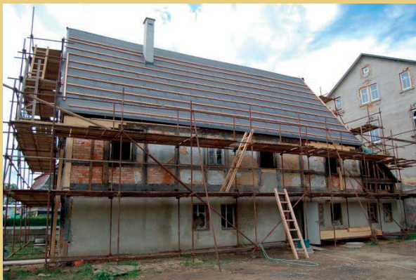
Ansicht der Hausrückseite nach dem Freilegen der Fachwerkwände im Obergeschoss (03 - 05/2012). Wie das Foto rechts zeigt, ist am Fachwerk ein jüngerer graublauer Anstrich und in den Gefachen ein hellgrauer Anstrich mit dunklem Einfassungstreifen erhalten. Auf dem Foto links sind, vor allem im Bereich der Stube mit Wandbemalung (drei Felder ganz links), Ziegelausfachungen zu erkennen. Die übrigen Gefache sind ausgestakt, mit Stroh ausgeflochten und mit Lehm verstrichen.
