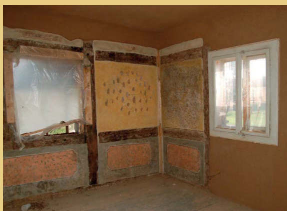
Foto links: Detail der restauratorisch gesicherten Malereifragmente an den Fachwerkbalken. Foto rechts: Ergänzung der fehlenden Putzflächen mit Lehmputz
