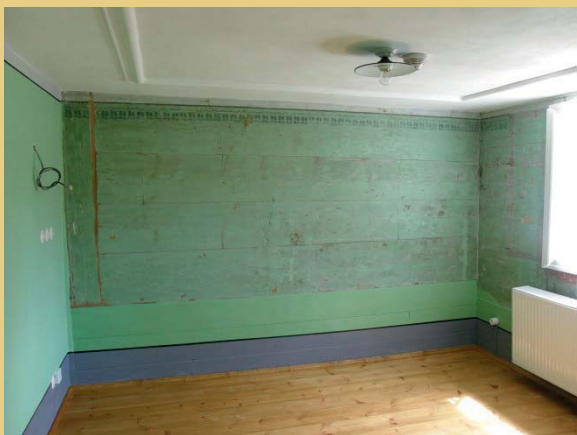
Die neu verlegten Dielenböden in der Stube und angrenzenden Nebenraum (Infozentrum) wurden eingefärbt und mit Hartwachsöl behandelt. An den Wänden wurden profilierte Fußbodenleisten verlegt (2012).
