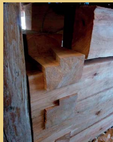
Instandsetzung einer Blockstube im Ort Přebuz im Erzgebirge mit handbehauenen Balken. Detail der Eckverbindung (Hakenblatt). Bauausführung: Zimmerei hütte Roman Klouček (Foto Roman Klouček).
