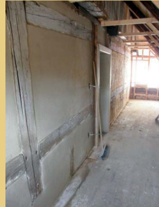
Foto links: Fachwerkwand unter Innenputz. Foto Mitte: Freigelegtes Strohgeflecht einer während einer späteren Bauphase ausgefachten Türöffnung. Foto rechts: Instant gesetzter Lehmputz an den Ausfachungen der Westwand.
