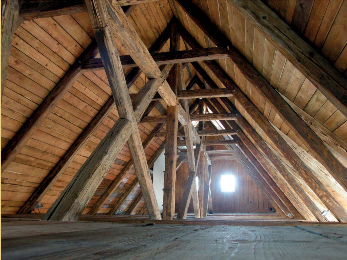
Ansicht des oberen Teils des Dachraums von dem wieder auf den Kehlbalken am Westgiebel eingebauten Zwischenboden aus mit Blickrichtung nach Osten.
