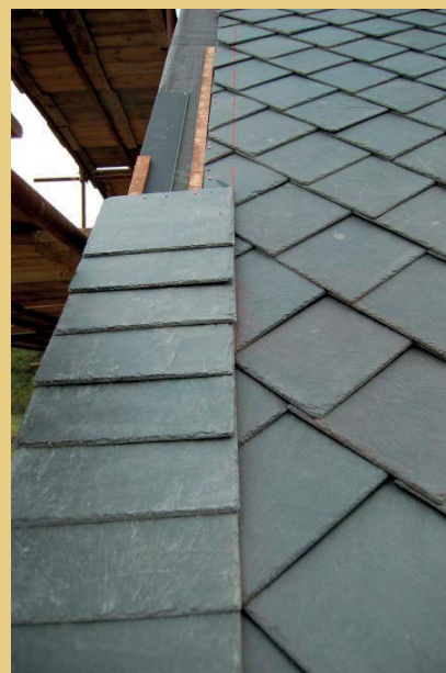
Foto links: Verlegevorlage für die Neueindeckung. (Bildbeschriftung: Plattenformat 25 x 30 cm, Rechteckdeckung, Einfassung an Traufe und Ortgang mit Platten 20 x 30 cm - Vorlage). Foto rechts: Beginn der Dachdeckerarbeiten.
