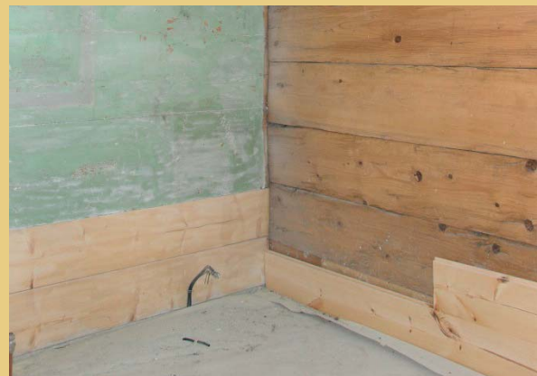
Foto links: Bei den Ziegelwänden im Erdgeschoss wurde der Kalkputz erneuert und mit Kalkanstrich versehen, hier einer der künftigen Museumsräume. Foto rechts: Hausflur mit Blockwand zum Infozentrum. Die Blockwand wurde auf Grund der Vorgabe zwei Brandabschnitte voneinander zu trennen beidseitig mit einem Lehmputz versehen und einem Kalkanstrich gestrichen.
