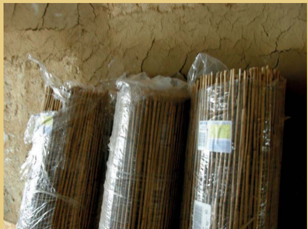
Im Bereich der ursprünglichen sehr steilen Dachbodentreppe war die aus Lehmwellern bestehende Deckenkonstruktion erhalten. Fotos rechts: Instandsetzung der Decken mit Schilfrohrmatten als Träger für die neu zu erstellenden Kalk- und Lehmputze.
