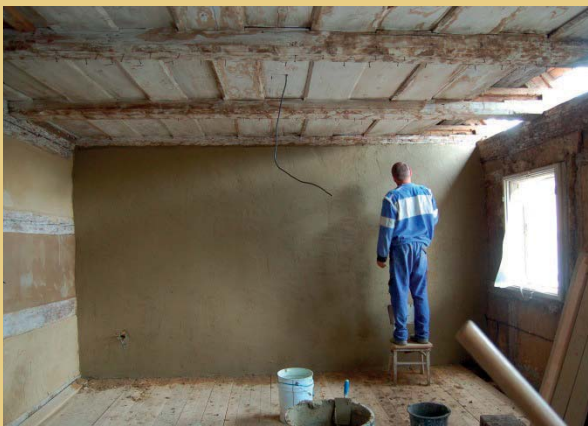
Bei ausgewählten Wänden wurde das Fachwerk als Sichtfachwerk belassen. Die übrigen Wände wurden zum Großteil flächig neu verputzt.
