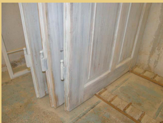
Foto links oben: Ursprünglicher Zustand einer Zimmertür im Obergeschoss (2011). Die übrigen Fotos zeigen den Zustand nach der Entfernung der Altanstriche, örtlichen Ausbesserung und neuem Grundanstrich (Februar 2012).
