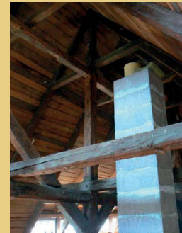
Foto links: Abgetragener Schornstein im EG, westlicher Hausteil. Foto rechts: Bau des neuen Schornsteins aus Systemsteinen im OG und Dachgeschoss, östlicher Hausteil.
