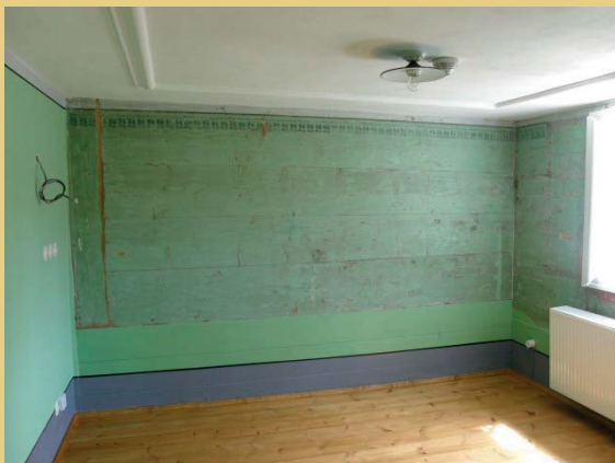
Auf den glatten Blockwänden im Erdgeschoss wurde im künftigen Büro neben dem Infozentrum eine ursprüngliche grüne Schablonenmalerei entdeckt und gesäubert. Diese wurde andeutungsweise auch an den ausgewechselten Balkenlagen und der benachbarten Ziegelwand mit Kalkputz ergänzt. Die Stuckdecke wurde mit Kalkputz verputzt und entsprechend erhaltener Stuckfragmente rekonstruiert.
