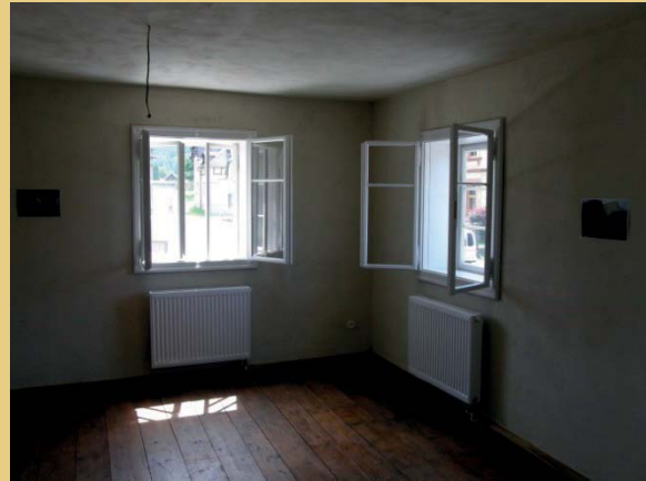
Ausgewählte Wände und Räume wurden in natürlichem lehmfarbenem Zustand belassen. Auf dem Foto links ist zu erkennen, dass neben dem Fenster ein Teil der Wandheizung der Räume 1.08 und 1.09 sichtbar gelassen wurde. In den übrigen Räumen wurde der Lehmputz an Decken und Wänden mit einer Malerbürste mit einem Kalkanstrich mit unterschiedlichen Weißtönen gestrichen. Das Foto rechts zeigt das Eckzimmer 1.06.
