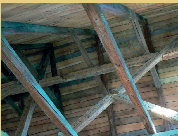
Fotos links: Zustand vor der Reparatur. Fotos rechts: Zustand nach der Reparatur. Zu sehen sind die angeschuhten Balkenteile bzw. Prothesen des Reiterverbands. Die Verbindungen wurden mit Holznägeln gesichert.
