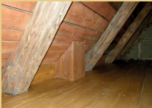
Foto links: Die Entlüftungsrohre wurden im Dachraum verkleidet. Foto rechts: Entlüftungshauben auf dem Dach. Unter dem Gesims sind die Luftaustritte der Entlüftungen der WCs im Obergeschoss erkennbar.
