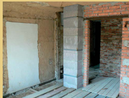
Foto links: Abgetragener Schornstein im EG, westlicher Hausteil. Foto rechts: Bau des neuen Schornsteins aus Systemsteinen im OG und Dachgeschoss, östlicher Hausteil.
