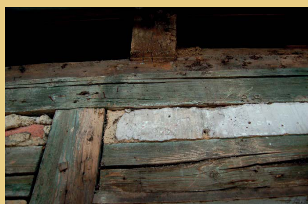
Ansicht der straßenseitigen Längsseite nach dem Freilegen des Fachwerks (April bis Mai 2012). Wie das Fotos rechts belegt, besitzt das Fachwerk hier einen älteren grünen Anstrich und weiße Putzflächen in den Gefachen.
