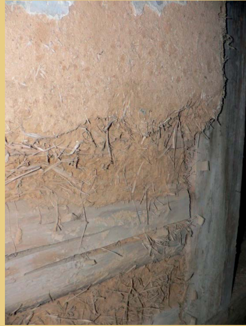
Diese zwei Beispiele belegen, dass zumindest in der letzten Bauphase der Häuser bereits beim Fugenverstrich mit Lehm-Strohhäcksel-Gemisch ein Verputzen der Wände mit Lehmputz in Erwägung gezogen wurde. Die Füllung wurde nicht einmal geglättet, damit diese eine homogene Einheit mit der aufzutragenden Putzschicht eingehen kann, die wie auch an den Fugen von Holznägeln getragen wurde. Foto links: Žďár v Podbezdězí Nr. 7 (Kreis Česká Lípa, Bezirk Liberec). Foto rechts: Flur eines Altenteils/ Speichers des Hofes Nr. 3 in Ždírecký Důl (Kreis Česká Lípa, Bezirk Liberec).
