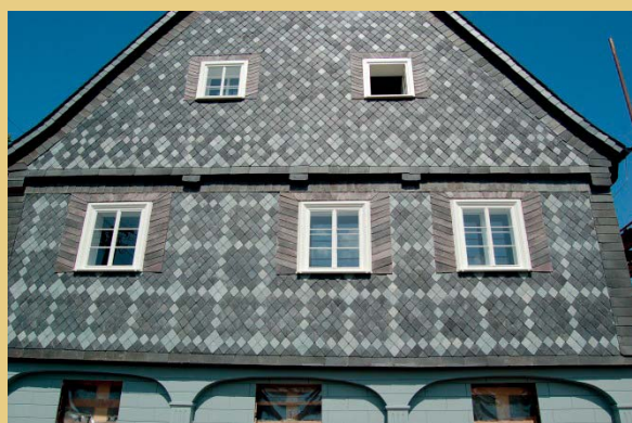
Rückseite und Straßengiebel nach der Rekonstruktion der Verschieferung (Mai bis Juli 2012)
