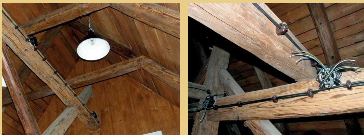
Die neue Elektroinstallation des Dachgeschosses aus schwarz ummantelten Kabeln wurde auf den oberen Balken des Dachstuhls verlegt.
