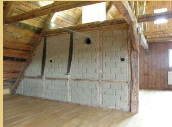
Der Dachboden kann entweder mit den unter dem Giebel bzw. der Gaube befindlichen Plattenheizkörpern oder einem Kaminofen beheizt werden, für den in der neuen Fachwerkwand ein Schornsteinanschluss vorgesehen wurde. Zuvor muss jedoch noch ein Ofenblech installiert werden.
