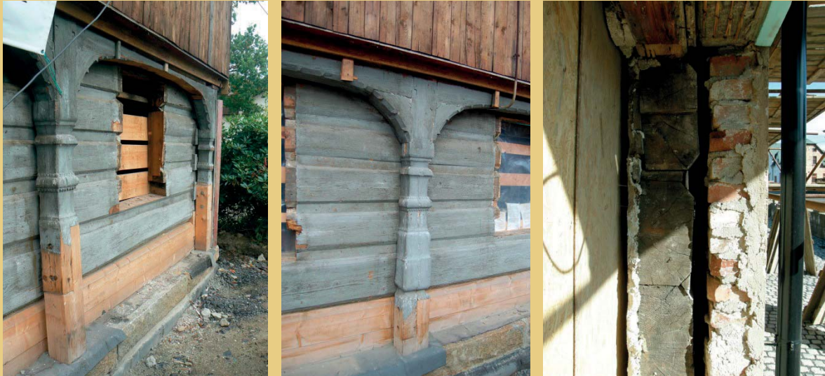
Die ursprünglich mit Brettern verkleideten und bei der Sanierung freigelegten Umgebinesäulen mit spätbarocker Profilierung mussten im unteren Bereich angeschuht werden. Das Foto rechts zeigt die Blockwand im Profil. Unter die Ständer des Umgebines sind Klötzer aus Hartholz z. Bsp. Eiche unterzulegen. Außerdem ist die unterste Balkenlage gegen stehendes Wasser zu schützen.
