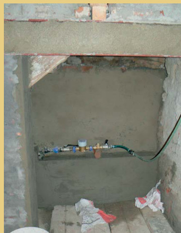
Foto links: Installation der Abwasserleitungen in einem der WCs. Foto Mitte: WC im fertig eingerichteten Zustand. Foto rechts: Der Hauswasseranschluss mit Wasseruhr unter der Treppe zum Obergeschoss ist vom Technikraum aus erreichbar.
