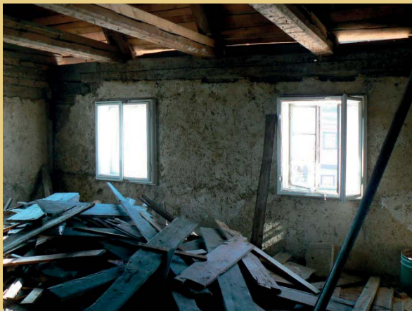
An der Südostecke des Hauses wurden die stark beschädigten Deckenbalken durch Aufdoppelungen verstärkt. Im nordöstlichen Bereich wurden alle Deckenbalken des Erdgeschosses angeschuht.
