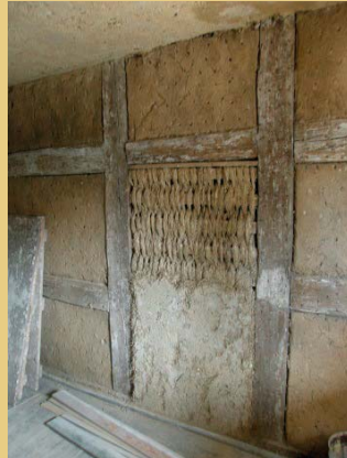
Foto links: Fachwerkwand unter Innenputz. Foto Mitte: Freigelegtes Strohgeflecht einer während einer späteren Bauphase ausgefachten Türöffnung. Foto rechts: Instant gesetzter Lehmputz an den Ausfachungen der Westwand.
