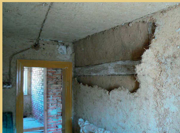
Nach dem teilweisen Entfernen beschädigter Stellen des Kalk- und Lehmputzes wurde die Fachwerkkonstruktion auch an den Zwischenwänden sichtbar.
