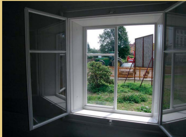
Die neuen Fenster nach dem Einbau im Mai 2005.
