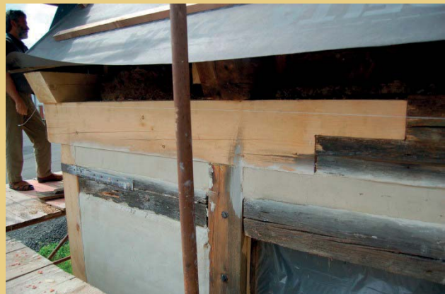
Beispiele für die Anschuhung des Fachwerkrahms. Im rechten Bild ist die stark beschädigte Ecke der Stube im Obergeschoss mit Wandbemalung zu sehen. Die Balkenoberflächen wurden nicht nachbearbeitet, da diese später von der Verbretterung und Schieferbekleidung verdeckt wurden.
