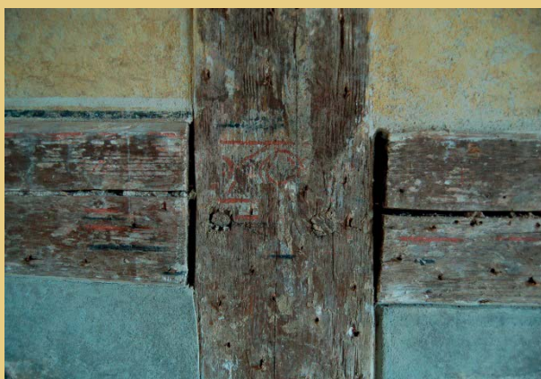
Foto links: Detail der restauratorisch gesicherten Malereifragmente an den Fachwerkbalken. Foto rechts: Ergänzung der fehlenden Putzflächen mit Lehmputz
