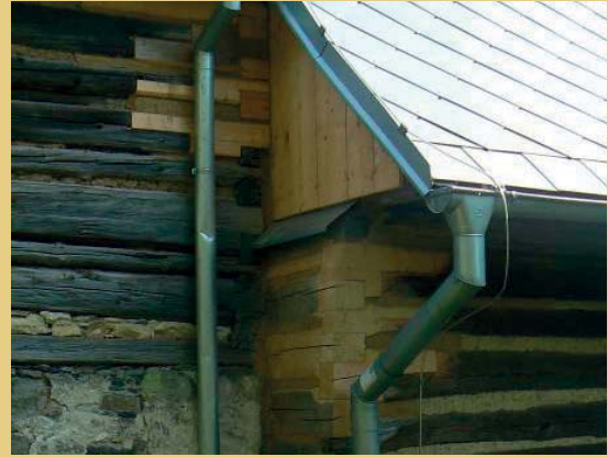
Foto links: Detail der Instandsetzung von Blockstube und Umgebinde (ebenfalls Jindřichovice pod Smrkem). Foto rechts: Aufwendige Anblattungen an den Eckverbindungen eines Haus in Horní Chobolice als Beispiel für die handwerklichen Fertigkeiten der zertifizierten Zimmerleute der Firma Tomáš Hlaváček aus Ústě.
