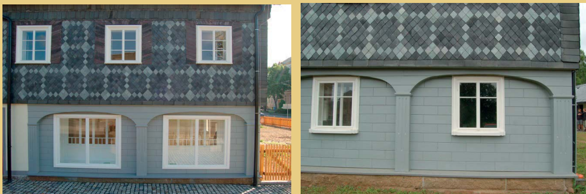
Ansicht der Blockstube nach der Rekonstruktion der Holzverkleidung im Juni und Juli 2012. Foto links: Straßenfront mit Schaufenstern. Foto rechts: Giebelseitige Fenster der Blockstube
