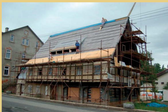
Die Fotos dokumentieren die Montage der Wärmedämmplatten im Juli 2011.
