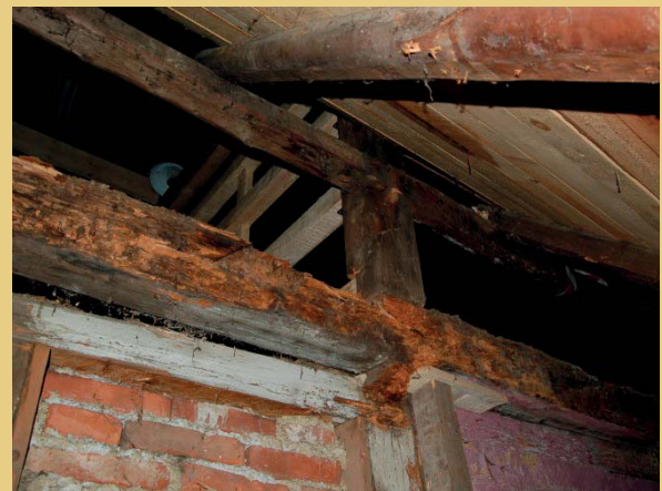
Zustand des Dachraums bei Baubeginn. Auf den Fotos zu erkennen sind die Bretterkammer am Westgiebel, das Geländer der ursprünglichen steilen Dachbodentreppe, die Leiter zum oberen Dachboden und der beschädigte Deckenbalken am Westgiebel.
