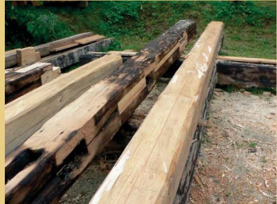
Foto links: Ein Handwerker der zertifizierten Zimmerei hütte Roman Klouček führt beim Tag der offenen Tür 2012 in Lipová vor, wie Balken von Hand behauen werden. Foto rechts: Beispiel für die Verwendung handbehauener Balken beim Wiederaufbau des abgebrannten Glockenturms der Kirche St. Jacobus der Große in Železný Brod (Kreis Jablonec nad Nisou, Bezirk Liberec). Bei dem zweiten Balken von rechts, der zur ursprünglichen Konstruktion des Glockenturms gehörte und beim Wiederaufbau wiederverwendet wurde, sind die verkohlten Schichten abgebeilt und an beschädigten Stellen neue Stücke eingesetzt und mit Holznägeln fixiert worden.
