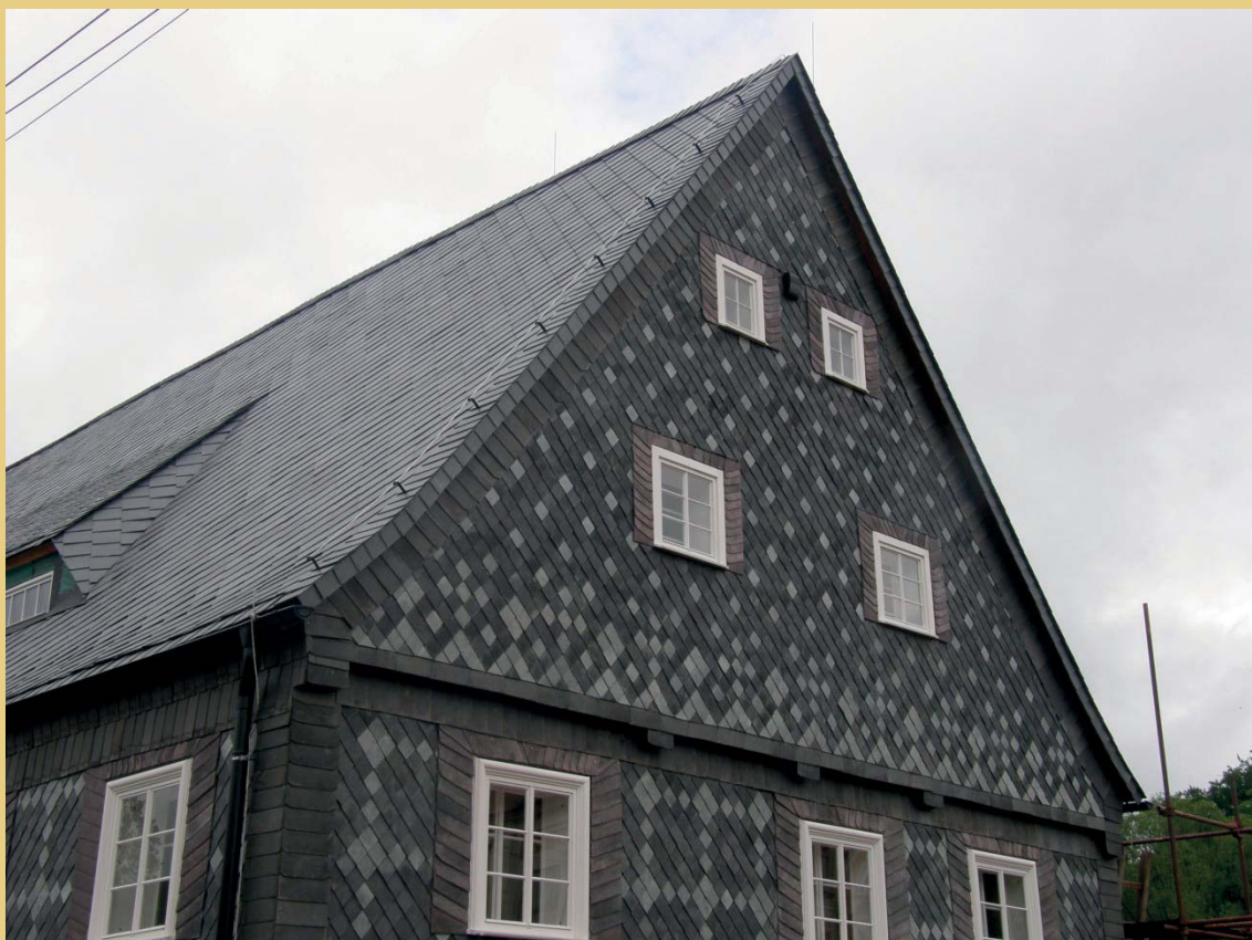
Der straßenseitige Giebel nach dem Abschluss der Rekonstruktion der Schieferverkleidung im Mai 2012.
