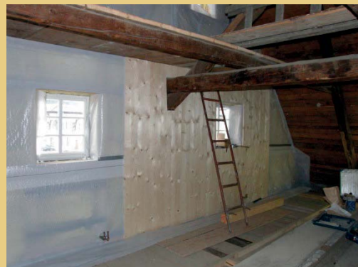
An den Giebelinnenseiten wurde ein Gerüst aus Kanthölzern als Tragkonstruktion für die neue Innenverbretterung aufgestellt. Zwischen Außen- und Innenverbretterung wurde eine Wärmedämmschicht eingebracht.
