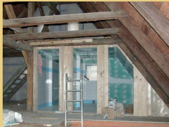
Das Holzgerüst der neuen Trennwände des WC-Einbaus wurde auf der Innenseite mit Gipskartonplatten belegt und gefliest und von außen mit einer Verbretterung verkleidet.
