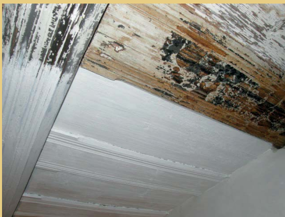
Foto links: Beschädigter Bereich der sichtbaren Einschubdecke der Stube im Erdgeschoss. Foto rechts: nach dem Entfernen der oberen losen Farbschichten erhielt die gesamte Decke flächig einem weißen Deckanstrich.
