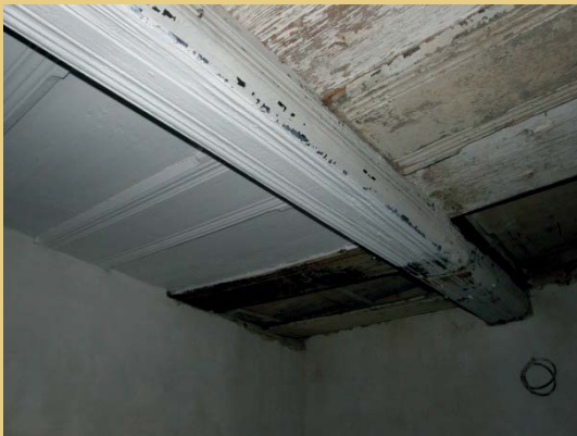
Bei der reich profilierten Decke der Stube wurden lediglich die losen Farbschichten entfernt und der flächige Deckanstrich der gesamten Decke erneuert.
