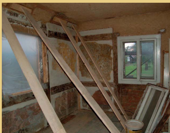
Die Fotos zeigen die freigelegte Wandmalerei an der Nordostecke des Obergeschosses und die Sanierungs- und Restaurierungsarbeiten (die Bretter stützen die wieder angebrachte Hohlkehle ab).
