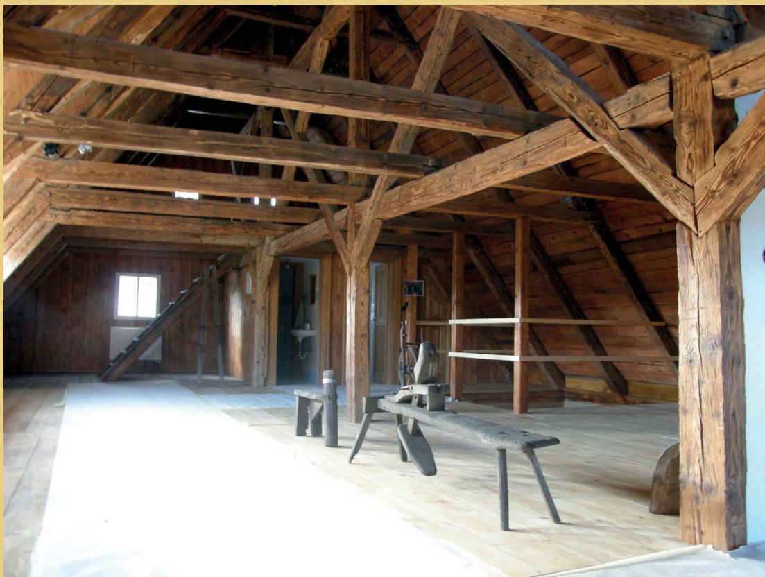
Ansicht des Dachstuhls vor der Behandlung mit farblosem Naturöl.
