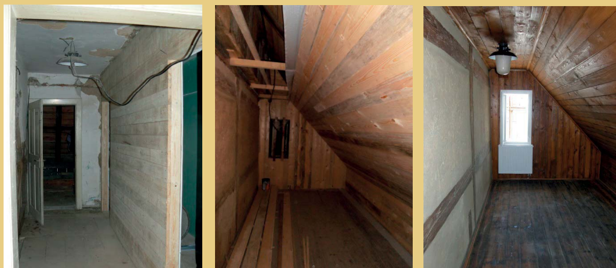
Foto links. Die neue Holztrennwand zur Abtrennung von Toiletten wurde auf der Seite des Flurs mit Brettern als Träger für einen Lehmputz verkleidet. Fotos Mitte und rechts: Wandverkleidung der Kammer im Anbau am Westgiebel.
