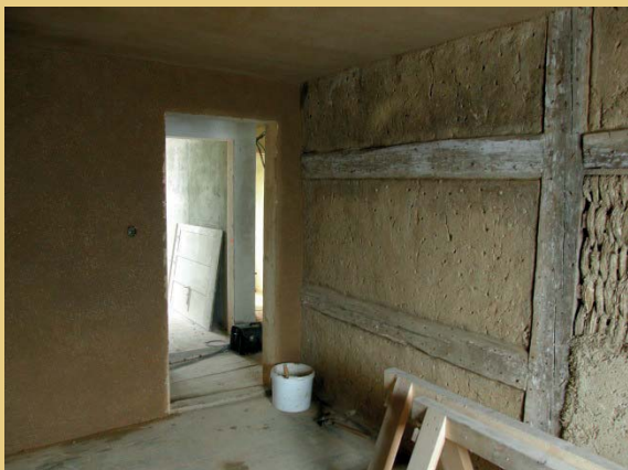
Bei ausgewählten Wänden wurde das Fachwerk als Sichtfachwerk belassen. Die übrigen Wände wurden zum Großteil flächig neu verputzt.
