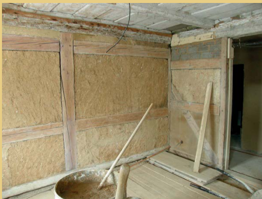
Bei ausgewählten Wänden wurde das Fachwerk als Sichtfachwerk belassen. Die übrigen Wände flächig mit Lehmputz überputzt.
