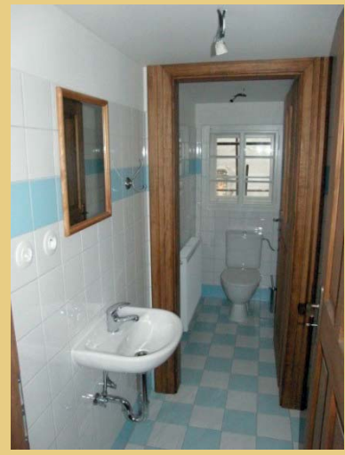
Das Holzgerüst der neuen Trennwände des WC-Einbaus wurde auf der Innenseite mit Gipskartonplatten belegt und gefliest und von außen mit einer Verbretterung verkleidet.
