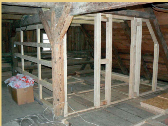
Im Westteil des Dachgeschosses wurde aus Kanthölzern das Skelett für einen neuen WC-Einbau geschaffen, der innen mit Gipskartonplatten und außen mit Brettern verkleidet wurde.
