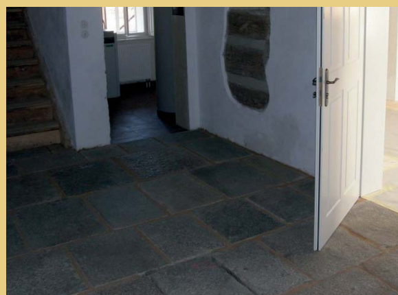
Die originalen Steinplatten im Flur des Hauses wurden nummeriert, ausgebaut und gereinigt. Anschließend wurden diese in ein Mörtelbett auf dem neu erstellten Unterbau verlegt und mit Lehm verfugt (2010, 2012).
