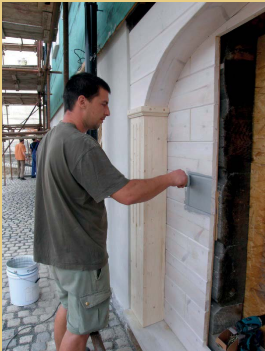
Rekonstruktion der Blockwandverkleidung im Juni und Juli 2012.
