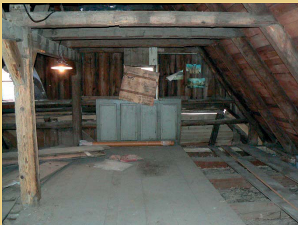
Zustand des Dachraums bei Baubeginn. Auf den Fotos zu erkennen sind die Bretterkammer am Westgiebel, das Geländer der ursprünglichen steilen Dachbodentreppe, die Leiter zum oberen Dachboden und der beschädigte Deckenbalken am Westgiebel.
