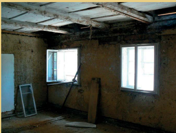
Nach dem teilweisen Entfernen beschädigter Stellen des Kalk- und Lehmputzes wurde die Fachwerkkonstruktion auch an den Zwischenwänden sichtbar.
