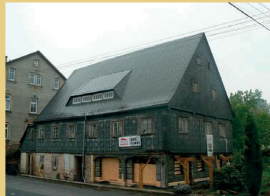
Die Fotos dokumentieren die Entfernung der ursprünglichen Schiefereindeckung im Jahr 2004 und den Zustand nach deren Wiederherstellung im Zuge der Sanierung.
