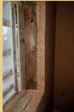
Die meisten Fachwerk-Außenwände wurden zuerst mit einem Lehmputz ausgeglichen. Danach erfolgte die Anbringung der diffusionsoffenen Holzfaser-Dämmplatten, die abschließend mit einem Lehmfeinputz versehen wurden.
