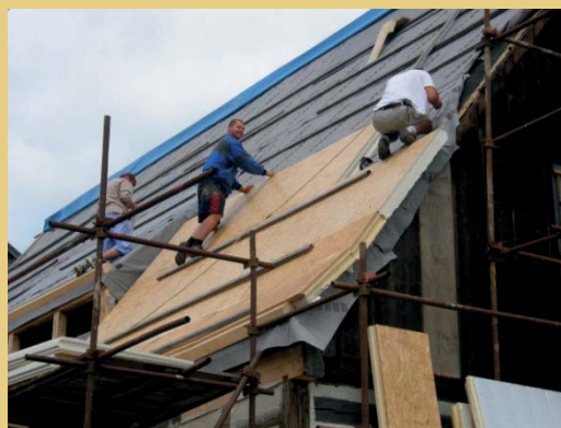
Die Fotos dokumentieren die Montage der Wärmedämmplatten im Juli 2011.
