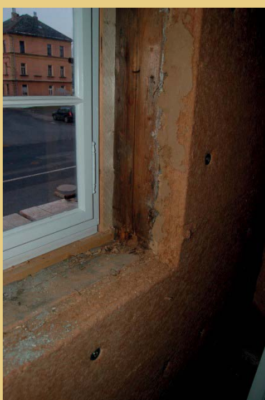
Bei den meisten Fachwerk-Außenwänden wurde zuerst ein ebener Lehmputz hergestellt und auf diesen eine Wärmedämmung aus Holzfaserplatten montiert, die abschließend mit Lehm verputzt wurde.
