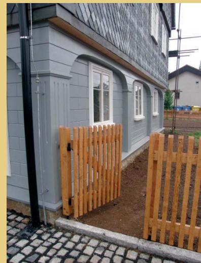
Foto links: Schotterunterbau an der Hausvorderseite. Foto Mitte: Neu gesetzte Zaunpfosten an der Nordseite des Gartens nach der Fertigstellung des neuen Entwässerungsgrabens. Foto rechts: Detail des fertigen Granitpflasters an der Südostecke des Hauses einschließlich neuem Holztor, Zaun und Granitbordstein.
