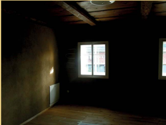
Ausgewählte Wände und Räume wurden in natürlichem lehmfarbenem Zustand belassen. Auf dem Foto links ist zu erkennen, dass neben dem Fenster ein Teil der Wandheizung der Räume 1.08 und 1.09 sichtbar gelassen wurde. In den übrigen Räumen wurde der Lehmputz an Decken und Wänden mit einer Malerbürste mit einem Kalkanstrich mit unterschiedlichen Weißtönen gestrichen. Das Foto rechts zeigt das Eckzimmer 1.06.
