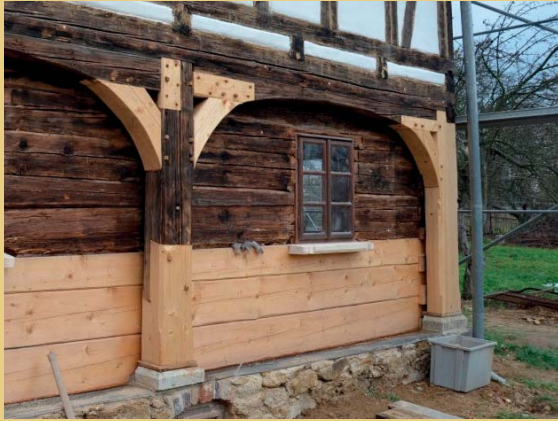
Foto links: Detail der Instandsetzung von Blockstube und Umgebinde (ebenfalls Jindřichovice pod Smrkem). Foto rechts: Aufwendige Anblattungen an den Eckverbindungen eines Haus in Horní Chobolice als Beispiel für die handwerklichen Fertigkeiten der zertifizierten Zimmerleute der Firma Tomáš Hlaváček aus Ústě.
