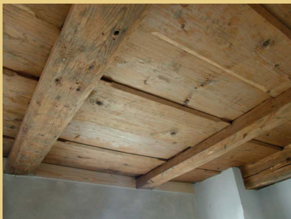
Foto links: Eine der Einschubdecken, die auch nach der Sanierung sichtbar sind. Nach der Entfernung des Kalkanstrichs wurde diese mit einem farblosen Wachsanstrich versehen. Das Foto rechts dagegen zeigt einen Raum im nordöstlichen Hausteil, in dem nach dem Austausch der Deckenbalken die Decke erneut verputzt und mit einer profilierten Stuckkassette nach vorgefundenen Fragmenten verziert wurde.
