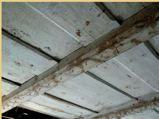
Die freigelegte Holzbalkendecke mit Einschubbrettern wurde von einem älteren Kalkanstrich befreit.
