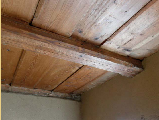
Anstriche auf Basis natürlicher Öle und Wachse an Einschubdecken und Sichtfachwerk.
