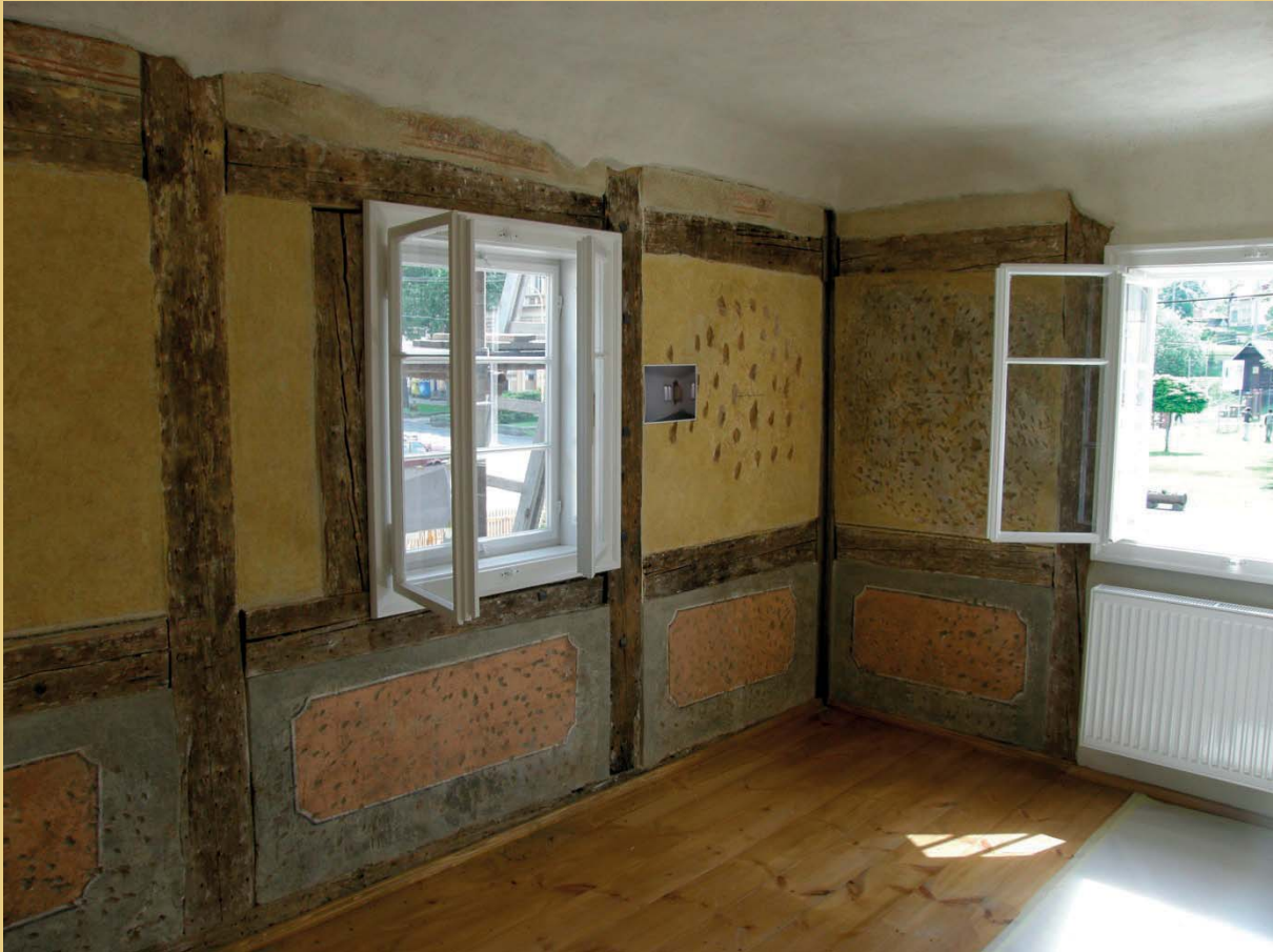
Aussehen der Stube nach dem Abschluss der Restaurierungsarbeiten, Ergänzung der Putze an Decke und Wänden ohne Wandmalerei, Einbau der Fenster und Erneuerung der Dielung.
