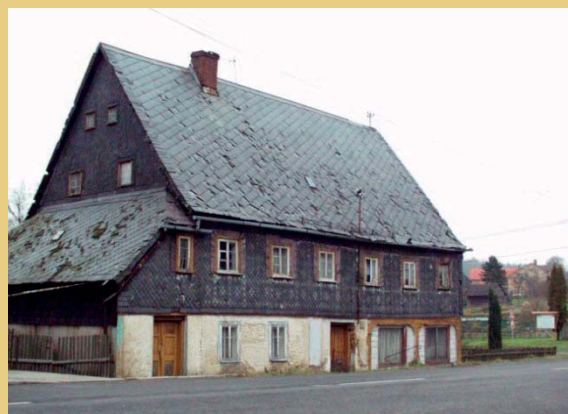
Beide Fotos zeigen die ursprüngliche Schiefereindeckung, links im Zustand von 1978 und rechts vor 2001.
