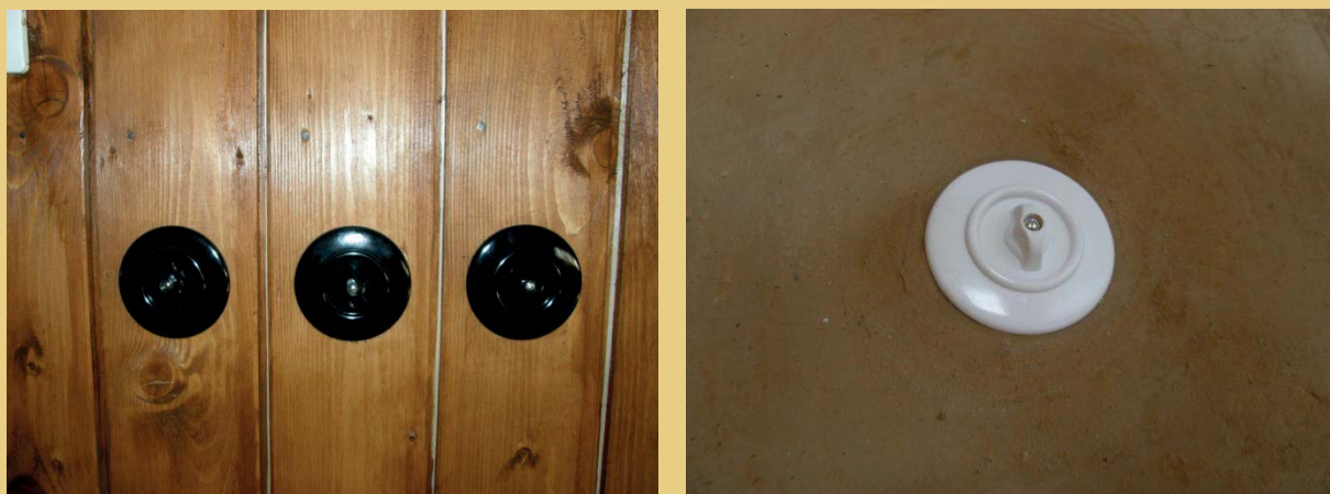
Neu installierte schwarze und weiße Retro-Lichtschalter auf der Bretterwand im Dachgeschoss und naturbelassenem Lehmputz.
