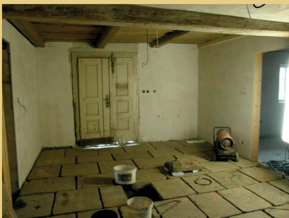
Die originalen Steinplatten im Flur des Hauses wurden nummeriert, ausgebaut und gereinigt. Anschließend wurden diese in ein Mörtelbett auf dem neu erstellten Unterbau verlegt und mit Lehm verfugt (2010, 2012).
