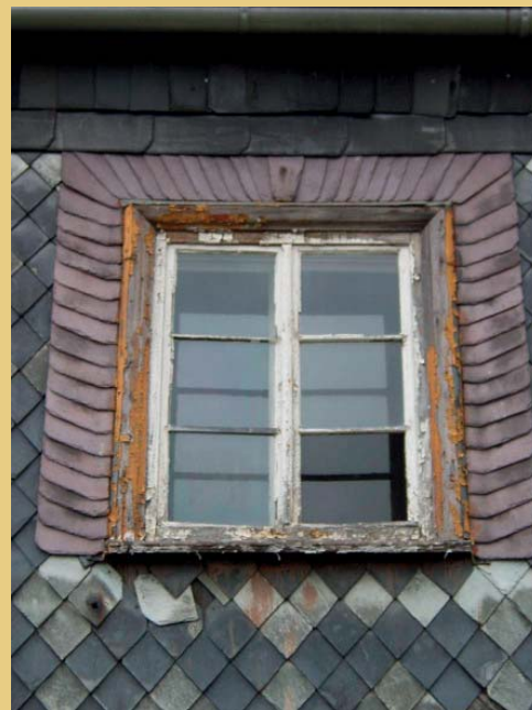
Zustand der Schieferverkleidungen im Jahr 2005. Foto links: Ansicht der Giebelseite mit Schiefermuster. Foto rechts: Fenstereinfassung an der Vorderseite des Hauses.
