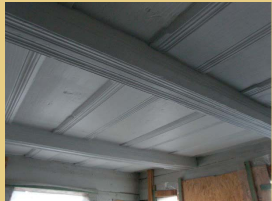
Bei der reich profilierten Decke der Stube wurden lediglich die losen Farbschichten entfernt und der flächige Deckanstrich der gesamten Decke erneuert.
