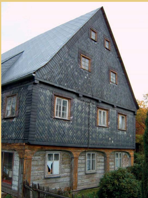
Zustand der Schieferverkleidungen im Jahr 2005. Foto links: Ansicht der Giebelseite mit Schiefermuster. Foto rechts: Fenstereinfassung an der Vorderseite des Hauses.
