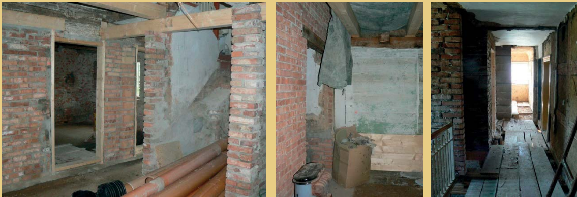
Wiederherstellung der tragenden Ziegelwände und Herstellung neuer Trennwände im EG und OG
