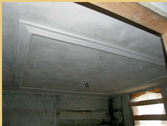
Foto links: Eine der Einschubdecken, die auch nach der Sanierung sichtbar sind. Nach der Entfernung des Kalkanstrichs wurde diese mit einem farblosen Wachsanstrich versehen. Das Foto rechts dagegen zeigt einen Raum im nordöstlichen Hausteil, in dem nach dem Austausch der Deckenbalken die Decke erneut verputzt und mit einer profilierten Stuckkassette nach vorgefundenen Fragmenten verziert wurde.
