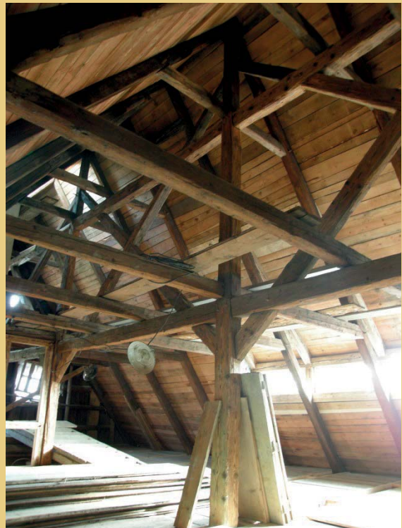
Nach der Demontage des auf den Kehlbalken aufliegenden Dielenbodens wurde der gesamte Dachraum bis hinauf zum First und die Dachstuhlkonstruktion als solche mit ihren hohen Firstsäulen und Reiterverbänden sichtbar.
