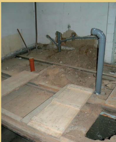
Foto links: Installation der Abwasserleitungen in einem der WCs. Foto Mitte: WC im fertig eingerichteten Zustand. Foto rechts: Der Hauswasseranschluss mit Wasseruhr unter der Treppe zum Obergeschoss ist vom Technikraum aus erreichbar.
