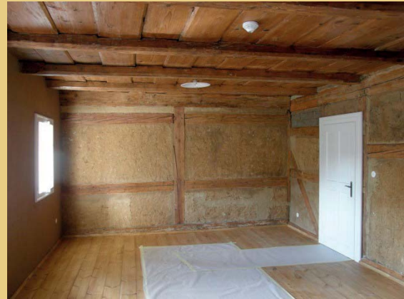
Anstriche auf Basis natürlicher Öle und Wachse an Einschubdecken und Sichtfachwerk.
