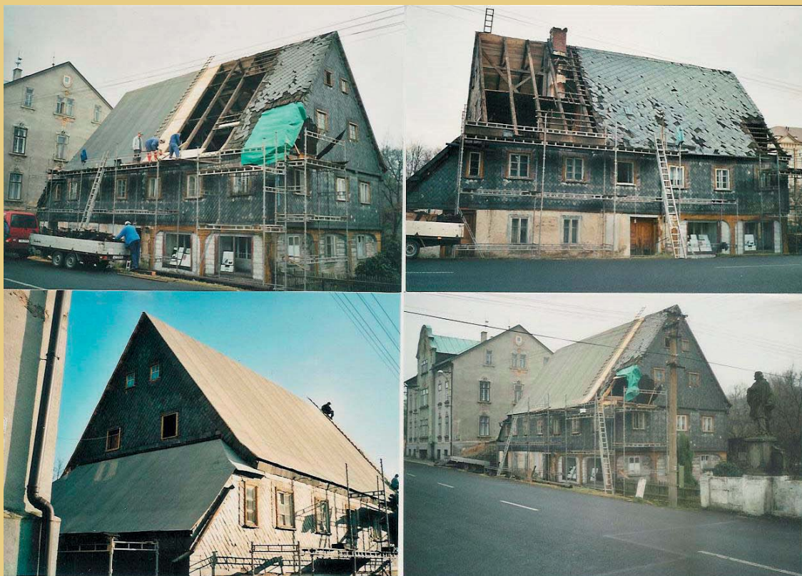
Fotos von der Instandsetzung der Dachhaut und Neueindeckung mit Zementfaserplatten im Jahr 2004.
