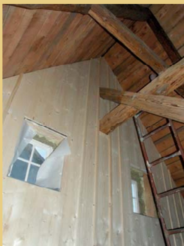
Nový vnitřní bedněný obklad štítů tvořený prkny přibíjenými na podkladní rošt na sraz, se zakrytím styčných spár masivními dřevěnými lištami s předem sraženými hranami za použití ručního hoblíku. Bednění opatřené lazurním tónovaným olejovým nátěrem, podobně jako obklad z užších prken na podkrovní vestavěné přičce toalet.
