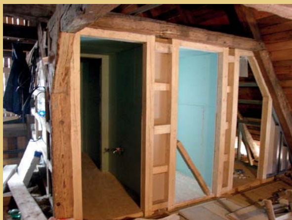
Dřevěná sloupková konstrukce nových příček podkrovního bloku toalet byla zevnitř opatřena sádkartonovým a keramickým obkladem, ze strany hlavního podkrovního prostoru byla poté obložena svisle kladeným bedněním.
