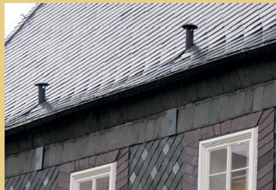
Vlevo kanalizační stoupačky, zakryté v podkroví bedněným obkladem, odvětrané na pravém snímku nad střešní krytinou v podobě plechových komínků, pod římsou zřejmé též plechové děrované kryty vyústění odvětrání toalet v patře.
