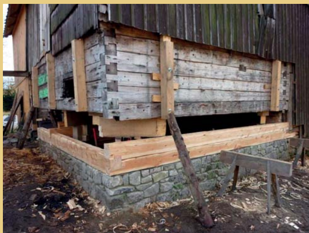
Příklad opravy roubeného přízemí z krušnohorské Přebuzi s použitím ručně tesaných trámů, detail zámkových spojů v nároží, ukázka z práce certifikovaných tesařů Tesařské Huti (foto tesař Roman Klouček).
