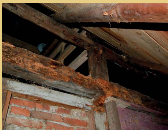
Stav prostoru krovu při zahájení prací, na snímcích při západním štítu ještě zjevná bedněná půdní komora, zábradlí někdejšího strmého schodiště z patra, žebříkové schody na první hambalky a vážně poškozený vazný trám západního štítu.
