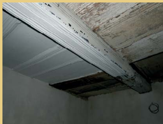
Proces čištění starších vrstev krycích nátěrů záklopového zdobně profilovaného stropu ve světnici, byly odstraněny jen nesoudržné vrstvy nátěrů a obnoven souvislý matný bílý krycí nátěr celého stropu.
