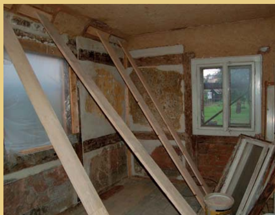
Snímky po odhalení hrázděné malované stěny v severovýchodním koutu prvního patra, skryté hliněnou vnitřní omítkou. Detail výzdoby podokenního pole a záběr z postupu oprav a restaurování (dřevěné fošny zajišťují vrácení hliněný fabion).
