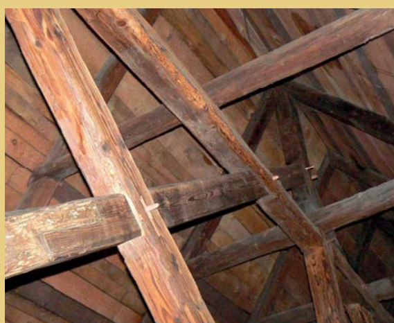
Na fotografiích vlevo stavu před opravou a vpravo po opravě jsou zřejmé dřevěné protézy tedy nastavení poškozených či chybějících částí diagonálních trámů ondřejských křížů, přičemž spoje byly zajištěny dřevěnými kolíky.
