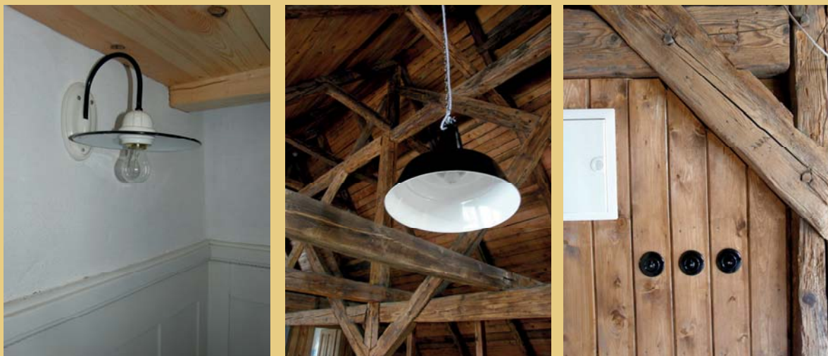
Osazení nových retro svítidel na schodišti do prvního patra, hrncová závěsná lampa v podkroví, černé kruhové retro vypínače, osazené na dřevěné stěně v podkroví.
