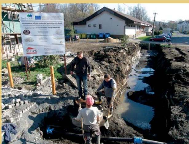
Náročné výkopové práce při řešení drenážních a odvodňovacích pracích v okolí domu, vpravo již snímek stejného místa po dokončení terénních úprav a založení travnaté plochy.
