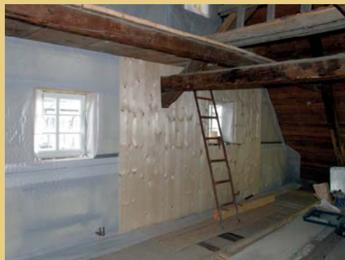
Provádění dřevěného trémkového roštu na vnitřní straně bedněných štítů krovu, který byl vyplněn tepelně izolačními rohožemi a obložen z interiéru novým bedněním.
