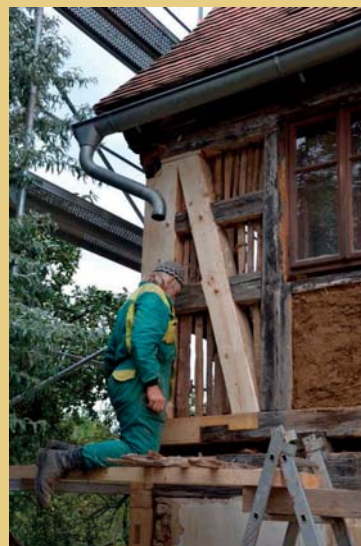
Příklad náročné tesařské opravy velmi poškozeného nároží hrázděného patra chalupy v Jindřichovicích pod Smrkem na Frýdlantsku s použitím tradičních řemeslných postupů a obnovení tyčových výplní a hliněných vymazávek (foto Zbyněk Vlček, 2012).
