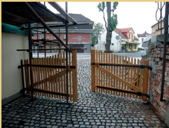
Nová dlažba z kamenných kostek na jihozápadním nároží s osazenými novými dřevěnými vraty, provedenými dle historické fotografické předlohy.
