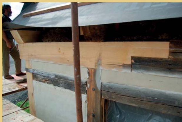
Příklady provedení lokálních protéz a nastavení horní ližiny hrázděné stěny (na pravém snímku u nejvíce poškozeného hrázdění malované světnice). Povrch trámů nebyl výrazněji upravován, neboť byl následně zakryt bedněním a břidlicovým obkladem.
