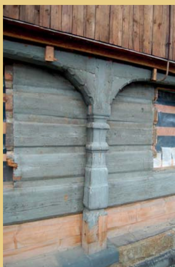
Původně bedněným obkladem zakryté a během opravy odhalené sloupky barokně ozdobně profilované podstávky bylo nutné ve spodních částech též nastavit dřevěnými protézami, vpravo je vidět z profilu stěna roubená z hraněných trámů. Sloupky podstávky je vhodné podložit např. dubovou podložkou a zajistit, aby se v patě roubených stěn nezdržovala voda.
