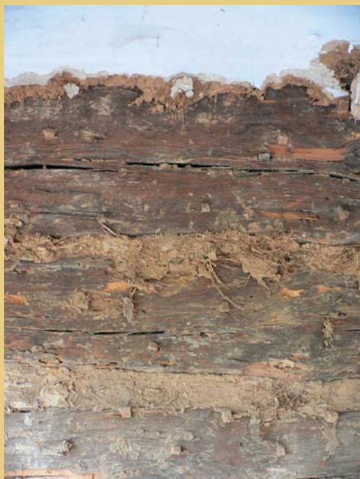
Ukázky dvou staveb, kde bylo minimálně v poslední historické stavební etapě již při vymazání trámů roubení hliněnou směsí s výrazným podílem slaměné řezanky počítáno s realizací hliněné omítky. Vymazávka mezi trámy není ani zarovnána, neboť se počítalo s plynulým napojením omítky, uchycené stejně jako u spár na dřevěné kolíčky. Vlevo světnice domu č. p. 7 ve Žďáru v Podbezdězí (okr. Česká Lípa, Liberecký kraj), vpravo síň obytného výměňku/špýcharu usedlosti č. p. 3 ve Ždírečském Dole (okr. Česká Lípa, Liberecký kraj).
