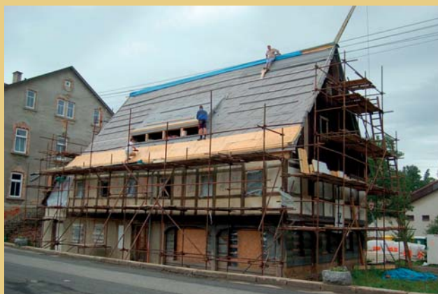
Tyto snímky dokumentují proběh pokládky střešní izolace v červenci 2011.
