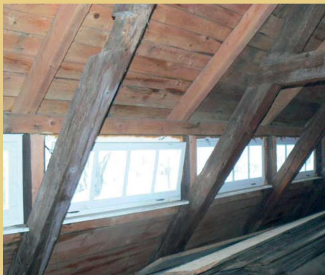
Vlevo ještě novodobá konstrukce vikýře v podobě štiny z poslední opravy střechy v roce 2002, vpravo nyní nově realizovaná konstrukce vikýře s krokvemi osedlanými na vnitřní straně horní nadokenní vaznice vikýře, s doplněným chybějícím koncem jednoho z hambalků krovu.
