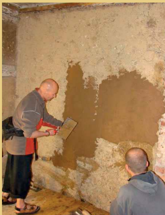
Záběry z workshopu věnovanému opravám hliněných omítek, kde německý certifikovaný řemeslník Thomas Kurze předváděl přípravu jílové omítky a její aplikaci na stěnách, přičemž účastníci si mohli práci s tímto materiálem také vyzkoušet a osvojit.
