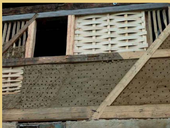
Příklad tradiční řemeslné opravy hrázděného patra krušnohorské fary v Českém Jiřetíně, tesařské protězy a výměny poškozených trámů, obnova dřevěných tyčových výplní, dřevěných výpletů a hliněných vymazávek a omítek, z referencí Tesařské huti z Karlovarska (foto certifikovaný tesař Roman Klouček).
