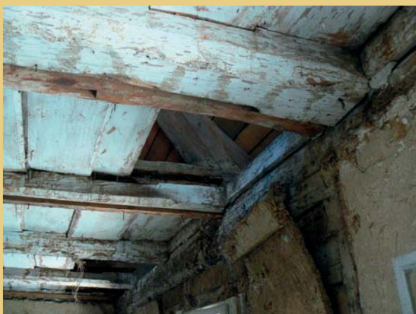
Snímky stropů a prkenných záklopů s místy poškození způsobenými dlouhodobým zatékáním střešní krytinou při jižním průčelí (vlevo) a v severovýchodním nároží (vpravo).
