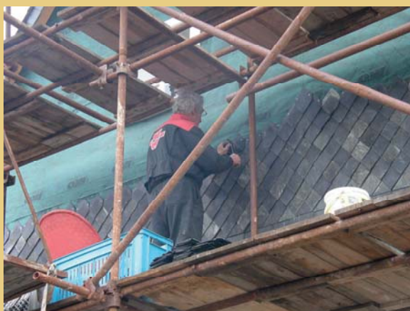
Průběh rekonstrukce břidlicového obkladu na čelním štítě v dubnu a květnu 2012. Na dolním snímku probíhající práce na zadním štítě.
