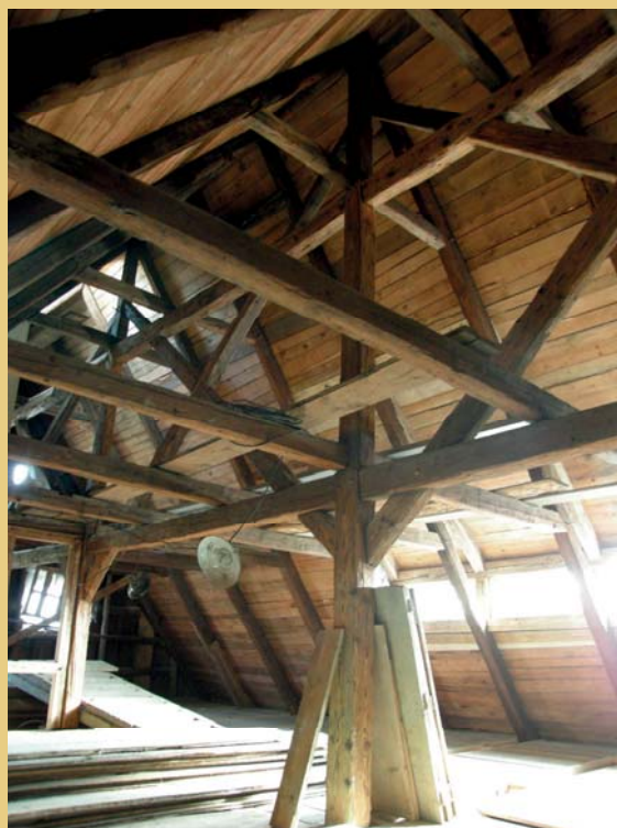
Po rozebrání prkenné podlahy na dolních hambalcích se otevřel celý prostor krovu až do vrcholu a odhalila se celá konstrukce s vysokými středními sloupy a diagonálním zavětrováním v podobě tzv. ondřejských křížů.
