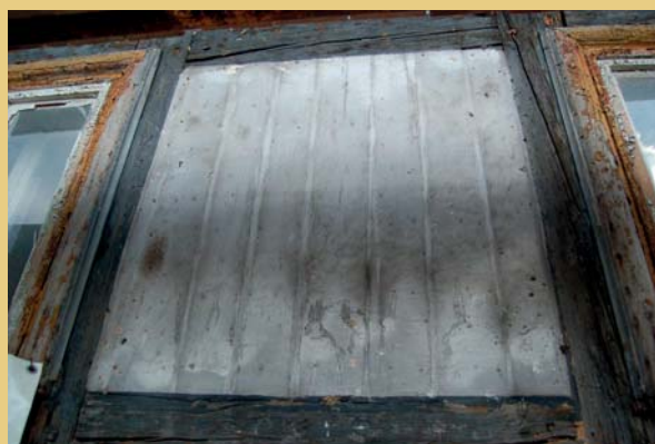
Pohled na zadní podélné průčelí domu po odkrytí hrázděné konstrukce v patře (03-05/2012). Jak ukazuje fotografie vpravo, zdejší hrázděná pole byla dochována s mladším šedomodrým nátěrem trámové kostry a světle šedými omítkami výplní se sytější linkou po obvodu. Na celkovém snímku jsou patrná místa s cihelnými výplněmi, zejména se jedná o malovanou světnici o třech polích zcela vlevo a patrně mladší úpravy některých polí vpravo. Zbýlá část má výplně tyčoviny, slaměného výpletu a hliněné mazaniny.
