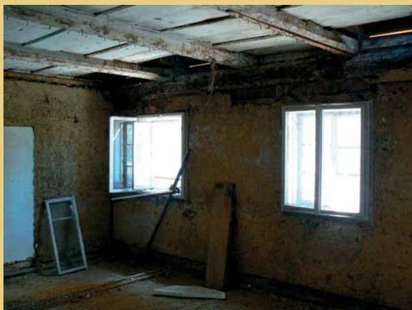
Po částečném sejmutí poškozených partií vápenných a hliněných omítek byla zřejmá konstrukce hrázdění i na vnitřních příčkách.
