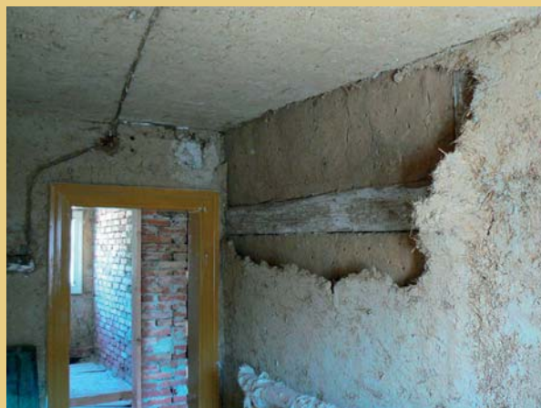
Po částečném sejmutí poškozených partií vápenných a hliněných omítek byla zřejmá konstrukce hrázdění i na vnitřních příčkách.
