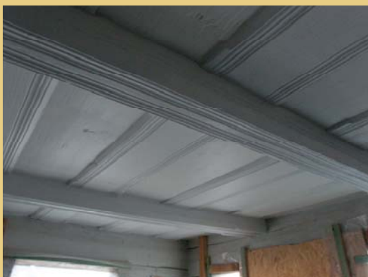
Proces čištění starších vrstev krycích nátěrů záklopového zdobně profilovaného stropu ve světnici, byly odstraněny jen nesoudržné vrstvy nátěrů a obnoven souvislý matný bílý krycí nátěr celého stropu.
