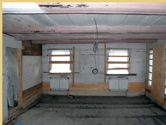
Heverování trámového stropu světnice a roubených stěn přízemí objektu na jaře roku 2010, které umožnilo tesařskou opravu a výměnu poškozených spodních trámů roubených stěn.
