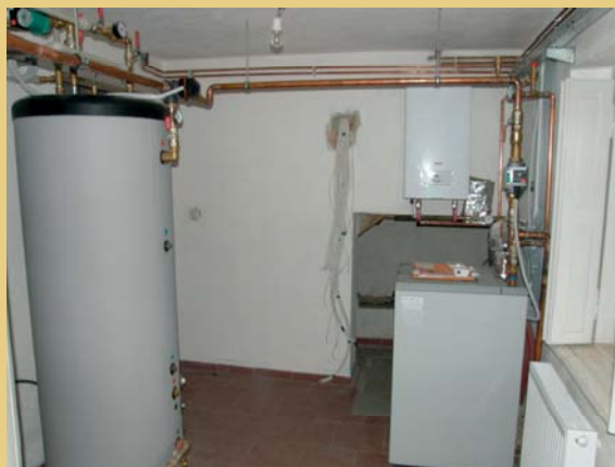
Umístění venkovní jednotky tepelného čerpadla na okraji zahrady vedle sousedního provozního objektu skladu, vpravo na podlaže technické místnosti je instalována vnitřní jednotka tepelného čerpadla, napojená na akumulací nádrž a boiler, s doplňkovým nástěnným elektrokotlem.
