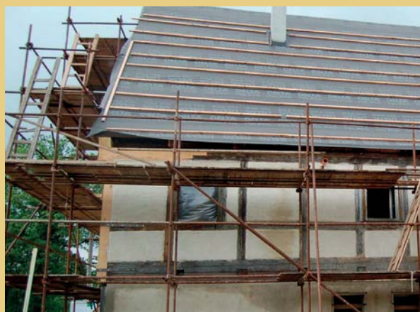
Po dokončení tesařských oprav byly doplněny poškozené dřevohliněné výplně polí a opraveny vápenné omítky.
