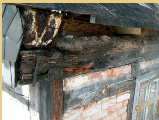
Další místa poškození dřevěné konstrukce, houbou napadené trámy severovýchodního nároží a jeden ze sloupků jižní stěny.
