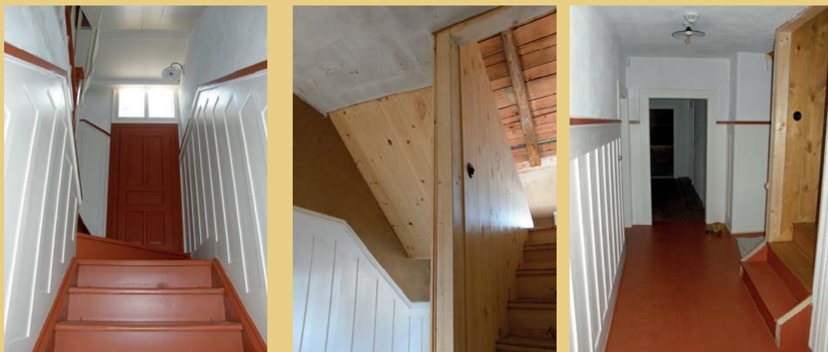
Repase a doplnění dřevěných historických obkladů schodiště do patra včetně obnovy krycích barevných nátěrů. Nový bedněný obklad schodů do podkroví s lazurním tónovaným olejovým nátěrem.
