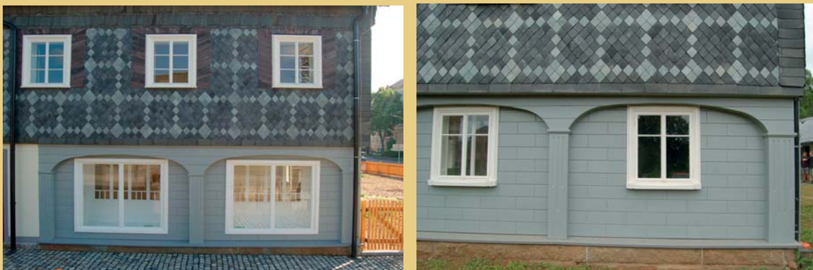
Roubení světnice po dokončení rekonstrukce dřevěného obkladu v červnu a červenci 2012. Vlevo podélné průčelí s výkladcí, vpravo část s oknem světnice a světničky.
