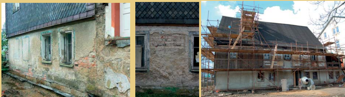
Stav omítek zadního průčelí v červnu 2010 a v průběhu prací v dubnu 2011.
