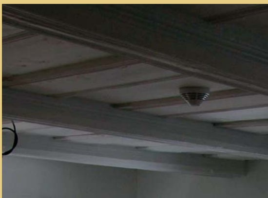
Příklad osazení požárních hlásičů na záklopovém stropu v přízemí, vpravo osazení černého vnějšího zařízení požární bezpečnostního signalizačního systému na hlavním štítě domu.
