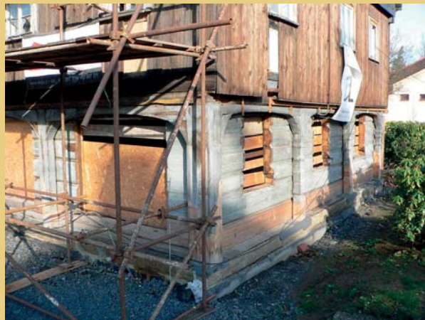
Roubená světnice po provedení výměn poškozených prvků stěn a podstávky v listopadu 2010.
