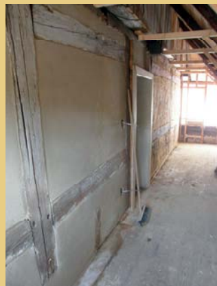
Vlevo hrázděná stěna pod vnitřními omítkami, uprostřed odhalený slaměný výplet druhotně zaslepeného vstupního otvoru, vpravo provedené opravy hliněných omítek polí západní hrázděné stěny.
