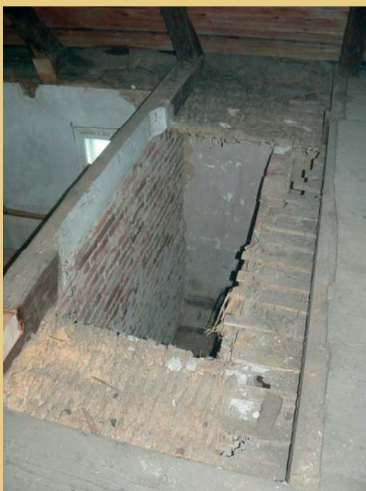
V místě původního strmého schodiště na půdu se dochovala stropní konstrukce tvořená dřevěnými latěmi omotanými slaměnými provazci. Vpravo oprava prkenných podhledů s opětovným použitím rákosových rohoží jako nosiče obnovených vápenných a hliněných omítek.
