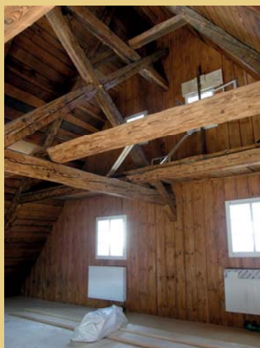
Nový vnitřní bedněný obklad štítů tvořený prkny přibíjenými na podkladní rošt na sraz, se zakrytím styčných spár masivními dřevěnými lištami s předem sraženými hranami za použití ručního hoblíku. Bednění opatřené lazurním tónovaným olejovým nátěrem, podobně jako obklad z užších prken na podkrovní vestavěné přičce toalet.
