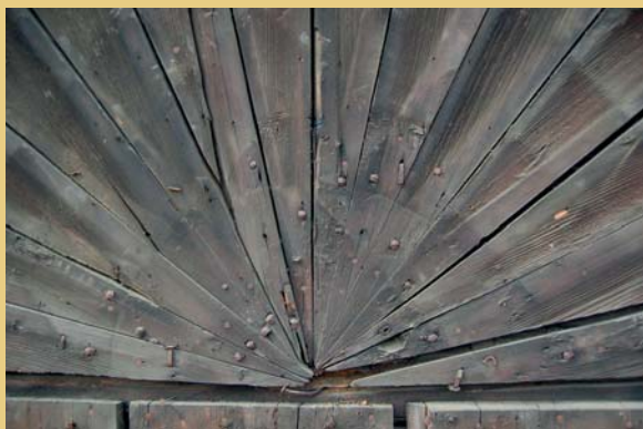
Na snímku vlevo vrchol lomenice čelního štítu po demontáži břidlice v dubnu r. 2011. Fotografie vpravo zachycuje proces demontování břidlice ze štítu a mezideponii a třídění na podlážkách lešení.
