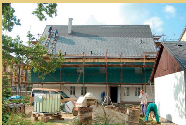
Pokládání břidlicové krytiny v srpnu a září 2011, včetně záběrů na jednotlivé řešené detaily skladby krytiny a zejména vykrytí okrajů u štítů.
