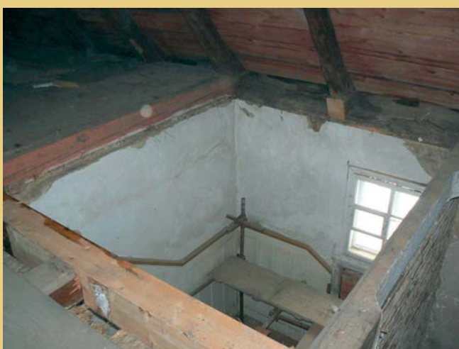
Vpravo původní podoba schodiště z patra do podkroví (2010) a vlevo otvor otevřený ve stropní konstrukci pro nové schodiště (2011).
