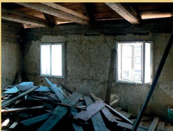
V jihovýchodním nároží byly značně poškozené stropní trámy v patře posíleny trámovými příložkami a protézami, v severovýchodní části byly stropní trámy nad přízemím kompletně nastaveny.
