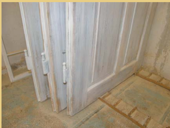
Nahoře vlevo původní stav dveří na chodbě v patře (2011). Ostatní snímky zachycují stav dalších dveří po očištění, lokální opravě poškozených míst a provedeném podnátěru (únor 2012).
