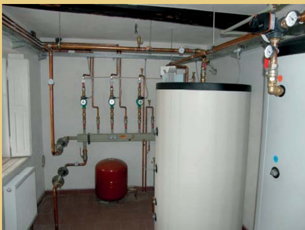
Pohled na druhou stranu technické místnosti s akumulací nádrží a boilerem po pravé straně a v pozadí s rozdělovačem a čerpadly topných okruhů včetně expanzní nádoby. Vpravo snímek z rohové místnosti v patře s instalovanými deskovými topnými radiátory.
