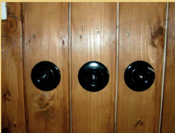
Osazení nových kruhových retro ovladačů osvětlení, na dřevěných stěnách v podkroví zvoleny v černé barvě, vpravo na hliněné omítce v patře v bílém provedení.
