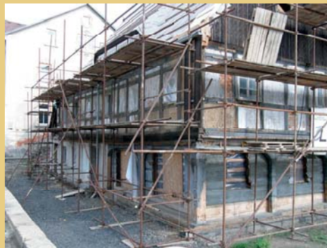
Odhalená hrázděná stěna s vápennou omítkou na výplních dřevěné konstrukce.
