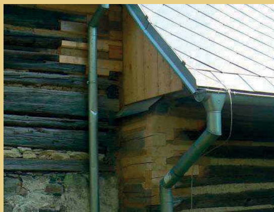
Vlevo detail opravy roubení a protéz podstávky opět z Jindřichovic, vpravo náročné protézování roubeného nároží z Horních Chobolic jako ukázka práce týmu certifikovaného tesaře Tomáše Hlaváčka.
