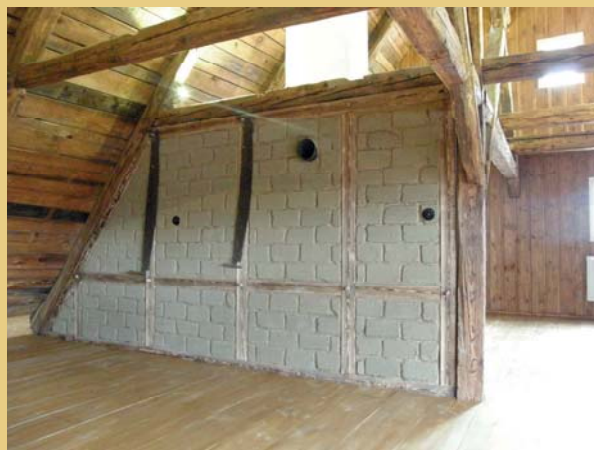
Ve východní části podkroví byla vytvořena nová hrázděná přička s vyzdívkou z nepálených hliněných cihel.
