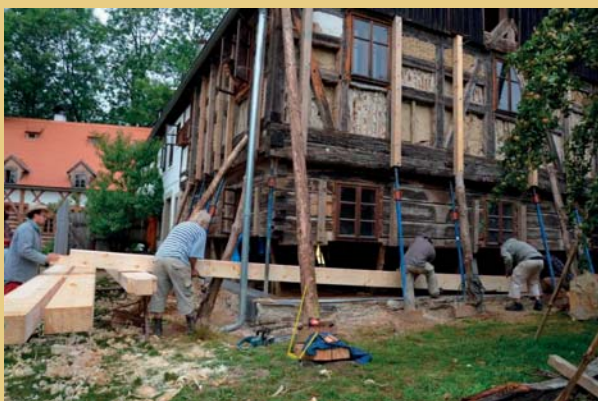
Příklad heverování hrázděného patra a stropu, výměny spodních trámů roubené světnice a protézování a oprava konstrukce podstávky s dodržáním čepových spojů a dřevěných spojovacích hřebů (koliků) na podstávkovém domu v Jindřichovicích pod Smrkem na Frýdlantsku. Ukázka z práce tesaře Matouše Kirschnera (foto Zbyněk Vlk, 2012).
