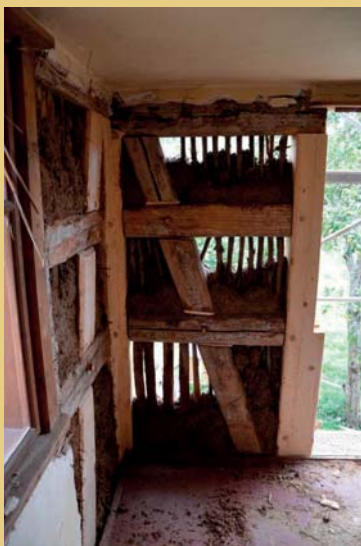
Příklad náročné tesařské opravy velmi poškozeného nároží hrázděného patra chalupy v Jindřichovicích pod Smrkem na Frýdlantsku s použitím tradičních řemeslných postupů a obnovení tyčových výplní a hliněných vymazávek (foto Zbyněk Vlček, 2012).
