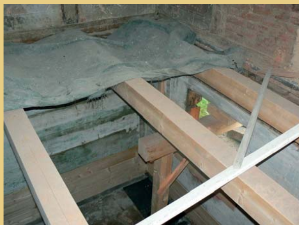
V jihovýchodním nároží byly značně poškozené stropní trámy v patře posíleny trámovými příložkami a protézami, v severovýchodní části byly stropní trámy nad přízemím kompletně nastaveny.
