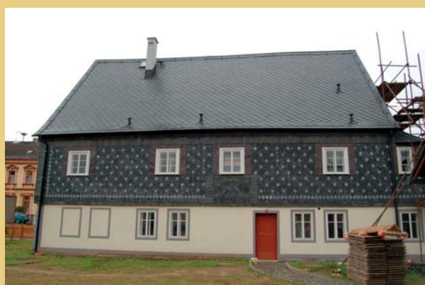
Vlevo zadní, vpravo část vstupního průčelí domu s dokončenými omítkami včetně paspart kolem oken a dveří v červenci 2012.
