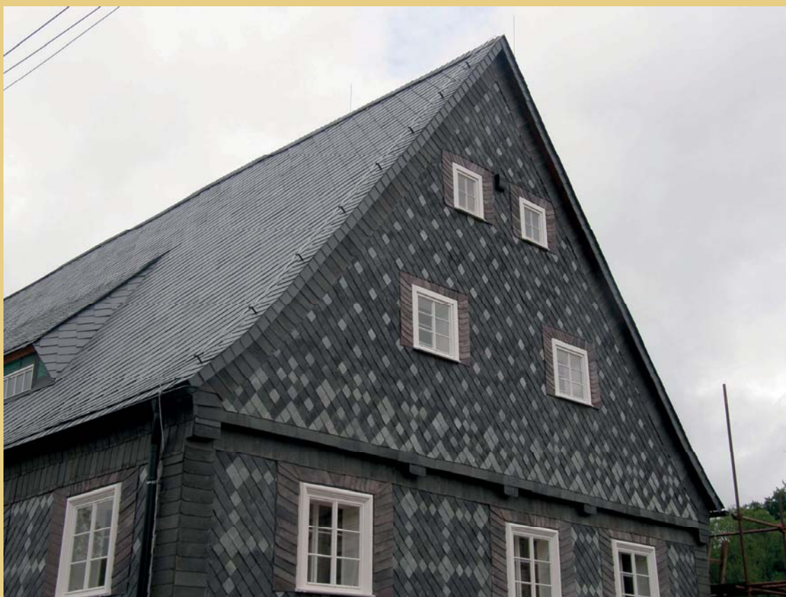
Čelní štít po dokončení rekonstrukce břidlicového obkladu v květnu 2012.
