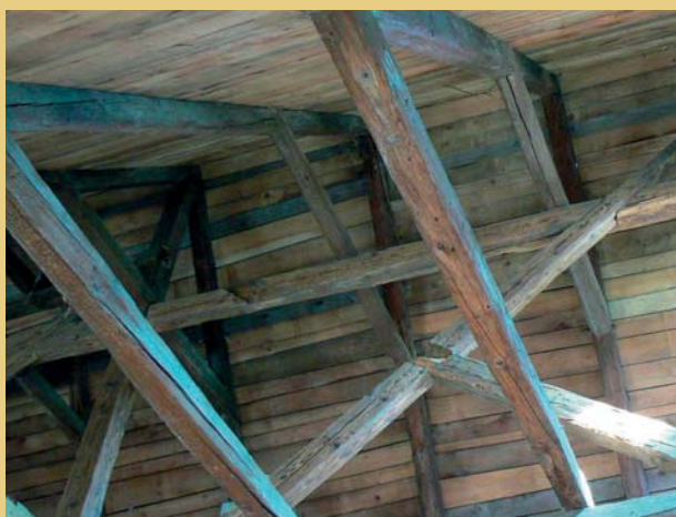
Na fotografiích vlevo stavu před opravou a vpravo po opravě jsou zřejmé dřevěné protézy tedy nastavení poškozených či chybějících částí diagonálních trámů ondřejských křížů, přičemž spoje byly zajištěny dřevěnými kolíky.
