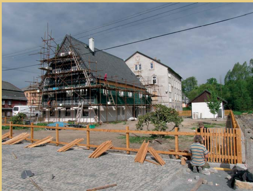
Nová dlažba z kamenných kostek na jihozápadním nároží s osazenými novými dřevěnými vraty, provedenými dle historické fotografické předlohy.
