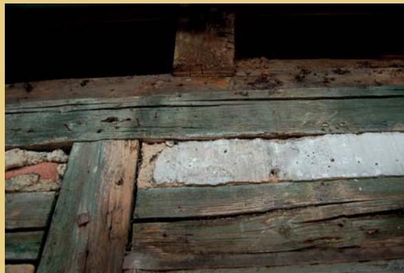
Pohled na hlavní podélné průčelí po odkrytí hrázděné konstrukce v patře (březen – květen 2012). Jak ukazuje fotografie vpravo, zdejší hrázděná pole byla dochována se starším zeleným nátěrem trámové kostry a bílou omítkou výplní.
