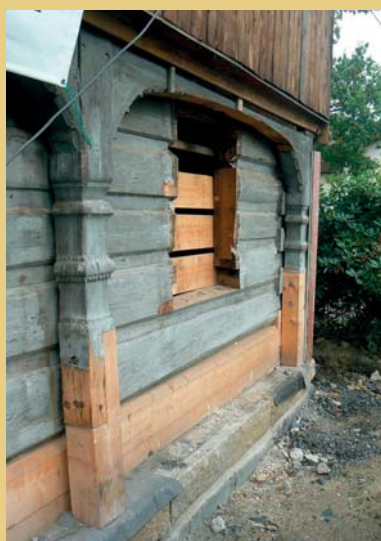
Původně bedněným obkladem zakryté a během opravy odhalené sloupky barokně ozdobně profilované podstávky bylo nutné ve spodních částech též nastavit dřevěnými protézami, vpravo je vidět z profilu stěna roubená z hraněných trámů. Sloupky podstávky je vhodné podložit např. dubovou podložkou a zajistit, aby se v patě roubených stěn nezdržovala voda.
