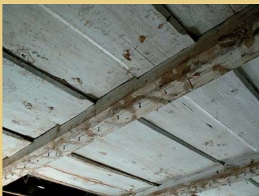
Odhalený trámových strop s prkenným záklopem zde byl očištěn od staršího vápenného nátěru.
