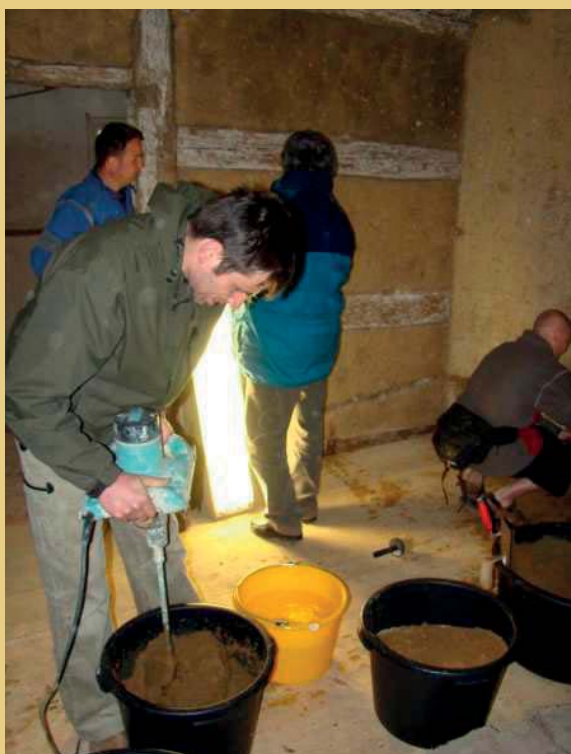
Záběry z workshopu věnovanému opravám hliněných omítek, kde německý certifikovaný řemeslník Thomas Kurze předváděl přípravu jílové omítky a její aplikaci na stěnách, přičemž účastníci si mohli práci s tímto materiálem také vyzkoušet a osvojit.
