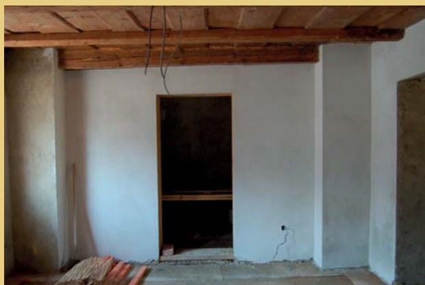
Na cihelných stěnách místností v přízemí byly obnoveny vápenné omítky a opatřeny vápennou výmalbou, viz snímek vlevo z budoucí muzejní expozice. Na pravém snímku je vstupní síň s roubenou stěnou k infocentru, která byla kvůli požadavku na zvýšení požární odolnosti dělicí stěny dvou požárních úseků opatřena oboustranně hliněnou omítkou a vápennou výmalbou.
