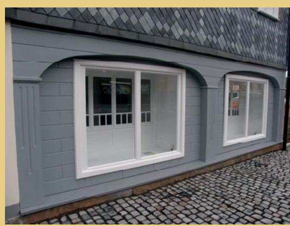
Průběh obnovy výkladců ve světlici v přízemí. Nahoře vlevo původní stav v pohledu z interiéru (2005). Na prostředních snímcích jsou patrné již nově doplněné části na místě poškozených či chybějících partií (březen 2012). Dole záběry z května 2012 po zpětné montáži výkladců.
