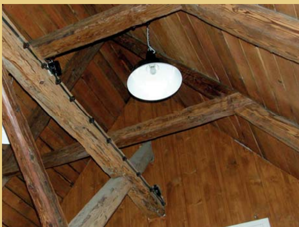
Nové elektro rozvody v černých kabelech vedené po povrchu horních partií dřevěných konstrukcí krovu.
