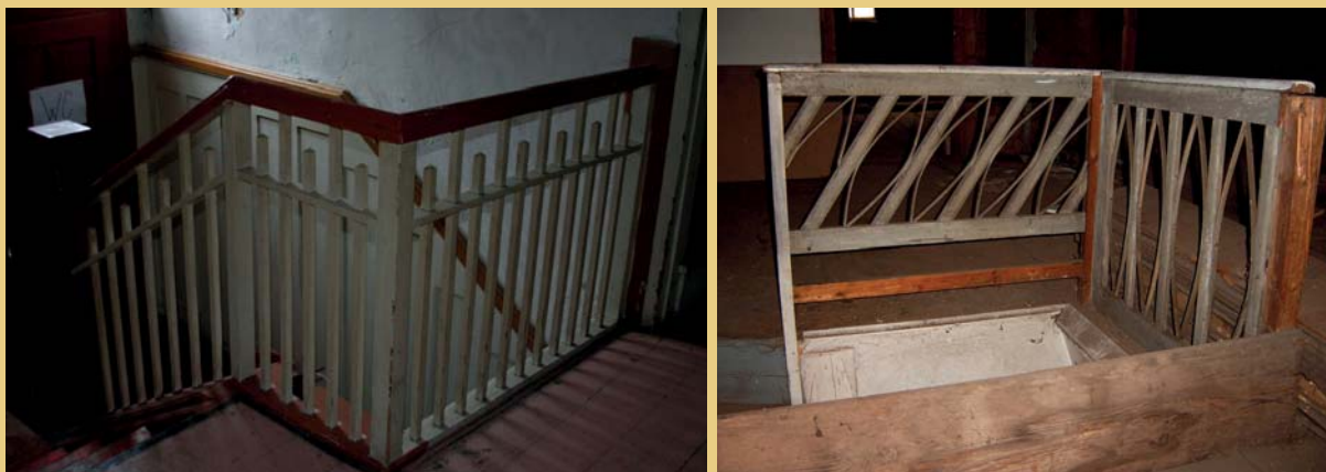
Vlevo původní podoba zábradlí schodiště v úrovni patra a vpravo zábradlí v podkroví (2010).
