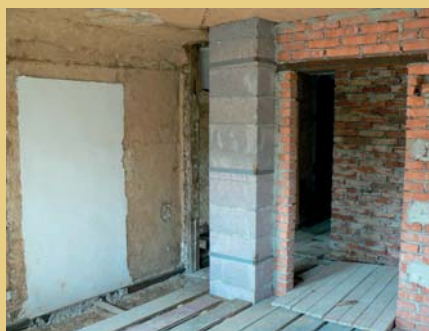
Vlevo snímek odstraněného starého komínu v přízemí západní části domu, vpravo snímky průběhu výstavby nového komínu ze systémových tvarovek v patře a podkroví ve východní části domu.
