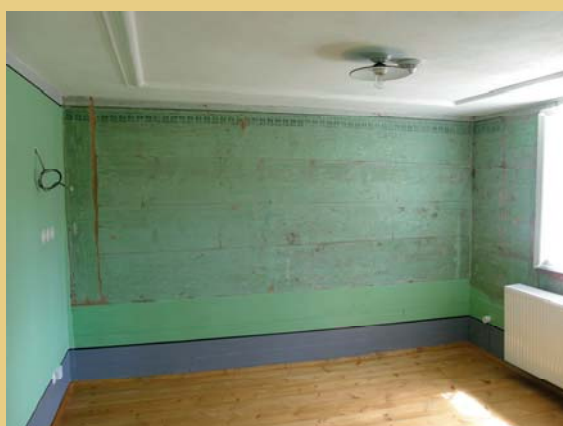
Na hladkých roubených stěnách v přízemí v budoucí kanceláři vedle infocentra byla odhalena a očištěna původní zelená šablonová výmalba, doplněná náznakově i na vyměněných trámech roubení a sousední vápenné omítky cihelné přičky, na rekonstruovaném bedněném podhledu byla provedena vápenná omítky včetně rekonstrukce profilovaného rámce dle dochovaného originálního fragmentu.
