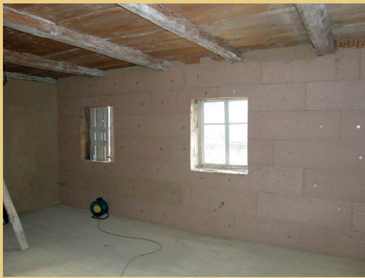
Na většinu vnějších hrázděných stěn byla obnovena nejprve vyrovnaná hliněná omítka, poté přikotvena difuzně otevřená tepelně-izolační vrstva z dřevovláknitých desek, která byla na závěr opět opatřena vnitřní hliněnou omítkou.
