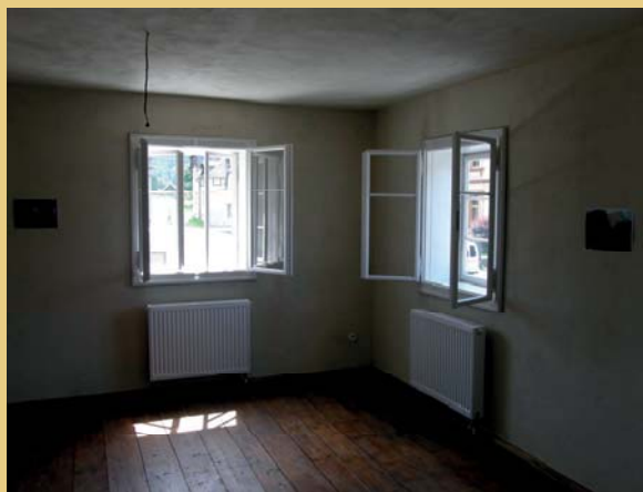
Vybrané hrázděné stěny a místnosti byly ponechány v přírodním tónu finální jílové omítky, jak je zřejmé na levém snímku s ponechaným úsekem viditelného stěnového vytápění pod omítkou v 1.08+1.09, v dalších místnostech byly hliněné omítky stěn i podhledů vymalovány ručně štětkou různými tóny bílého vápenného nátěru, např. v nárožní místnosti 1.06.
