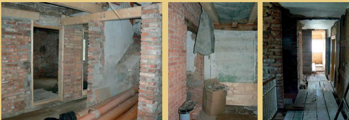
Přezdění některých nosných cihelných stěn a provedení nových dělicích příček v přízemí a v patře.
