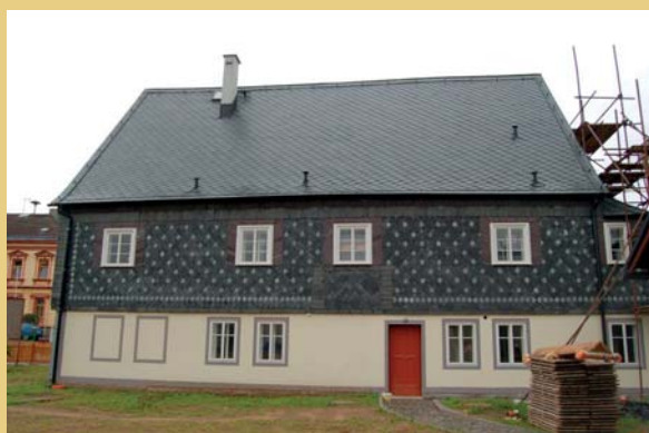
Zadní a čelní štítové průčelí do dokončení rekonstrukce břidlicového obkladu (květen - červenec 2012).
