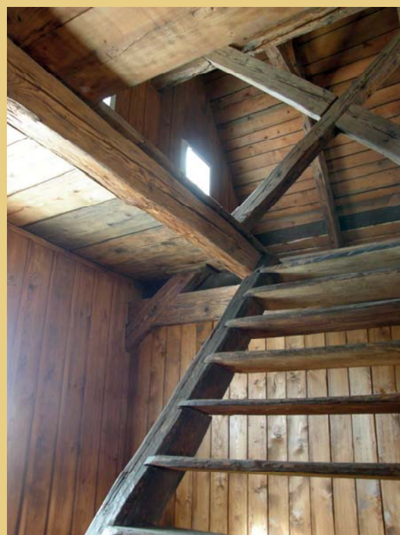
Nahoře původní stav schodiště mezi spodní a horní úrovní podkrovní (2010), dole schodiště již v posunutém poloze a po opravě (únor - červenec 2012).
