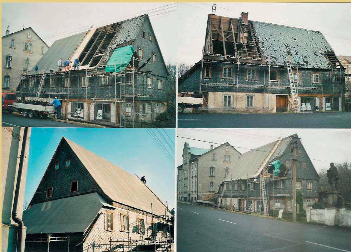
Záběry z opravy střešního pláště a výměny břidlice za vláknocementové šablony v r. 2004.
