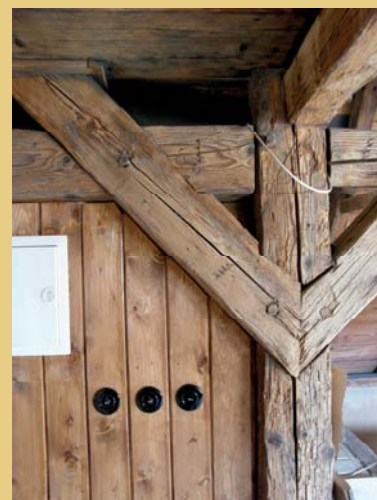
Nový vnitřní bedněný obklad štítů tvořený prkny přibíjenými na podkladní rošt na sraz, se zakrytím styčných spár masivními dřevěnými lištami s předem sraženými hranami za použití ručního hoblíku. Bednění opatřené lazurním tónovaným olejovým nátěrem, podobně jako obklad z užších prken na podkrovní vestavěné přičce toalet.
