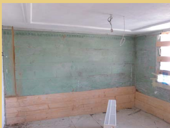
Na cihelných stěnách místností v přízemí byly obnoveny vápenné omítky a opatřeny vápennou výmalbou, viz snímek vlevo z budoucí muzejní expozice. Na pravém snímku je vstupní síň s roubenou stěnou k infocentru, která byla kvůli požadavku na zvýšení požární odolnosti dělicí stěny dvou požárních úseků opatřena oboustranně hliněnou omítkou a vápennou výmalbou.
