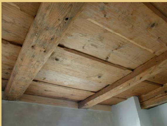
Vlevo jeden ze záklopových stropů, který zůstal po opravě viditelný s odstraněnou vápennou výmalbou a nově opatřený přírodním voskovým bezbarvým nátěrem. Vpravo byl naopak v místnosti v severovýchodní části přízemí znovu obnoven po výměně stropních trámů prkenný podhled s vápennou omítkou a rekonstruovaným profilovaným štukovým rámem s profilací dle dochovaného fragmentu původního podhledu.
