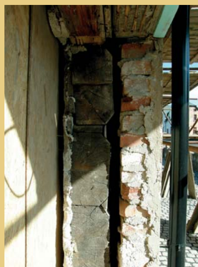
Původně bedněným obkladem zakryté a během opravy odhalené sloupky barokně ozdobně profilované podstávky bylo nutné ve spodních částech též nastavit dřevěnými protézami, vpravo je vidět z profilu stěna roubená z hraněných trámů. Sloupky podstávky je vhodné podložit např. dubovou podložkou a zajistit, aby se v patě roubených stěn nezdržovala voda.
