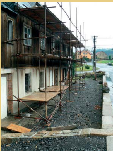
Štěrkové podkladní vrstvy na zápraží, uprostřed detail již položené dlažby z kamenných kostek na jihovýchodním nároží včetně nové dřevěné branky, plotu a kamenného obrubníku předzahrádky, vpravo osazené dřevěné sloupky na severní hranici zahrady po dokončení drenážního protipovodňového příkopu.
