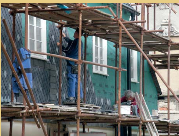
Průběh prací při rekonstrukci břidlicového obkladu, příprava nových šablon a jejich montáž (duben - květen 2012).
