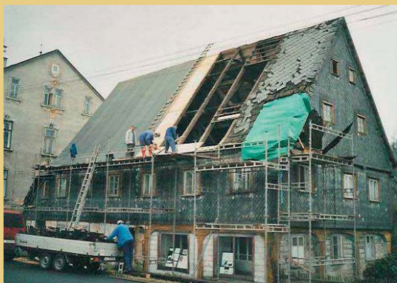
Fotografie vlevo dokumentuje demontáž břidlicové krytiny v r. 2004, vpravo stav během poslední obnovy.
