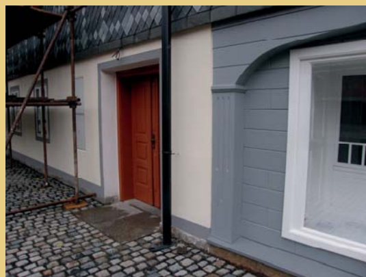
Vlevo zadní, vpravo část vstupního průčelí domu s dokončenými omítkami včetně paspart kolem oken a dveří v červenci 2012.
