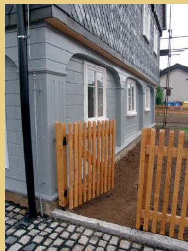
Štěrkové podkladní vrstvy na zápraží, uprostřed detail již položené dlažby z kamenných kostek na jihovýchodním nároží včetně nové dřevěné branky, plotu a kamenného obrubníku předzahrádky, vpravo osazené dřevěné sloupky na severní hranici zahrady po dokončení drenážního protipovodňového příkopu.
