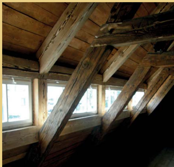
Vlevo ještě novodobá konstrukce vikýře v podobě štiny z poslední opravy střechy v roce 2002, vpravo nyní nově realizovaná konstrukce vikýře s krokvemi osedlanými na vnitřní straně horní nadokenní vaznice vikýře, s doplněným chybějícím koncem jednoho z hambalků krovu.
