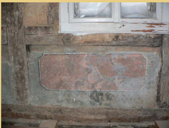
Snímky po odhalení hrázděné malované stěny v severovýchodním koutu prvního patra, skryté hliněnou vnitřní omítkou. Detail výzdoby podokenního pole a záběr z postupu oprav a restaurování (dřevěné fošny zajišťují vrácení hliněný fabion).
