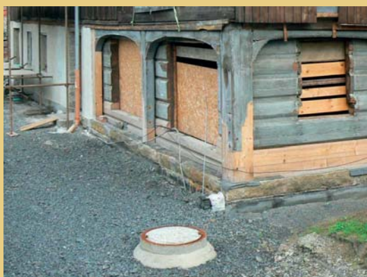
Šachta venkovní dešťové kanalizace, odvodňující střešní svody a vpusti v dlažbě. Vpravo zařízená toaleta v podkroví.
