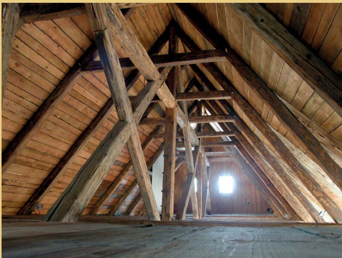
Snímek z obnovené podlahy půdičky na hambalcích při západním štítu směrem do horní východní části krovu.
