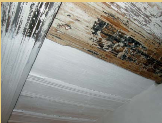
Vlevo poškozená část viditelného záklopového stropu ve světnici v přízemí, vpravo po očištění horních nesoudržných vrstev byl obnoven souvislý bílý krycí nátěr celého stropu.
