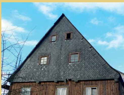
Původní břidlicový obklad čelního štítu na snímcích z listopadu r. 2010.
