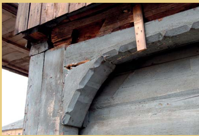
Jedním z nálezů zjevných po odhalení obkladu jsou stopy po šikmých dřevěných pásících starší formy podstávky, která předcházela stávající dochované zdobné formě.
