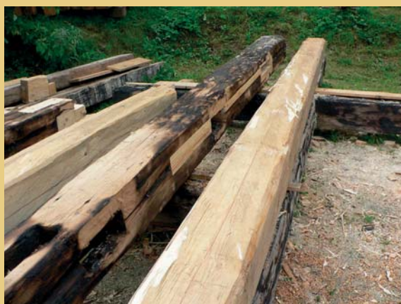
Příklad použití ručně tesaných trámů při obnově vyhořelé zvonice v areálu kostela sv. Jakuba Většího v Železném Brodě (okr. Jablonec nad Nisou, Liberecký kraj). U prostředního trámu z původní rozebrané konstrukce je nahrubo dokončeno otesání ohořelé krusty a dřevěné plomby poškozených míst (vločka na dřevěné kolíčky). Trám byl zpětně použit v obnovené konstrukci. Na pravém snímku je ukázka ručního tesání trámů při Dni otevřených podstávkových domů v Lipové v roce 2012 v podání certifikovaných tesařů Tesařské huti Romana Kloučka.
