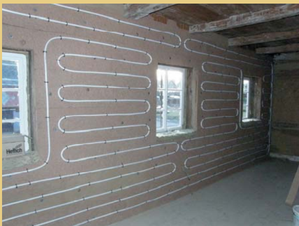
V expoziční místnosti 1.08+1.09 bylo na vnitřní dřevovláknitou izolaci vnější hrázděné stěny také přikotveno potrubí stěnového teplovodního vytápění, a to bylo poté přes výztužnou síťku opět nahozeno již finální dvouvrstvou hliněnou omítkou.
