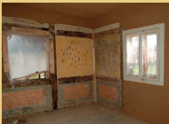
Detail z restaurátorsky zajištěného fragmentu výmalby na dřevěné konstrukci hrázdění, vpravo snímek po doplnění okolních hliněných omítek.
