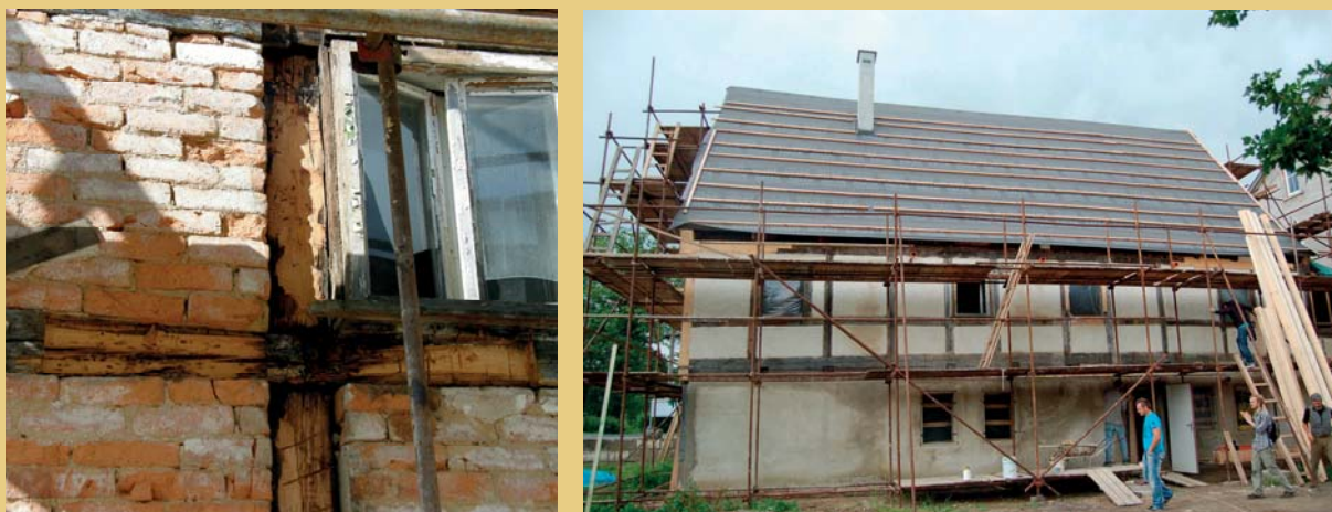
Trámy při severovýchodním nároží byly s ohledem na výskyt hodnotné výmalby vyřezány pouze v části profilu z vnější strany a opraveny novými dřevěnými plombami. Snímek vpravo zachycuje stav po obnově nosné konstrukce i vápenných omítek výplní.
