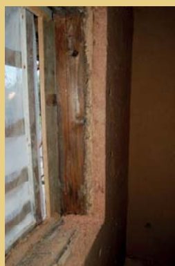
Na většinu vnějších hrázděných stěn byla obnovena nejprve vyrovnaná hliněná omítka, poté přikotvena difuzně otevřená tepelně-izolační vrstva z dřevovláknitých desek, která byla na závěr opět opatřena vnitřní hliněnou omítkou.
