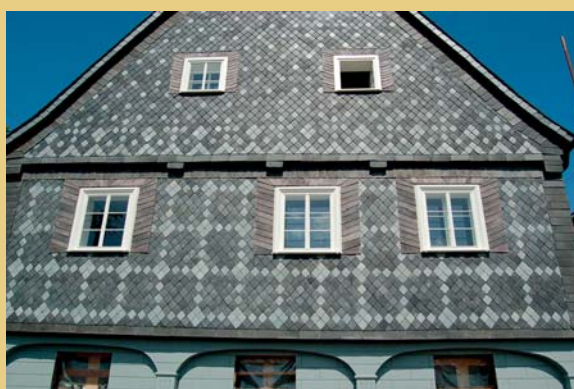
Zadní a čelní štítové průčelí do dokončení rekonstrukce břidlicového obkladu (květen - červenec 2012).
