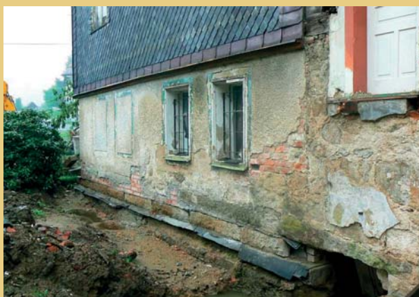
Provedení souvislé hydroizolace pod zděnými stěnami severní fasády domu z důvodu vysoké hladiny spodní vody.
