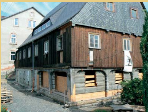
Po sejmutí a uložení břidlicového obkladu patra a po odstranění prkenného bednění se odhalily hrázděné stěny.
