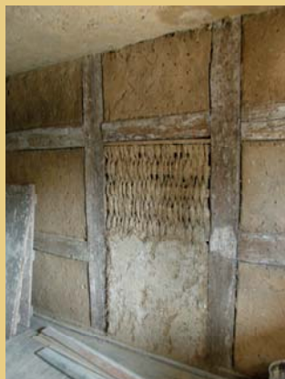
Vlevo hrázděná stěna pod vnitřními omítkami, uprostřed odhalený slaměný výplet druhotně zaslepeného vstupního otvoru, vpravo provedené opravy hliněných omítek polí západní hrázděné stěny.
