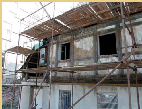
Po sejmutí a uložení břidlicového obkladu patra a po odstranění prkenného bednění se odhalily hrázděné stěny.
