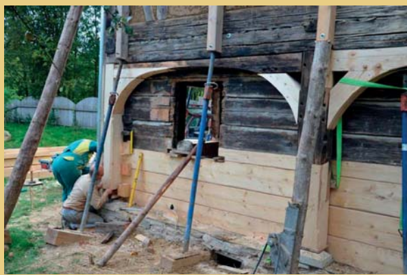
Příklad heverování hrázděného patra a stropu, výměny spodních trámů roubené světnice a protézování a oprava konstrukce podstávky s dodržáním čepových spojů a dřevěných spojovacích hřebů (koliků) na podstávkovém domu v Jindřichovicích pod Smrkem na Frýdlantsku. Ukázka z práce tesaře Matouše Kirschnera (foto Zbyněk Vlk, 2012).
