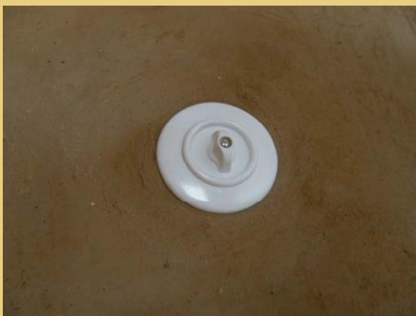
Osazení nových kruhových retro ovladačů osvětlení, na dřevěných stěnách v podkroví zvoleny v černé barvě, vpravo na hliněné omítce v patře v bílém provedení.
