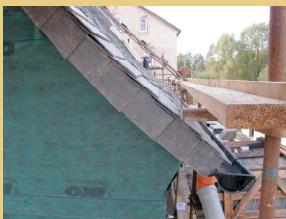
Pokládání břidlicové krytiny v srpnu a září 2011, včetně záběrů na jednotlivé řešené detaily skladby krytiny a zejména vykrytí okrajů u štítů.
