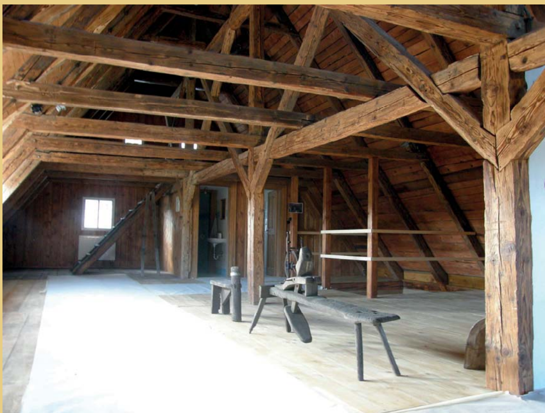
Fotografie podkrovního prostoru před dokončením nátěru dřevěných prvků přírodním bezbarvým olejem.
