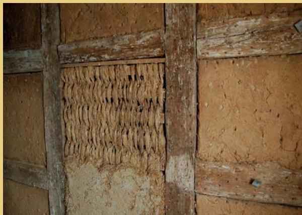
Vlevo hrázděná stěna po sejmutí vrchních omítek, vpravo odhalený slaměný výplet druhotně zaslepených dveří v hrázděné stěně, s originálními hliněnými výplněmi a omítkami polí v dřevěném skeletu.
