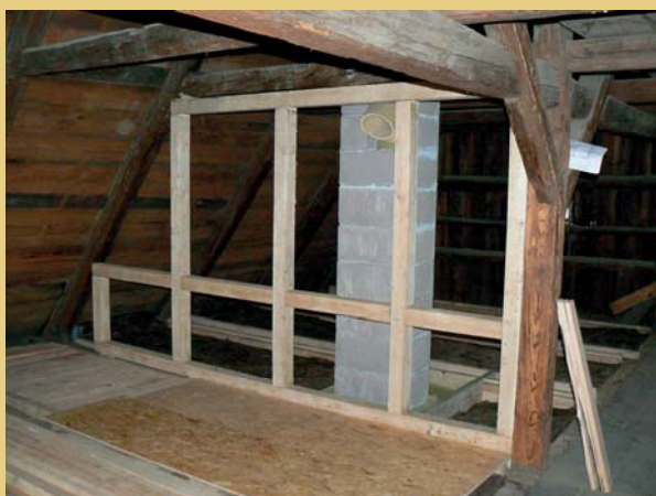
Ve východní části podkroví byla vytvořena nová hrázděná přička s vyzdívkou z nepálených hliněných cihel.
