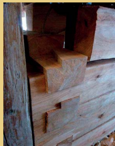
Příklad opravy roubeného přízemí z krušnohorské Přebuzi s použitím ručně tesaných trámů, detail zámkových spojů v nároží, ukázka z práce certifikovaných tesařů Tesařské Huti (foto tesař Roman Klouček).
