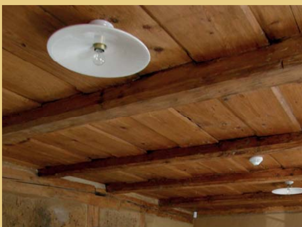
Osazení retro designových talířových svítidel na dřevěném záklopovém stropě v patře, vpravo repasované industriální svítidlo použité v technické místnosti v přízemí.
