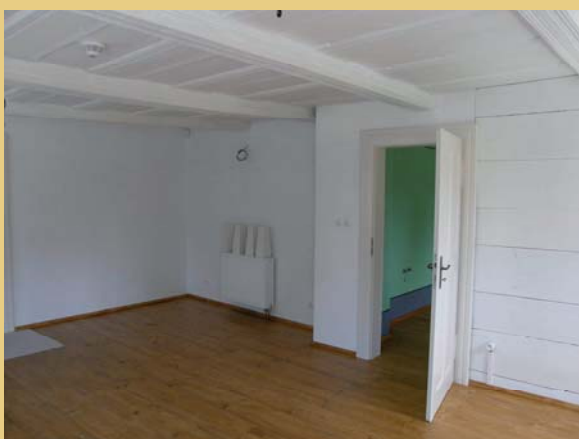
Rekonstrukce prkenných podlah v přízemní světnici a sousední místnosti, tedy v budoucím infocentru, přibarvená a opatřená tvrdým přírodním olejovým nátěrem, podél stěn připevněna profilovaná lišta (2012).
