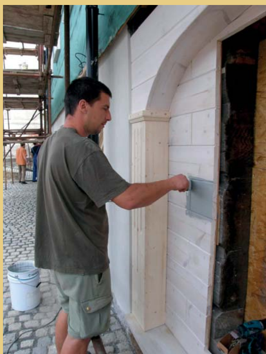
Průběh rekonstrukce dřevěného obkladu roubené světnice a světničky v červnu a červenci 2012.
