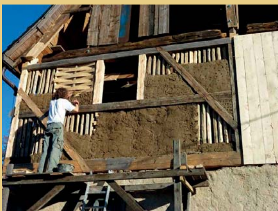
Příklad tradiční řemeslné opravy hrázděného patra krušnohorské fary v Českém Jiřetíně, tesařské protězy a výměny poškozených trámů, obnova dřevěných tyčových výplní, dřevěných výpletů a hliněných vymazávek a omítek, z referencí Tesařské huti z Karlovarska (foto certifikovaný tesař Roman Klouček).
