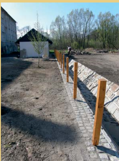
Štěrkové podkladní vrstvy na zápraží, uprostřed detail již položené dlažby z kamenných kostek na jihovýchodním nároží včetně nové dřevěné branky, plotu a kamenného obrubníku předzahrádky, vpravo osazené dřevěné sloupky na severní hranici zahrady po dokončení drenážního protipovodňového příkopu.
