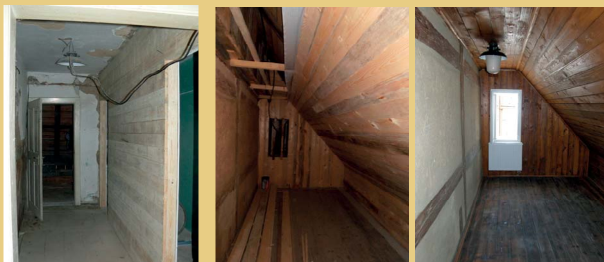
Vlevo nová dřevěná příčka úpravy dispozice pro toalety, obložená ze strany chodby prkny jako podklad pro hliněnou omítku. Zbýlé dva záběry zachycují podobu obkladu přístavby při západním štítu.
