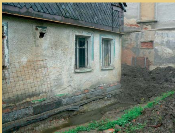
Provedení souvislé hydroizolace pod zděnými stěnami severní fasády domu z důvodu vysoké hladiny spodní vody.
