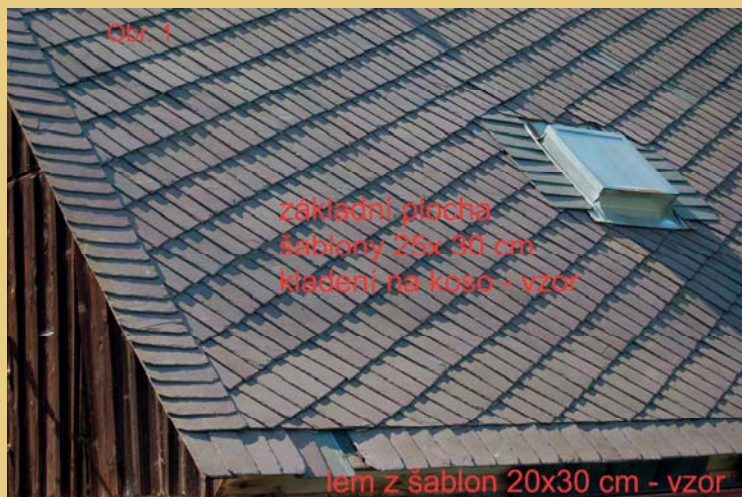
Vlevo ukázka vzoru vypracovaného pro pokládku střešní krytiny, vpravo začátek pokládky.
