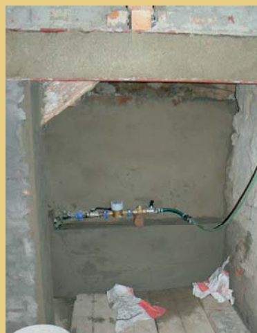
Snímky z instalace rozvodů vnitřní kanalizace v toaletách a osazení zařizovacích předmětů v koupelně. Vpravo vodovodní přípojná armatura s vodoměrem, umístěná ve výklenku pod schody do patra, přístupném z technické místnosti.
