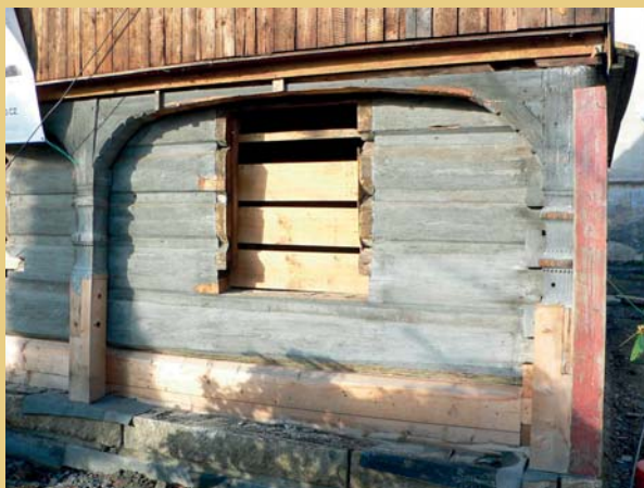
Roubená světnice po provedení výměn poškozených prvků stěn a podstávky v listopadu 2010.
