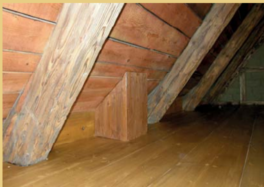
Vlevo kanalizační stoupačky, zakryté v podkroví bedněným obkladem, odvětrané na pravém snímku nad střešní krytinou v podobě plechových komínků, pod římsou zřejmé též plechové děrované kryty vyústění odvětrání toalet v patře.
