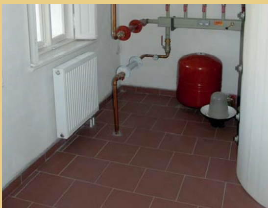
Vpravo nová prkenná podlaha před nátěrem v místnostech budoucího muzea, vlevo nová slinutá keramická dlažba terakotové barvy použitá v technické místnosti v přízemí, kladená v pásech na vazbu.
