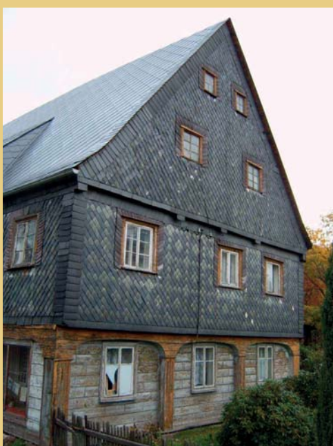
Stav břidlicového obkladu v r. 2005. Vlevo pohled na čelní štítové průčelí s nejbohatším dekorem a vpravo detail řešení okolo okenních otvorů hlavního podélného průčelí.
