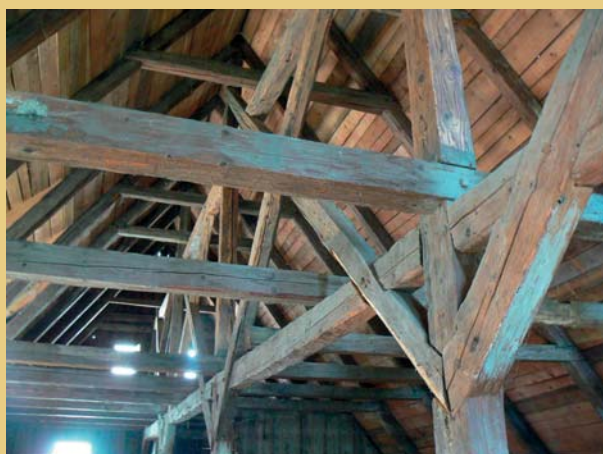
Po rozebrání prkenné podlahy na dolních hambalcích se otevřel celý prostor krovu až do vrcholu a odhalila se celá konstrukce s vysokými středními sloupy a diagonálním zavětrováním v podobě tzv. ondřejských křížů.
