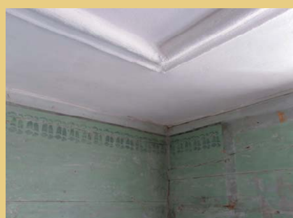
Na hladkých roubených stěnách v přízemí v budoucí kanceláři vedle infocentra byla odhalena a očištěna původní zelená šablonová výmalba, doplněná náznakově i na vyměněných trámech roubení a sousední vápenné omítky cihelné přičky, na rekonstruovaném bedněném podhledu byla provedena vápenná omítky včetně rekonstrukce profilovaného rámce dle dochovaného originálního fragmentu.
