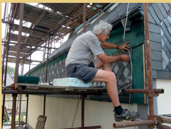
Průběh prací při rekonstrukci břidlicového obkladu, příprava nových šablon a jejich montáž (duben - květen 2012).
