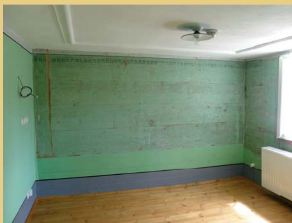
Rekonstrukce prkenných podlah v přízemní světnici a sousední místnosti, tedy v budoucím infocentru, přibarvená a opatřená tvrdým přírodním olejovým nátěrem, podél stěn připevněna profilovaná lišta (2012).
