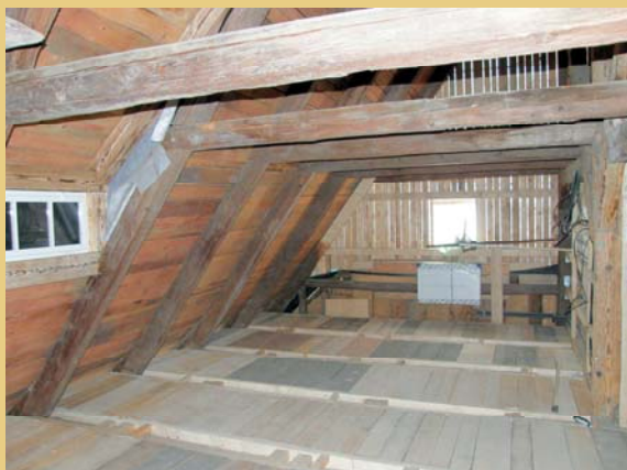
V podlaze půdního prostoru byly do podlahové konstrukce mezi vyrovnávací dřevěný rošt prkenné podlahy vloženy izolační rohože.
