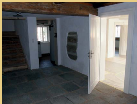
Na cihelných stěnách místností v přízemí byly obnoveny vápenné omítky a opatřeny vápennou výmalbou, viz snímek vlevo z budoucí muzejní expozice. Na pravém snímku je vstupní síň s roubenou stěnou k infocentru, která byla kvůli požadavku na zvýšení požární odolnosti dělicí stěny dvou požárních úseků opatřena oboustranně hliněnou omítkou a vápennou výmalbou.
