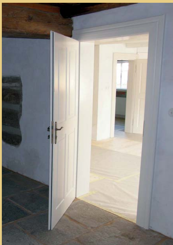
Nahoře doplňky dveří – závěsy, krabicové zámky, kliky a štítky (2012) po očištění, repasi a obnoveném grafitovém nátěru. Dole vlevo opravené dveře (někdejší vstup ze schodiště do bývalého záchodového přístavku, dole vpravo na nové „požární“ dveře do světnice (červenec 2012).
