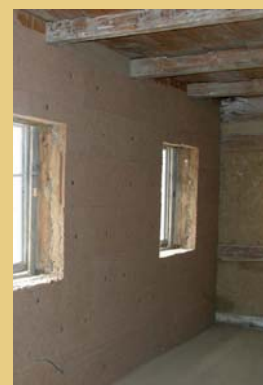
Na většinu vnějších hrázděných stěn byla obnovena nejprve vyrovnaná hliněná omítka, poté přikotvena difuzně otevřená tepelně-izolační vrstva z dřevovláknitých desek, která byla na závěr opět opatřena vnitřní hliněnou omítkou.
