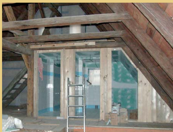
Dřevěná sloupková konstrukce nových příček podkrovního bloku toalet byla zevnitř opatřena sádkartonovým a keramickým obkladem, ze strany hlavního podkrovního prostoru byla poté obložena svisle kladeným bedněním.
