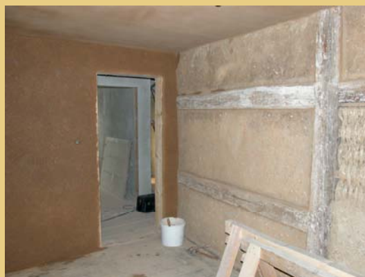
Vybrané hrázděné stěny byly ponechány v interiéru viditelné, jinak byly většinou obnoveny souvislé hliněné omítky.
