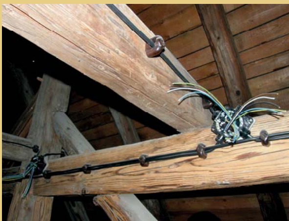
Nové elektro rozvody v černých kabelech vedené po povrchu horních partií dřevěných konstrukcí krovu.
