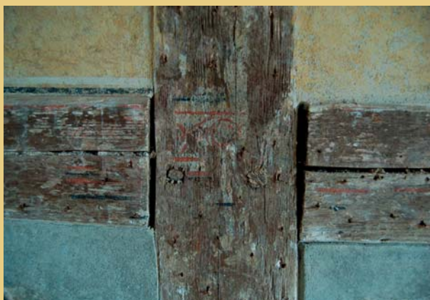
Detail z restaurátorsky zajištěného fragmentu výmalby na dřevěné konstrukci hrázdění, vpravo snímek po doplnění okolních hliněných omítek.
