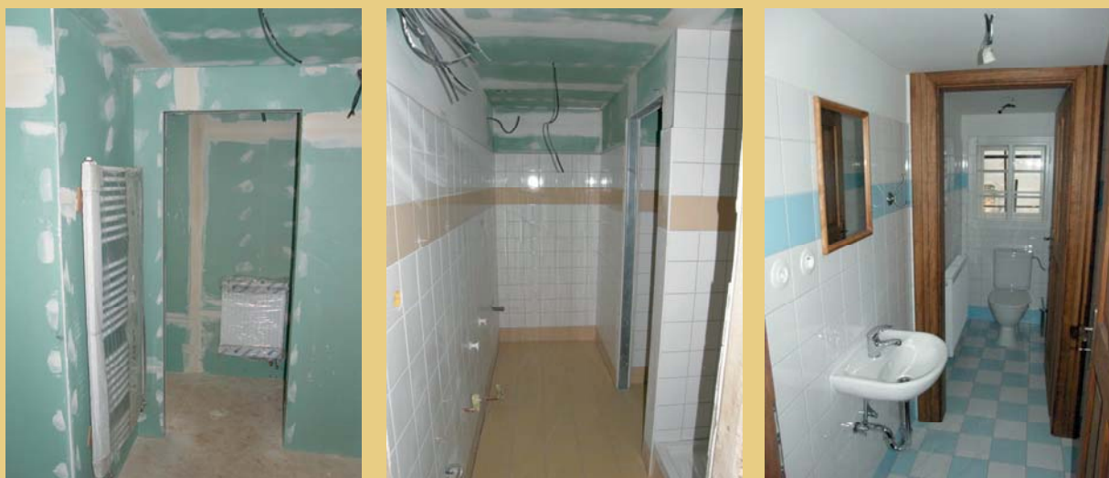
Pohledy do realizace nových přiček toalet v patře a v podkroví, opatřených sádkartonovým a keramickým obkladem.
