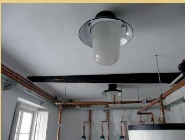
Osazení retro designových talířových svítidel na dřevěném záklopovém stropě v patře, vpravo repasované industriální svítidlo použité v technické místnosti v přízemí.
