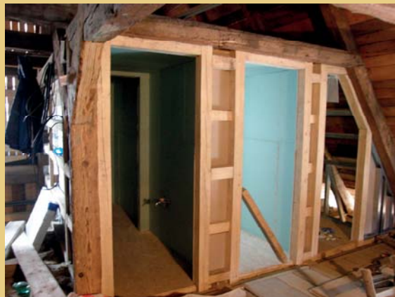
V západní části podkroví byla vytvořena nová trámková konstrukce přiček nových toalet, zevnitř obložená sádkartonem, z vnější strany pak obložena prkenným obkladem.
