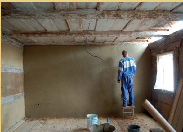
Vybrané hrázděné stěny byly ponechány v interiéru přiznané včetně dřevěné konstrukce, jinak byly většinou obnoveny souvislé hliněné omítky.
