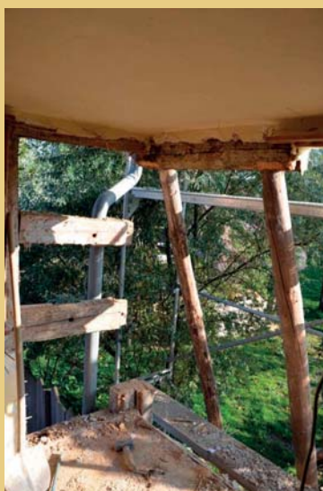
Příklad náročné tesařské opravy velmi poškozeného nároží hrázděného patra chalupy v Jindřichovicích pod Smrkem na Frýdlantsku s použitím tradičních řemeslných postupů a obnovení tyčových výplní a hliněných vymazávek (foto Zbyněk Vlček, 2012).
