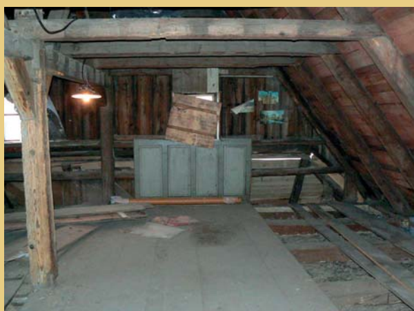
Stav prostoru krovu při zahájení prací, na snímcích při západním štítu ještě zjevná bedněná půdní komora, zábradlí někdejšího strmého schodiště z patra, žebříkové schody na první hambalky a vážně poškozený vazný trám západního štítu.
