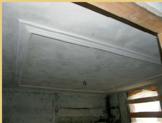
Vlevo jeden ze záklopových stropů, který zůstal po opravě viditelný s odstraněnou vápennou výmalbou a nově opatřený přírodním voskovým bezbarvým nátěrem. Vpravo byl naopak v místnosti v severovýchodní části přízemí znovu obnoven po výměně stropních trámů prkenný podhled s vápennou omítkou a rekonstruovaným profilovaným štukovým rámem s profilací dle dochovaného fragmentu původního podhledu.
