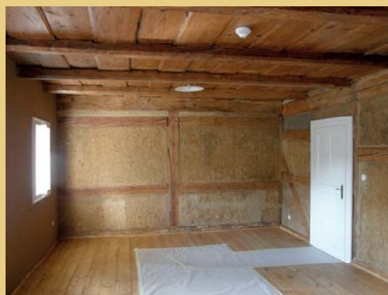
Přírodní voskové a olejové nátěry na dřevěných střepech a viditelných trámech hrázděných stěn.
