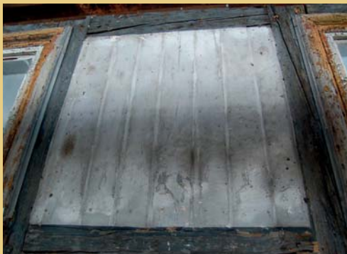
Odhalená hrázděná stěna s vápennou omítkou na výplních dřevěné konstrukce.
