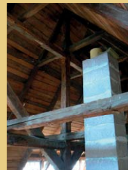
Vlevo snímek odstraněného starého komínu v přízemí západní části domu, vpravo snímky průběhu výstavby nového komínu ze systémových tvarovek v patře a podkroví ve východní části domu.
