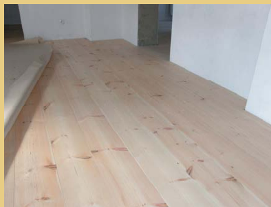
Vpravo nová prkenná podlaha před nátěrem v místnostech budoucího muzea, vlevo nová slinutá keramická dlažba terakotové barvy použitá v technické místnosti v přízemí, kladená v pásech na vazbu.
