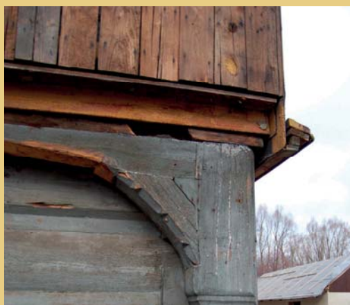
Jedním z nálezů zjevných po odhalení obkladu jsou stopy po šikmých dřevěných pásících starší formy podstávky, která předcházela stávající dochované zdobné formě.
