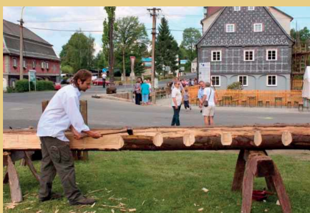
Příklad použití ručně tesaných trámů při obnově vyhořelé zvonice v areálu kostela sv. Jakuba Většího v Železném Brodě (okr. Jablonec nad Nisou, Liberecký kraj). U prostředního trámu z původní rozebrané konstrukce je nahrubo dokončeno otesání ohořelé krusty a dřevěné plomby poškozených míst (vločka na dřevěné kolíčky). Trám byl zpětně použit v obnovené konstrukci. Na pravém snímku je ukázka ručního tesání trámů při Dni otevřených podstávkových domů v Lipové v roce 2012 v podání certifikovaných tesařů Tesařské huti Romana Kloučka.
