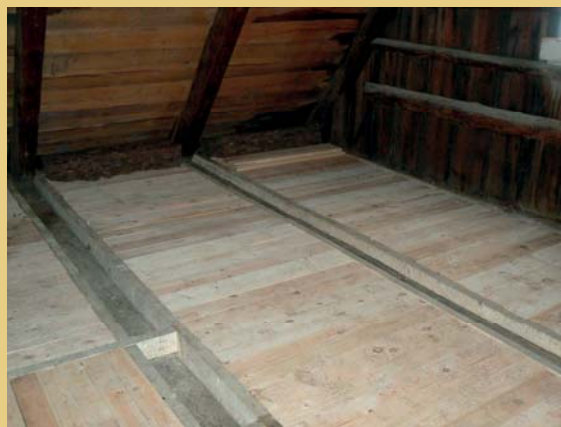
V podlaze půdního prostoru byly do podlahové konstrukce mezi vyrovnávací dřevěný rošt prkenné podlahy vloženy izolační rohože.
