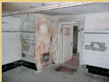
Vlevo snímek odstraněného starého komínu v přízemí západní části domu, vpravo snímky průběhu výstavby nového komínu ze systémových tvarovek v patře a podkroví ve východní části domu.
