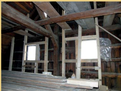
Provádění dřevěného trémkového roštu na vnitřní straně bedněných štítů krovu, který byl vyplněn tepelně izolačními rohožemi a obložen z interiéru novým bedněním.
