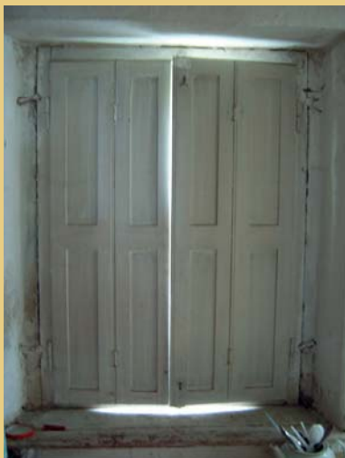
Vlevo původní podoba oken s okenicí v zadním traktu v přízemí objektu (r. 2005), vpravo snímek po osazení oken (vnitřní křídla původní, venkovní nová) a opravených okenic (prosinec 2011).
