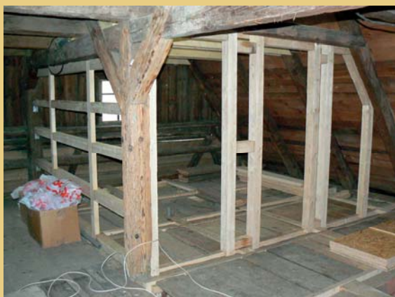
V západní části podkroví byla vytvořena nová trámková konstrukce přiček nových toalet, zevnitř obložená sádkartonem, z vnější strany pak obložena prkenným obkladem.
