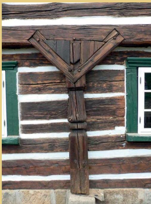
Žďár č. p. 10 (okr. Česká Lípa, Liberecký kraj) – příklad zdařilé citlivé obnovy poškozeného roubení světnice a podstávky, provedené v r. 2010. Vlevo fotografie původního stavu, vpravo snímek po dokončení opravy podezdívky, výměny spodní trámů a nastavení uhnílého konce sloupky podstávky. Trámy byly vizuálně sjednoceny nátěrem na bázi voskových olejů.
