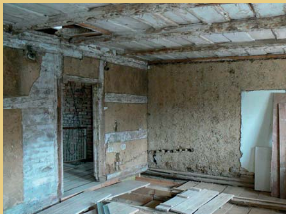
Vlevo hrázděná stěna po sejmutí vrchních omítek, vpravo odhalený slaměný výplet druhotně zaslepených dveří v hrázděné stěně, s originálními hliněnými výplněmi a omítkami polí v dřevěném skeletu.
