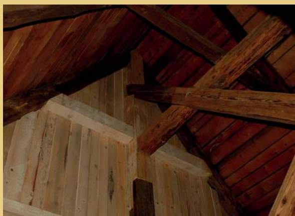
Vlevo realizovaná výměna horního hambalku a protěza horního konce středního sloupu na zadním západním štítu, vpravo provedené nastavení konce jedné z krokví při jižní okapové straně, zároveň viditelné posílení stropních/vazných trámů fošnovými příložkami, které zároveň tvoří rošt pro položení nové prkenné podlahy.
