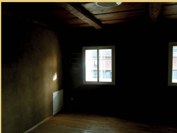
Vybrané hrázděné stěny a místnosti byly ponechány v přírodním tónu finální jílové omítky, jak je zřejmé na levém snímku s ponechaným úsekem viditelného stěnového vytápění pod omítkou v 1.08+1.09, v dalších místnostech byly hliněné omítky stěn i podhledů vymalovány ručně štětkou různými tóny bílého vápenného nátěru, např. v nárožní místnosti 1.06.
