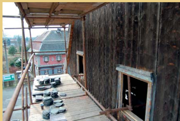
Na snímku vlevo vrchol lomenice čelního štítu po demontáži břidlice v dubnu r. 2011. Fotografie vpravo zachycuje proces demontování břidlice ze štítu a mezideponii a třídění na podlážkách lešení.
