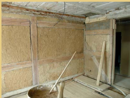
Vybrané hrázděné stěny byly ponechány v interiéru viditelné, jinak byly většinou obnoveny souvislé hliněné omítky.
