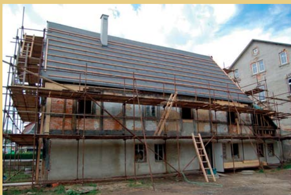
Pohled na zadní podélné průčelí domu po odkrytí hrázděné konstrukce v patře (03-05/2012). Jak ukazuje fotografie vpravo, zdejší hrázděná pole byla dochována s mladším šedomodrým nátěrem trámové kostry a světle šedými omítkami výplní se sytější linkou po obvodu. Na celkovém snímku jsou patrná místa s cihelnými výplněmi, zejména se jedná o malovanou světnici o třech polích zcela vlevo a patrně mladší úpravy některých polí vpravo. Zbýlá část má výplně tyčoviny, slaměného výpletu a hliněné mazaniny.
