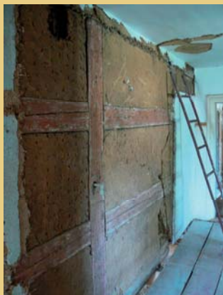
Vlevo hrázděná stěna pod vnitřními omítkami, uprostřed odhalený slaměný výplet druhotně zaslepeného vstupního otvoru, vpravo provedené opravy hliněných omítek polí západní hrázděné stěny.
