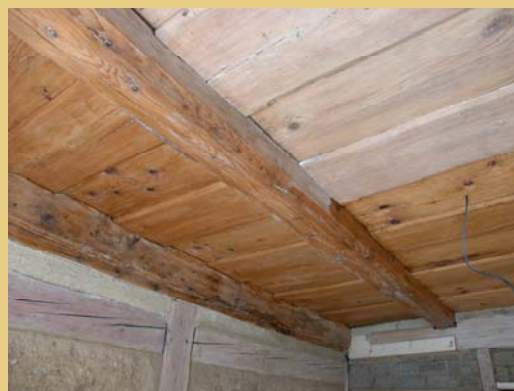
Odhalený trámových strop s prkenným záklopem zde byl očištěn od staršího vápenného nátěru.
