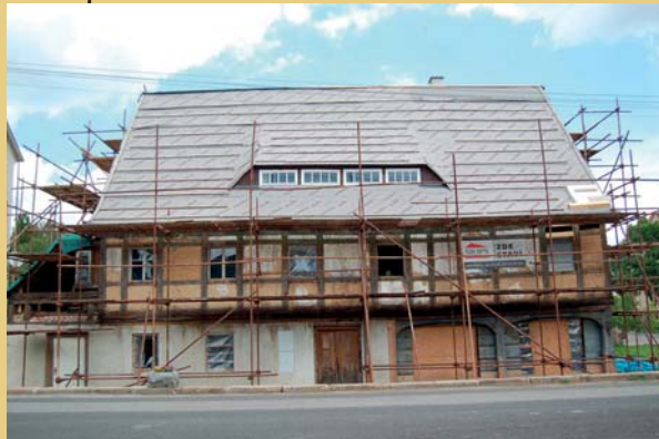
Pohled na hlavní podélné průčelí po odkrytí hrázděné konstrukce v patře (březen – květen 2012). Jak ukazuje fotografie vpravo, zdejší hrázděná pole byla dochována se starším zeleným nátěrem trámové kostry a bílou omítkou výplní.
