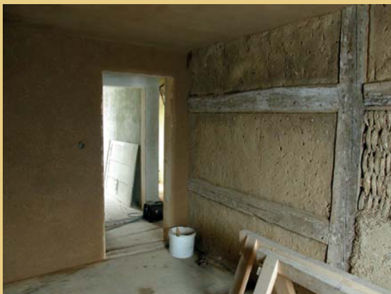
Vybrané hrázděné stěny byly ponechány v interiéru přiznané včetně dřevěné konstrukce, jinak byly většinou obnoveny souvislé hliněné omítky.
