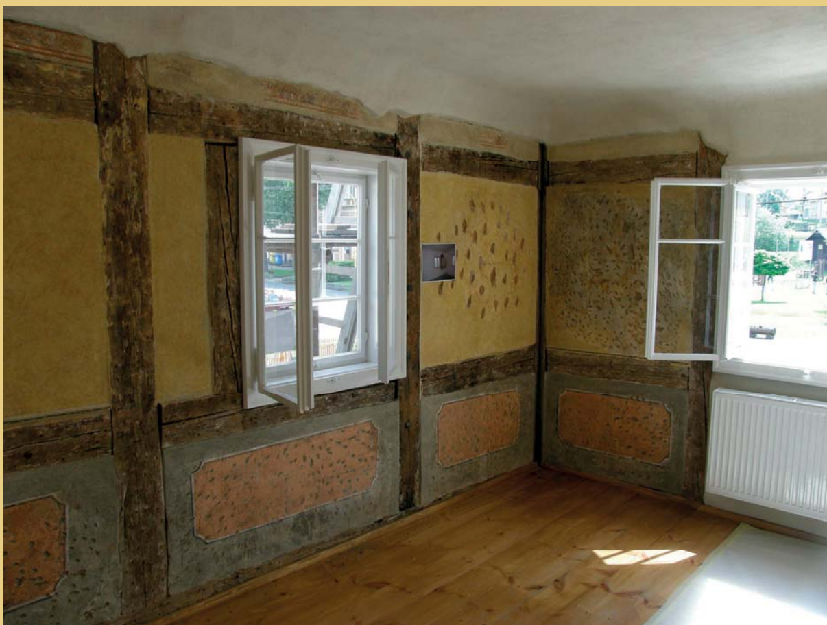
Podoba místnosti po dokončeném restaurování výmalby hrázděné stěny a celkové úpravě místnosti, která spočívala v obnovení hliněných omítek na stropě a partiích stěn s nedochovanou výmalbou, osazení nových oken a provedení nové dřevěné podlahy.
