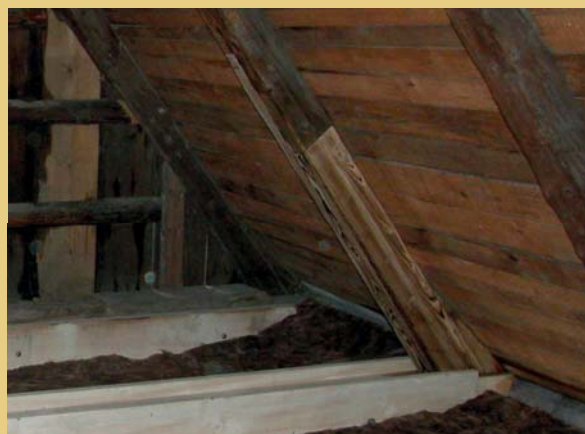
Vlevo realizovaná výměna horního hambalku a protěza horního konce středního sloupu na zadním západním štítu, vpravo provedené nastavení konce jedné z krokví při jižní okapové straně, zároveň viditelné posílení stropních/vazných trámů fošnovými příložkami, které zároveň tvoří rošt pro položení nové prkenné podlahy.
