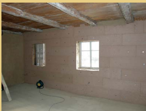
Na většinu vnějších hrázděných stěn byla obnovena nejprve vyrovnaná hliněná omítka, poté přikotvena difuzně otevřená tepelně-izolační vrstva z dřevovláknitých desek, která byla na závěr opět opatřena vnitřní hliněnou omítkou.
