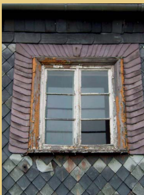
Stav břidlicového obkladu v r. 2005. Vlevo pohled na čelní štítové průčelí s nejbohatším dekorem a vpravo detail řešení okolo okenních otvorů hlavního podélného průčelí.
