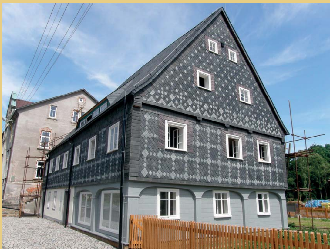
Informační centrum v Krajině podstávkových domů v Lipové u Šluknova před dokončením.
