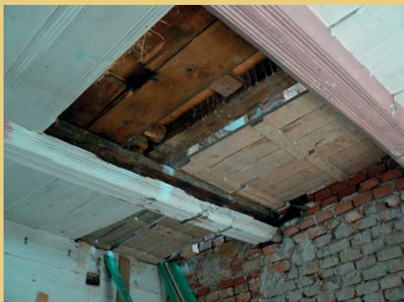
Vlevo poškozená část viditelného záklopového stropu ve světnici v přízemí, vpravo po očištění horních nesoudržných vrstev byl obnoven souvislý bílý krycí nátěr celého stropu.
