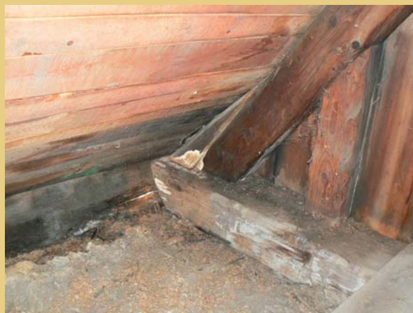
Snímky stropů a prkenných záklopů s místy poškození způsobenými dlouhodobým zatékáním střešní krytinou při jižním průčelí (vlevo) a v severovýchodním nároží (vpravo).
