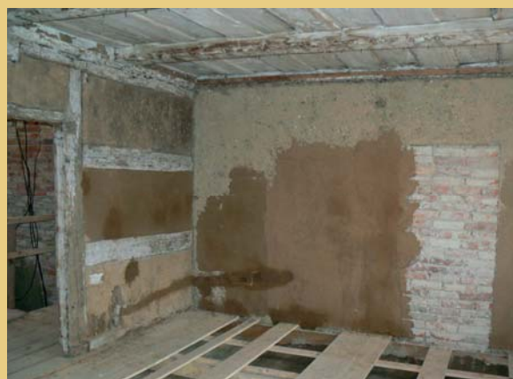
Vlevo hrázděná stěna po sejmutí vrchních omítek, vpravo odhalený slaměný výplet druhotně zaslepených dveří v hrázděné stěně, s originálními hliněnými výplněmi a omítkami polí v dřevěném skeletu.
