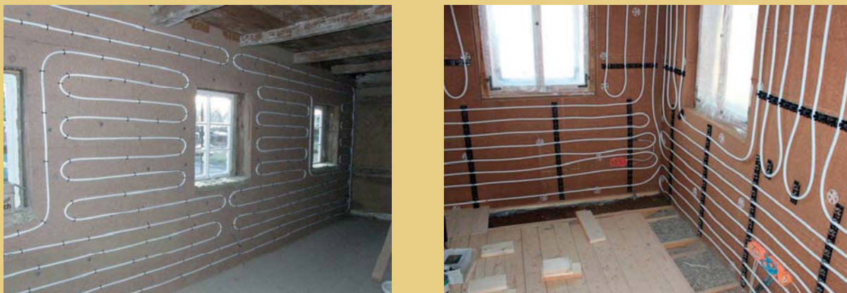
Vlevo stěnového vytápění instalované na hrázděné stěně izolované dřevovláknitými deskami domu v Lipové, vpravo obdobné řešení provedené při paralelně opravovaném domě v Cunewalde.
