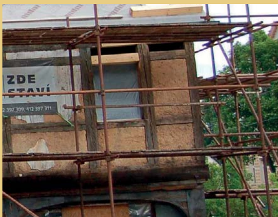
Po dokončení tesařských oprav byly doplněny poškozené dřevohliněné výplně polí a opraveny vápenné omítky.
