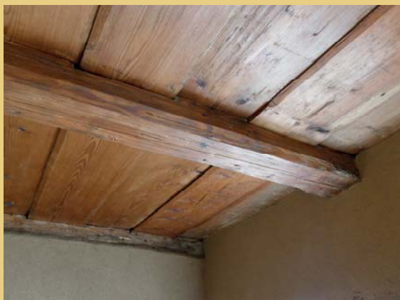
Přírodní voskové a olejové nátěry na dřevěných střepech a viditelných trámech hrázděných stěn.
