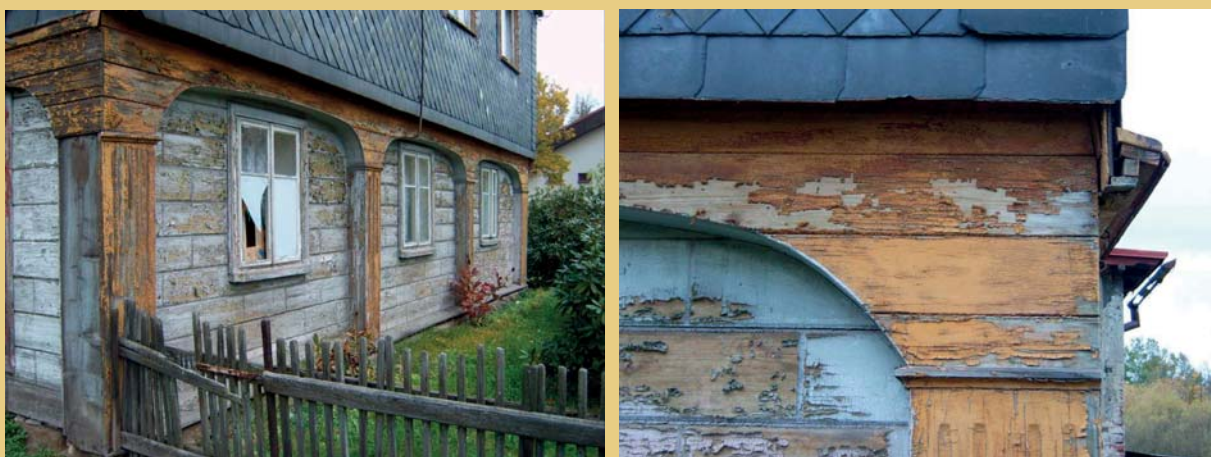
Vlevo pohled na štitovou stěnu s roubenou světnicí opatřenou dřevěným obkladem. Vpravo detail z hlavního podélného průčelí při pravém nároží. Stav k roku 2005.
