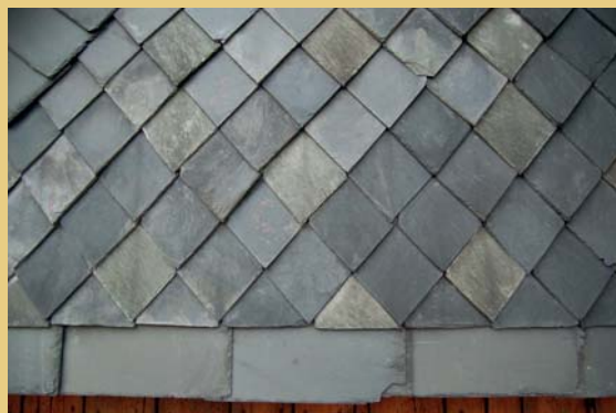
Původní břidlicový obklad čelního štítu na snímcích z listopadu r. 2010.
