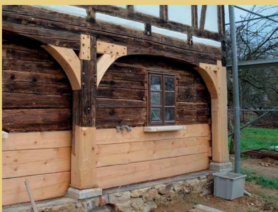
Vlevo detail opravy roubení a protéz podstávky opět z Jindřichovic, vpravo náročné protézování roubeného nároží z Horních Chobolic jako ukázka práce týmu certifikovaného tesaře Tomáše Hlaváčka.
