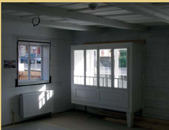
Průběh obnovy výkladců ve světlici v přízemí. Nahoře vlevo původní stav v pohledu z interiéru (2005). Na prostředních snímcích jsou patrné již nově doplněné části na místě poškozených či chybějících partií (březen 2012). Dole záběry z května 2012 po zpětné montáži výkladců.
