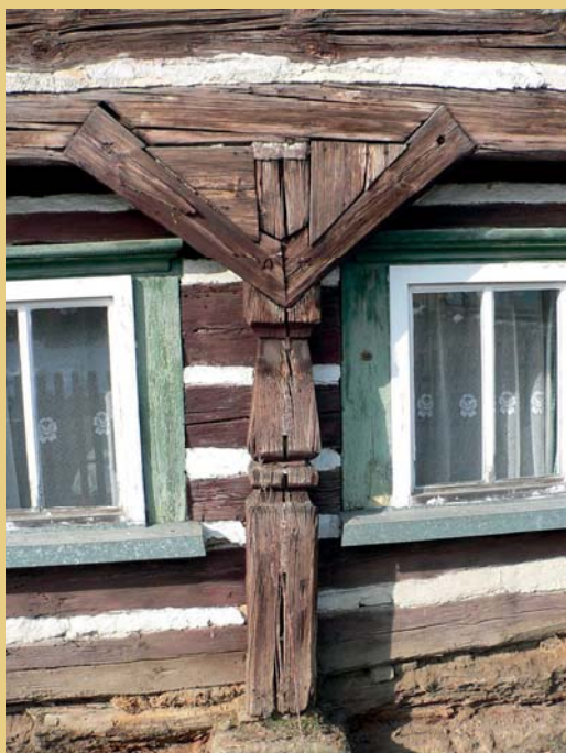
Žďár č. p. 10 (okr. Česká Lípa, Liberecký kraj) – příklad zdařilé citlivé obnovy poškozeného roubení světnice a podstávky, provedené v r. 2010. Vlevo fotografie původního stavu, vpravo snímek po dokončení opravy podezdívky, výměny spodní trámů a nastavení uhnílého konce sloupky podstávky. Trámy byly vizuálně sjednoceny nátěrem na bázi voskových olejů.
