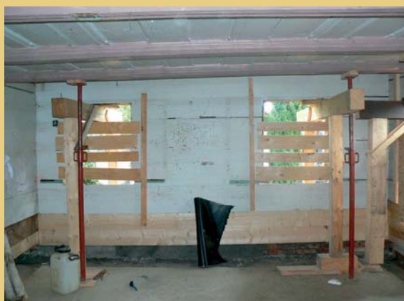
Heverování trámového stropu světnice a roubených stěn přízemí objektu na jaře roku 2010, které umožnilo tesařskou opravu a výměnu poškozených spodních trámů roubených stěn.
